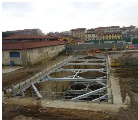
Pozzo di ventilazione Nord
