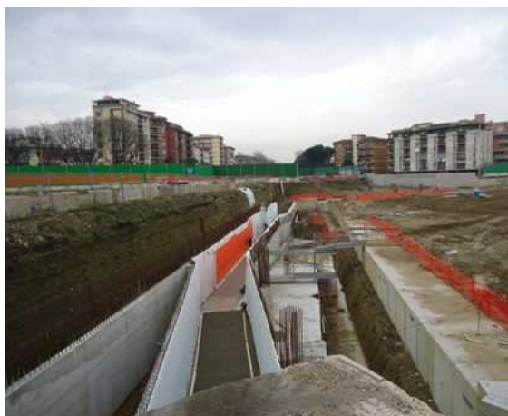
Realizzazione Energy Center
