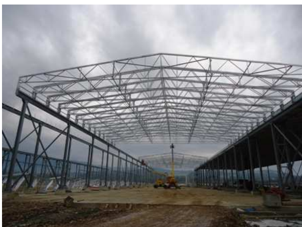
Vista delle capriate della copertura
