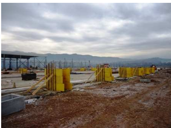
Piazzole di stoccaggio in fase di realizzazione
