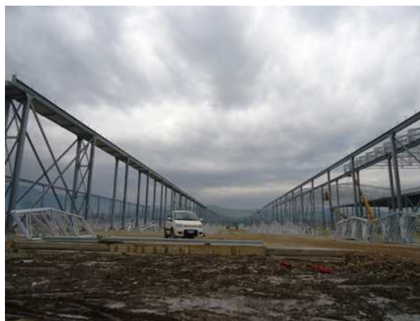
Struttura verticale della copertura
