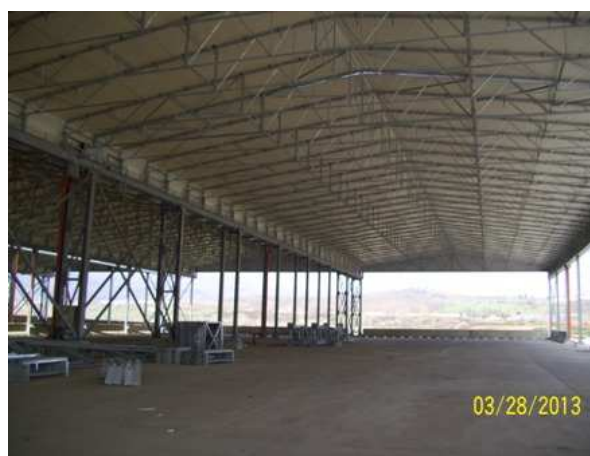
Piazzole di stoccaggio terre
