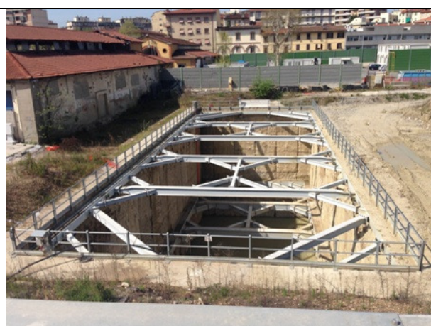
Pozzo di ventilazione Nord
