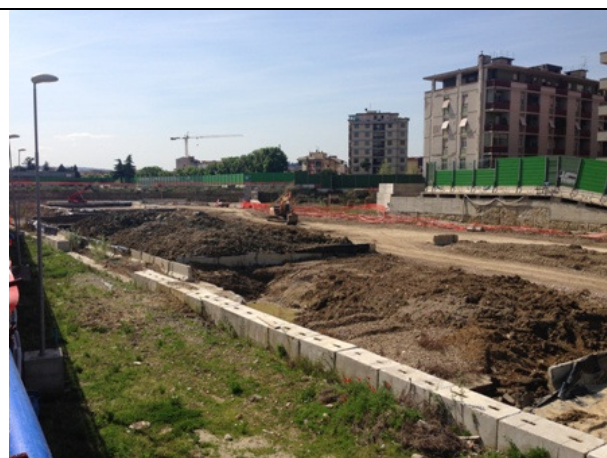
Area Camerone - vista zona Sud
