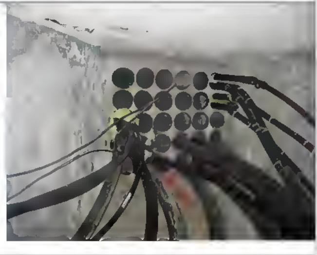
Polifora da sostituire – Tratto lato Milton
