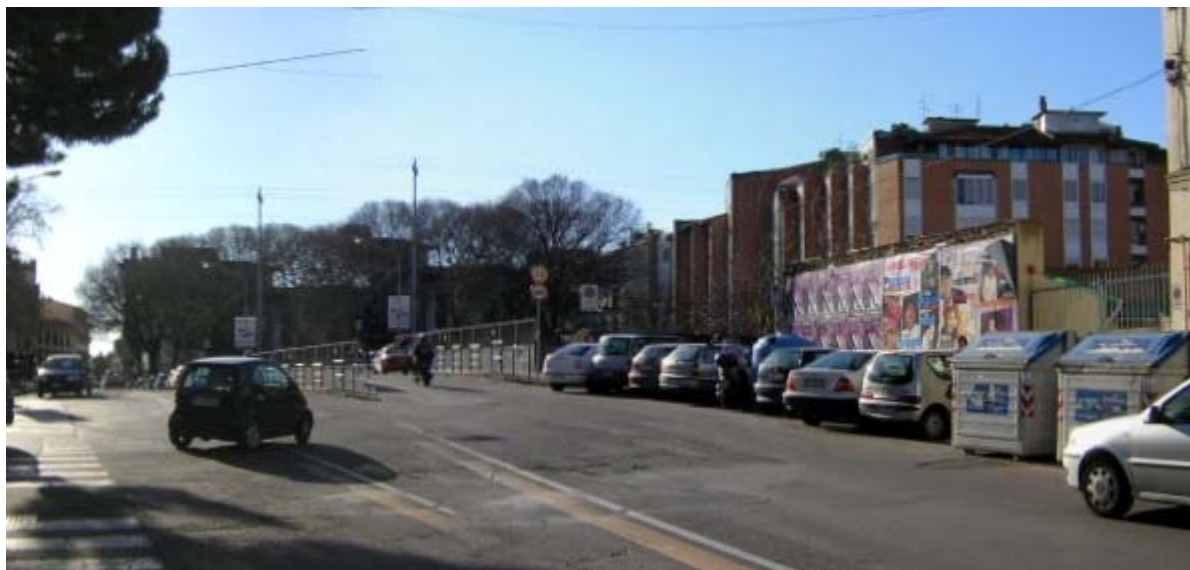
Vista del ponte al Pino e della sede stradale occupata per la realizzazione dell'intervento di sottofondazione.
