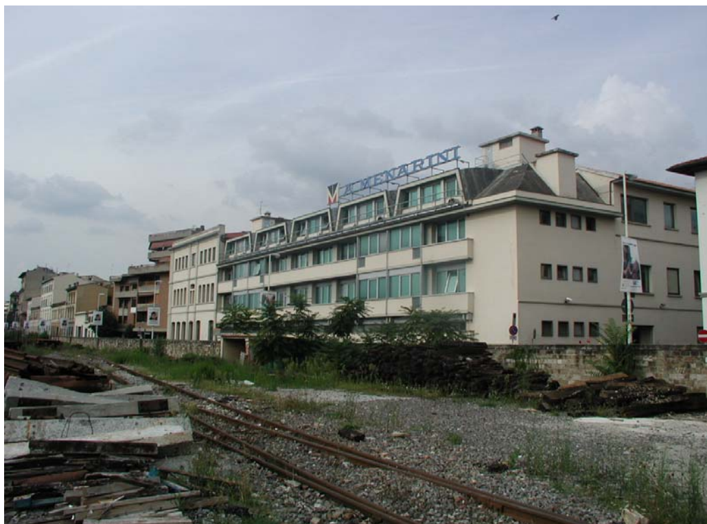
Vista dell'area cantiere di Campo di Marte
