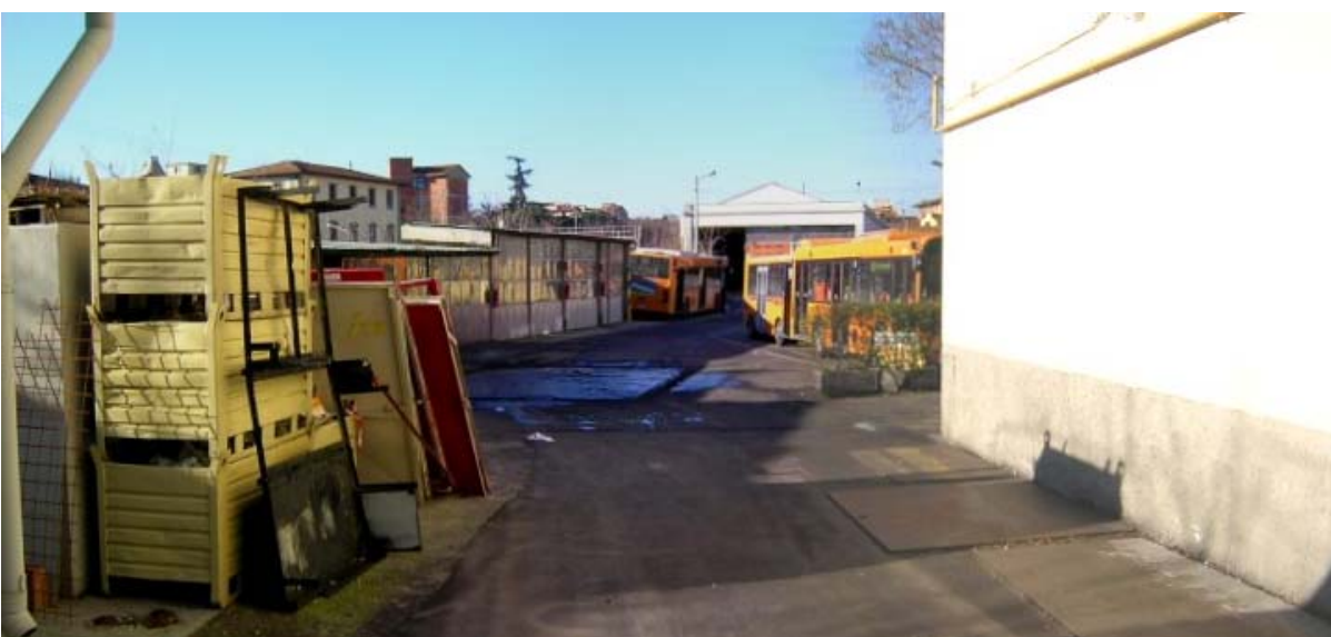
Vista dell'area di intervento del pozzo 6.
