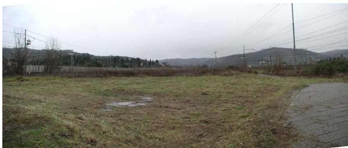
Vista dell'area di cantiere
