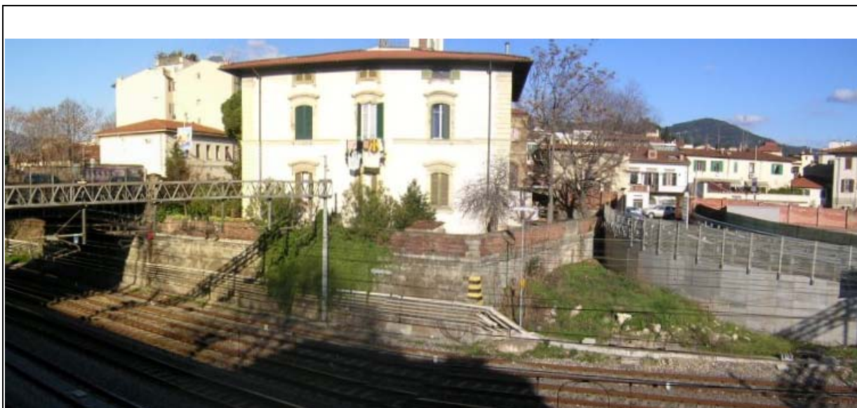
Vista dell'area di intervento di sottofondazione e del pozzo 5 (sulla destra), con l'edificio residenziale da consolidare.
