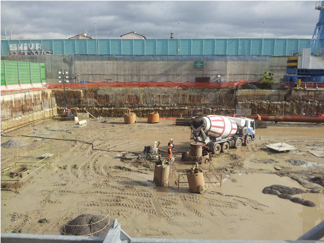
FOTO 2 – Realizzazione Pali Fondazione Camerone
