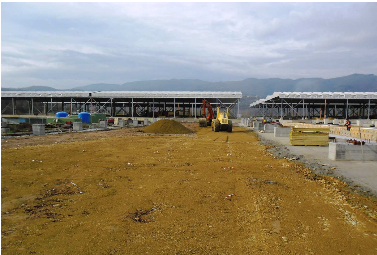
FOTO 2 – Località S. Barbara – Realizzazione Piazzola n. 8
