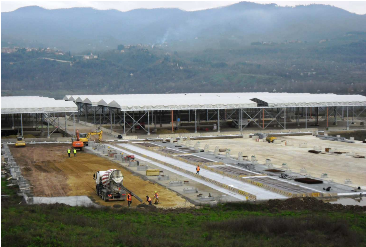
FOTO 1 – Località S. Barbara – Realizzazione Piazzola n. 8
