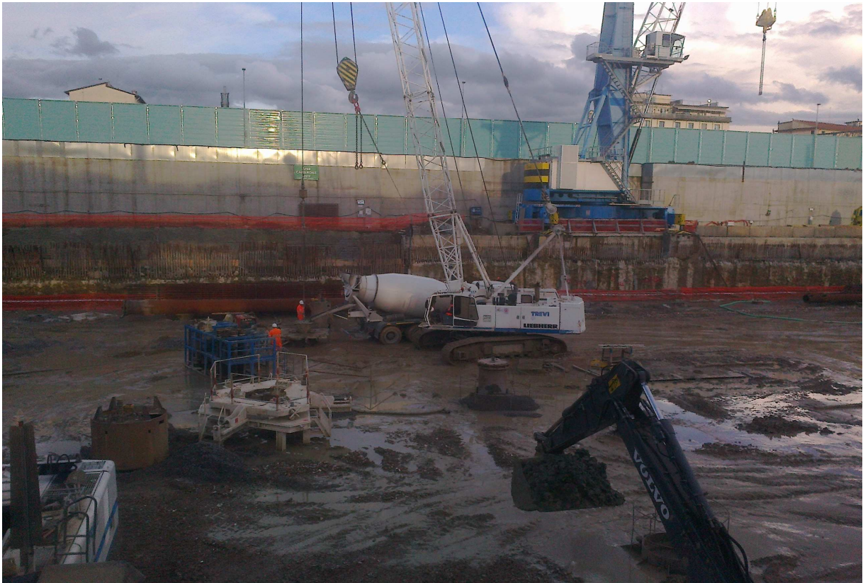
FOTO 1 – Realizzazione Pali Fondazione Camerone
