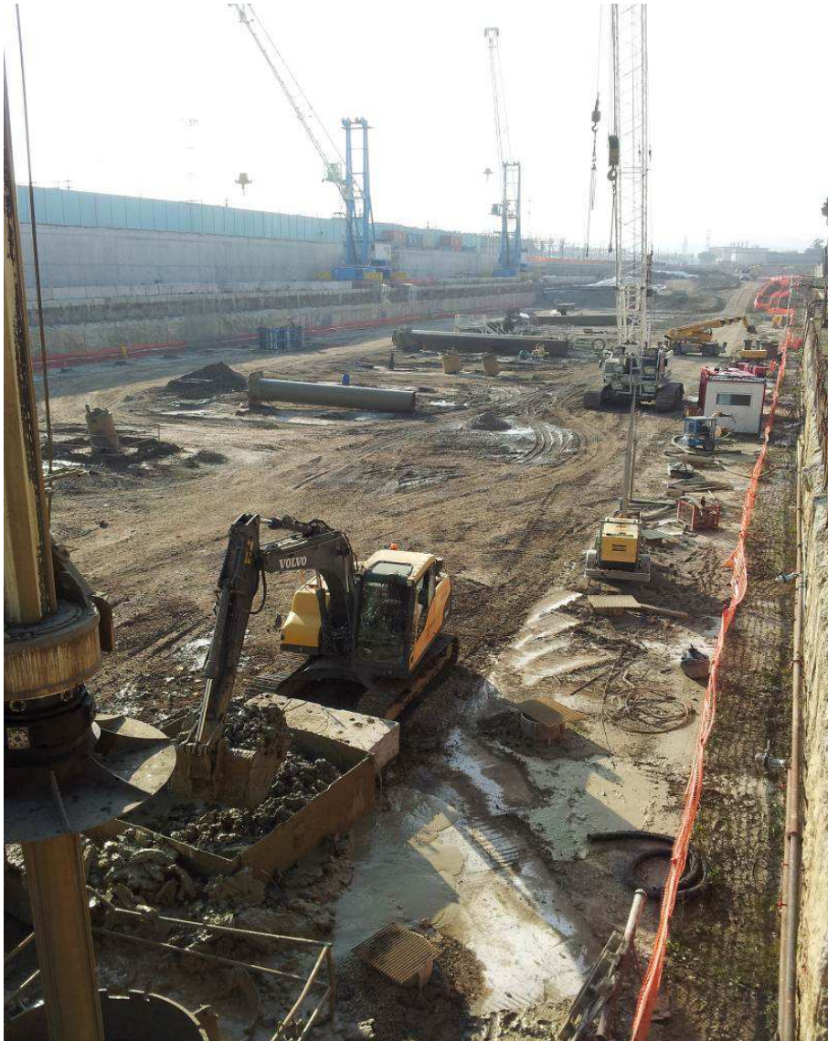
FOTO 2 – Realizzazione Pali Fondazione
