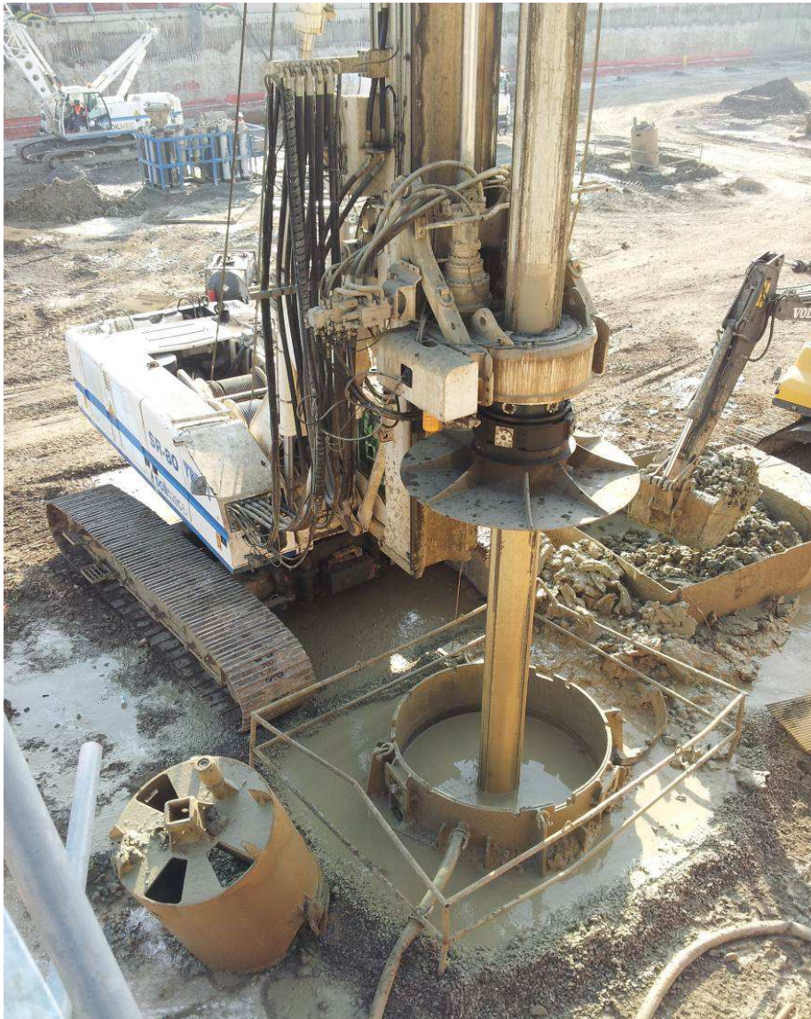
FOTO 1 – Realizzazione Pali Fondazione
