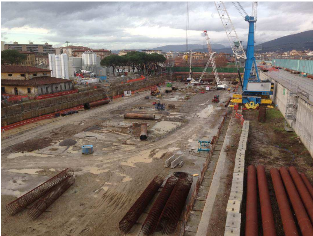
FOTO 1 – Realizzazione Pali Fondazione Camerone
