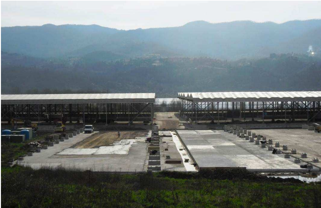
FOTO 1 – Località S. Barbara – Completamento piazzola 8
