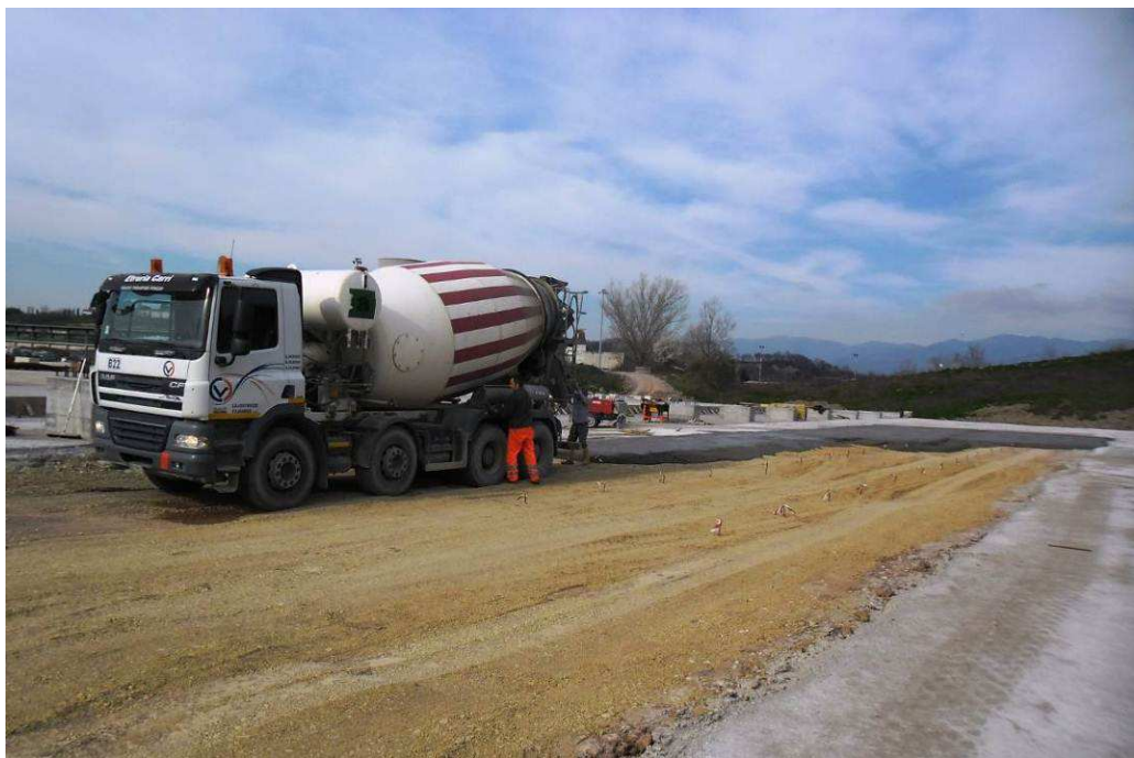
FOTO 2 – Località S. Barbara – Completamento piazzola 8
