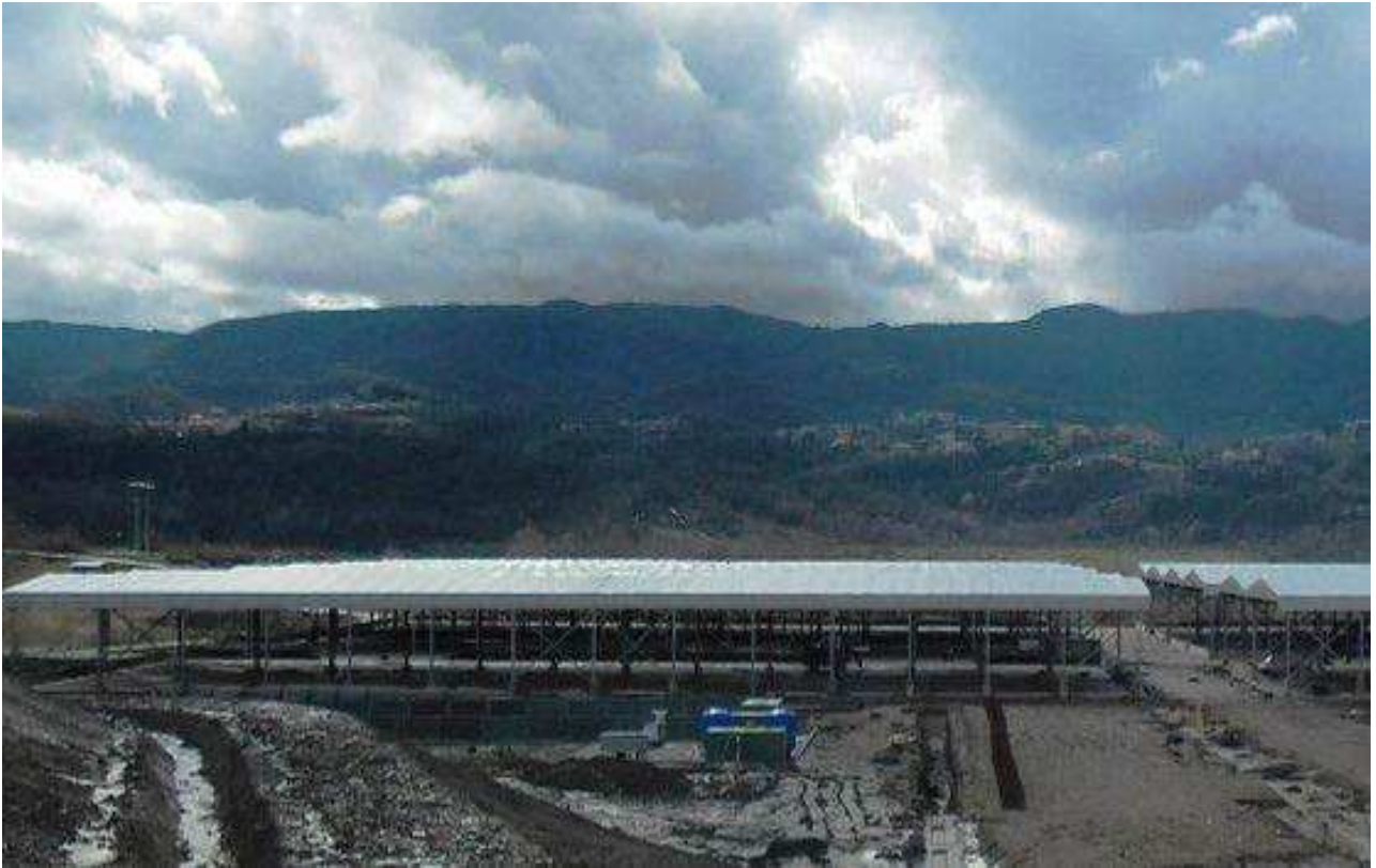
FOTO 2 – Località Bricchette – Piazzole di stoccaggio Fase 2
