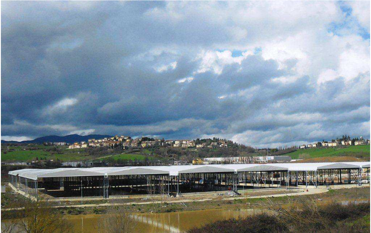
FOTO 1 – Località S.Barbara – Piazzole di stoccaggio Fase 2
