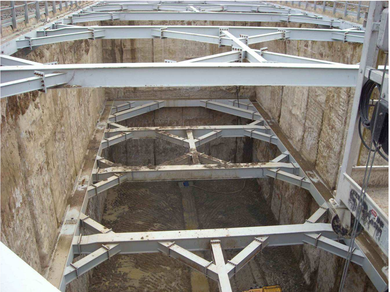
FOTO 2 – Pozzo Nord – 3° scavo da quota 34,60 a 28,20
