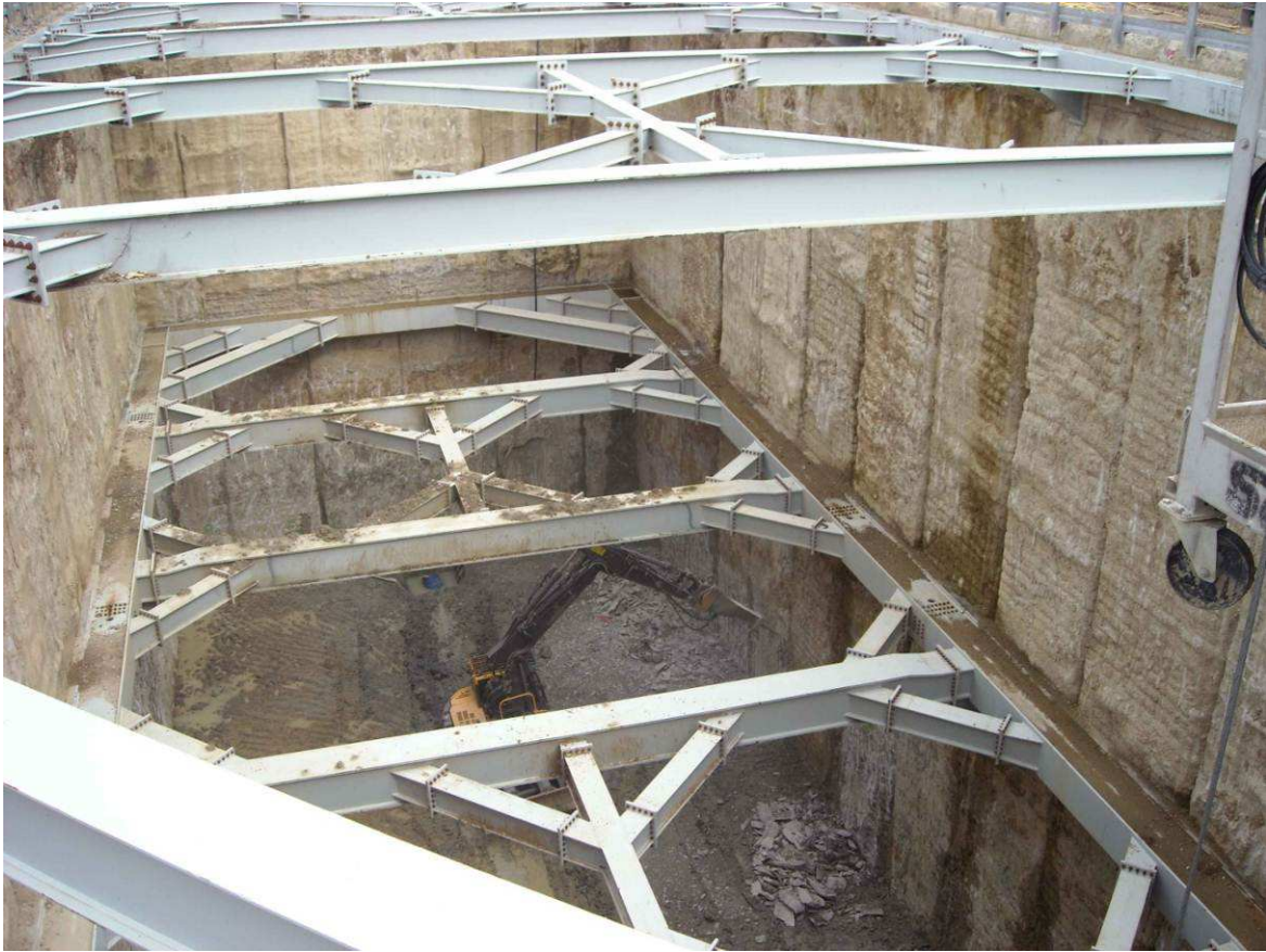
FOTO 3– Pozzo Nord – 3° scavo da quota 34,60 a 28,20
