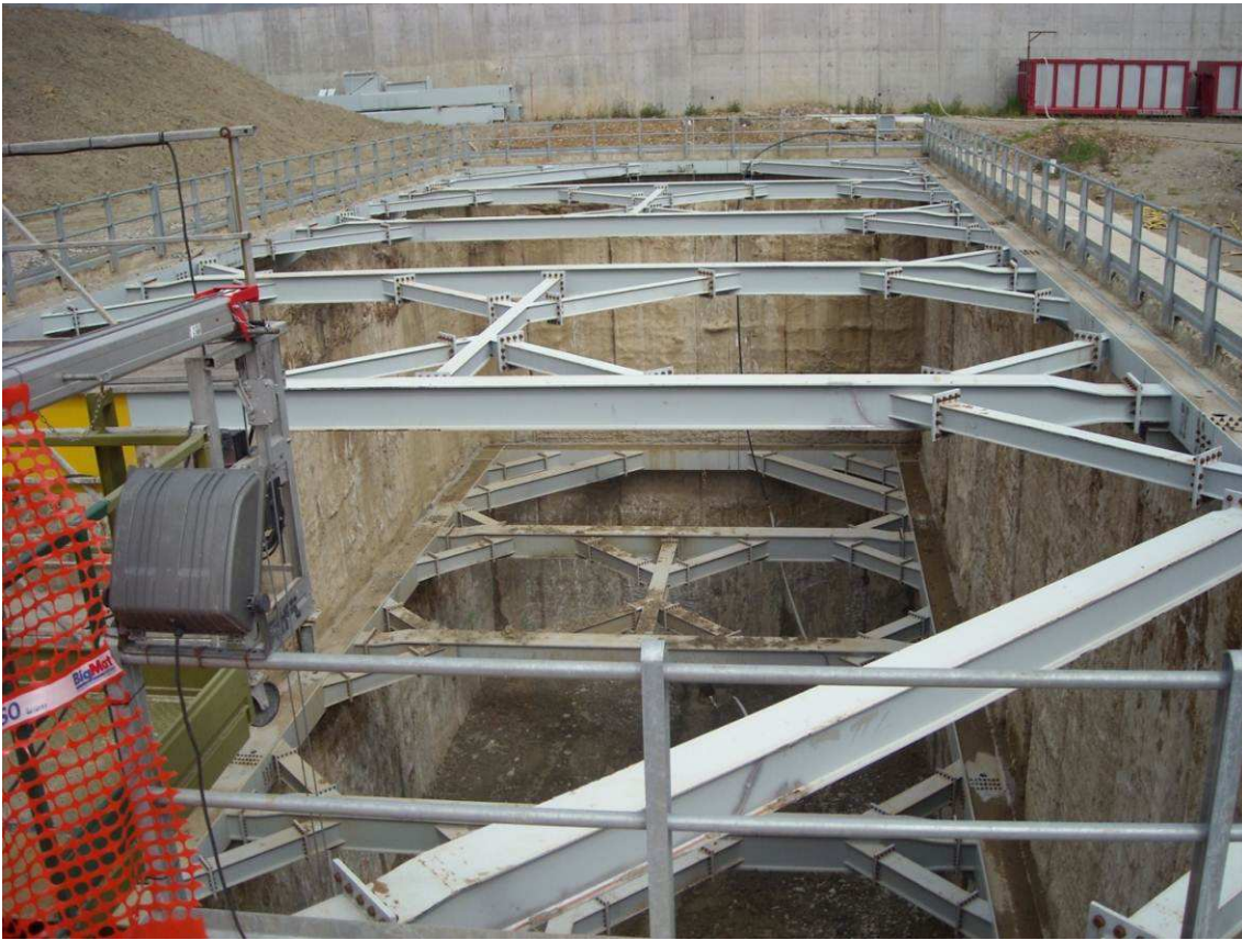
FOTO 1 – Pozzo Nord – Scavo da quota 34,60 m a 28,20 m
