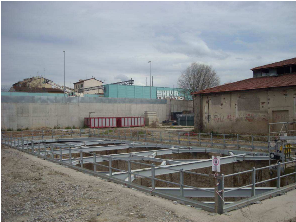
FOTO 2 – Pozzo Nord - Scavo da quota 34,60 m a 28,20 m
