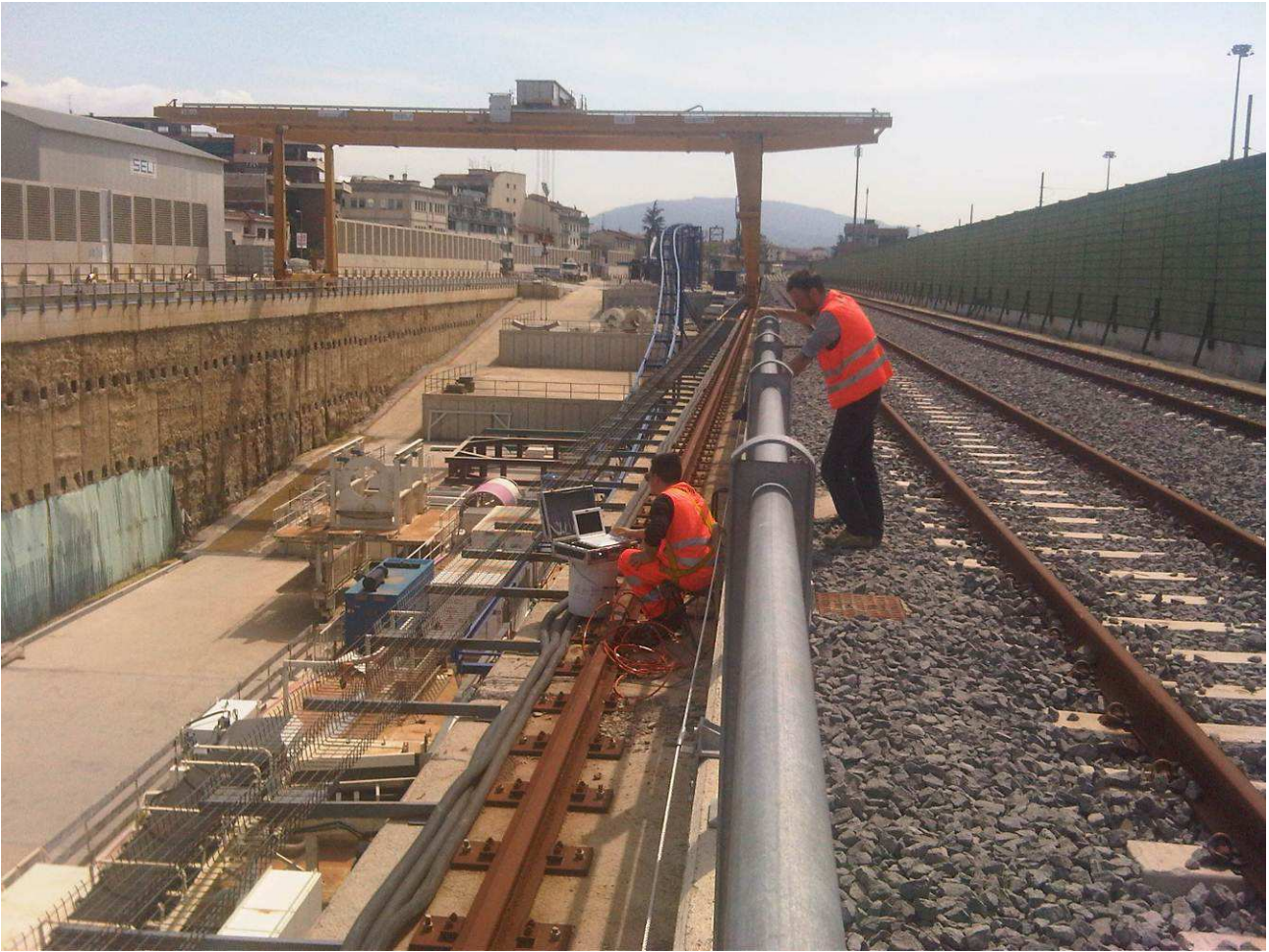
FOTO 2 – Monitoraggio galleria artificiale Campo di Marte
