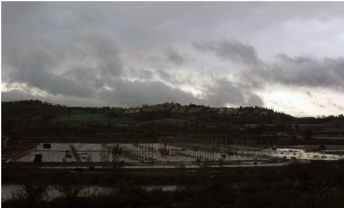
FOTO 1– Località S.Barbara – Piazzole di stoccaggio Fase 2 – Coperture
