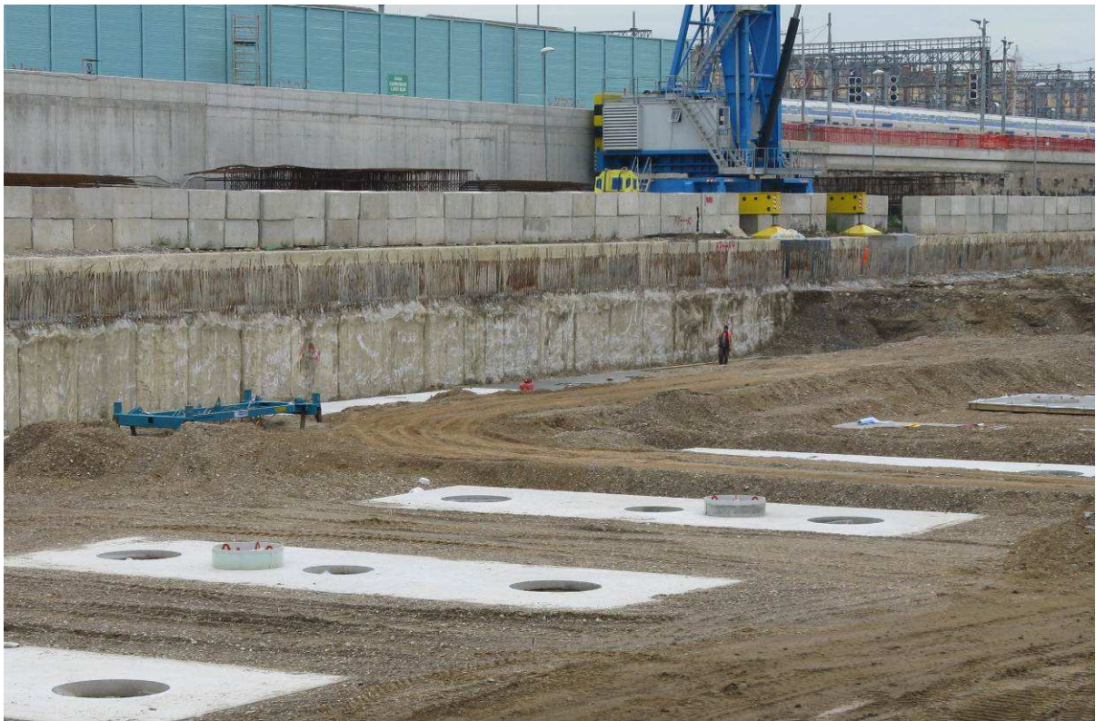
FOTO 1 - platee-guida in cls per pali-colonna
