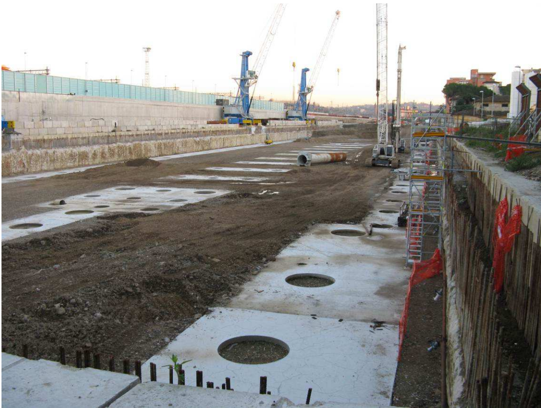
FOTO 2 - cantierizzazione per pali di fondazione
