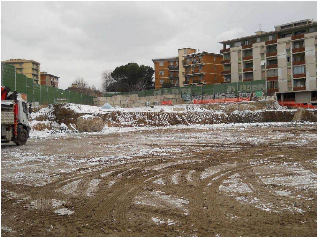
Foto 3: sbancamento rilevato in area BELFIORE
