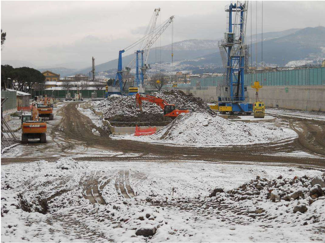
Foto 2: movimentazione terre di scavo pannelli diaframmi
