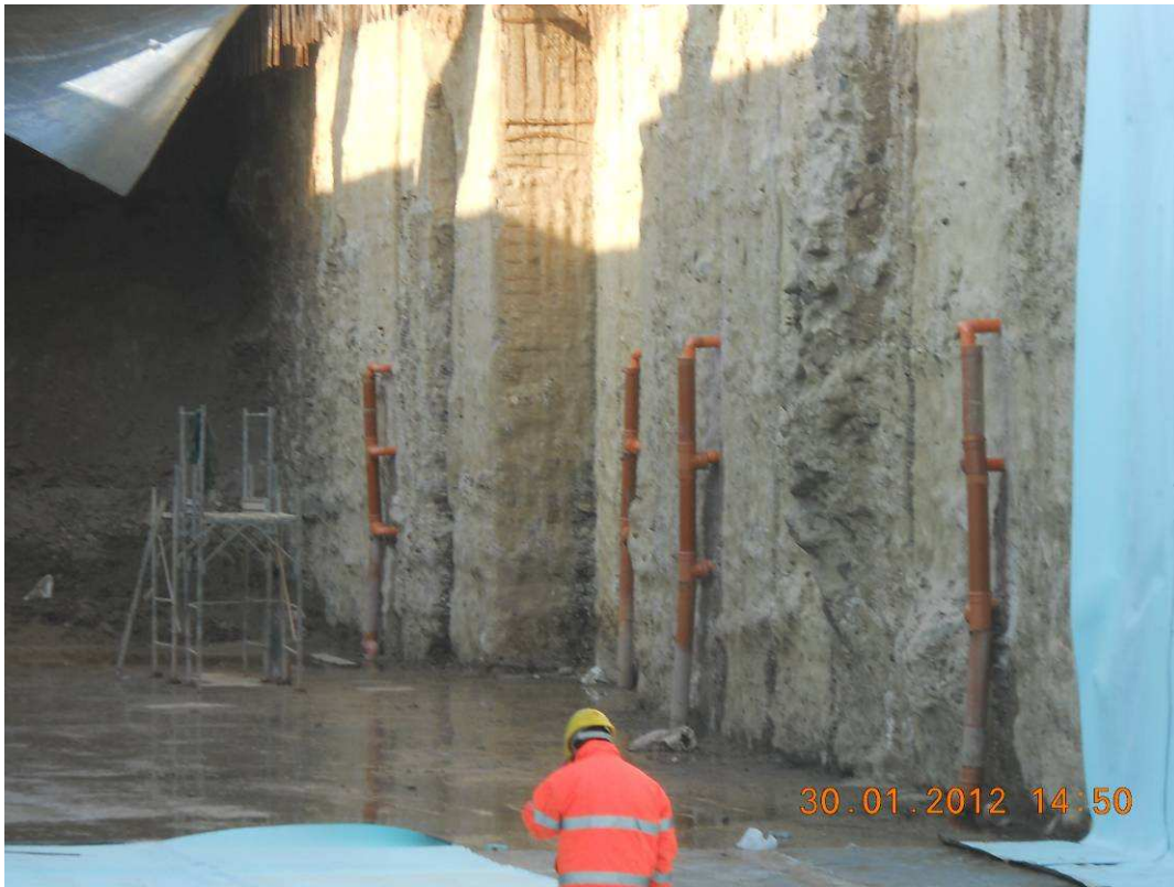
FOTO 9 – Trincea - realizzazione sistema di continuità di falda
