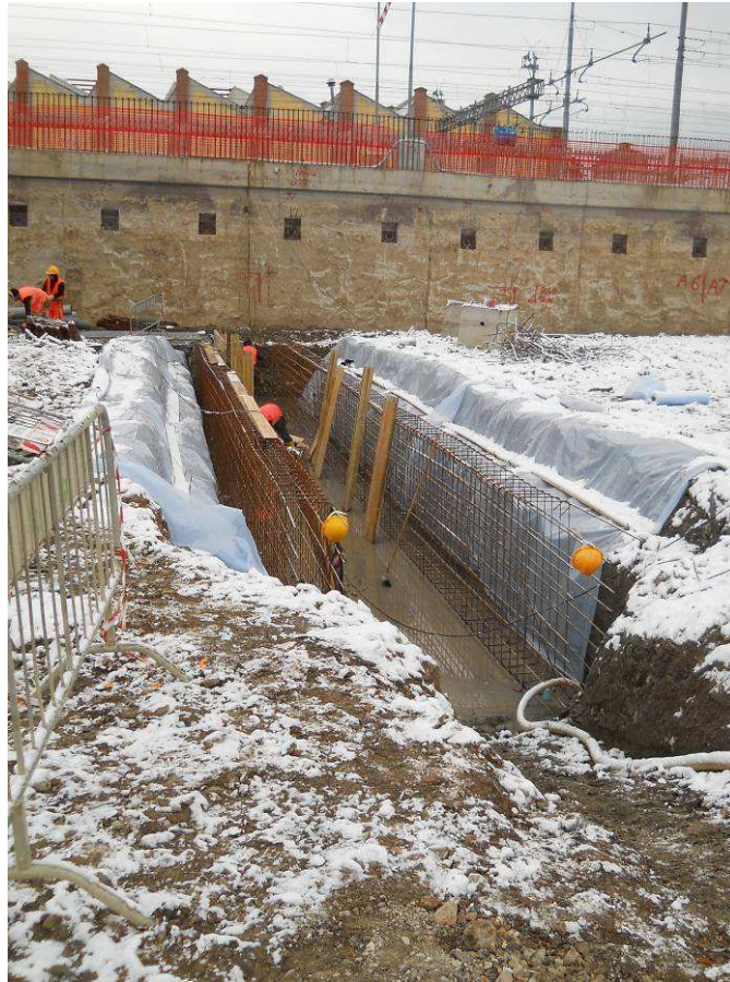
Foto 4: cordoli-guida testata SUD camerone stazione
