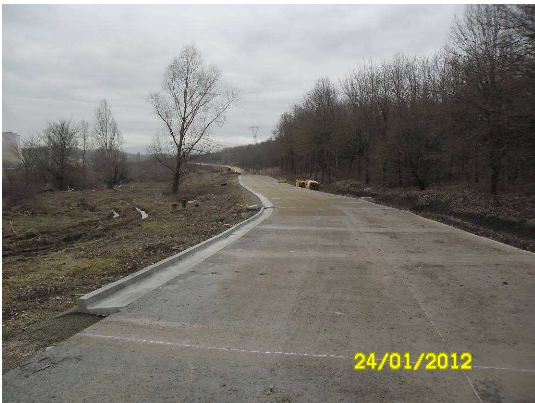
FOTO 10 – Località S. Barbara – realizzazione viabilità di servizio
