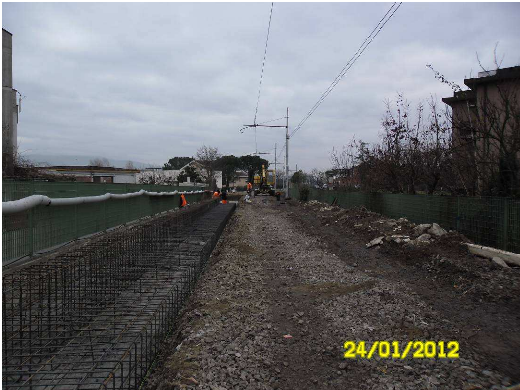
FOTO 12 – Località S. Giovanni Valdarno – realizzazione fondazioni barriere antirumore
