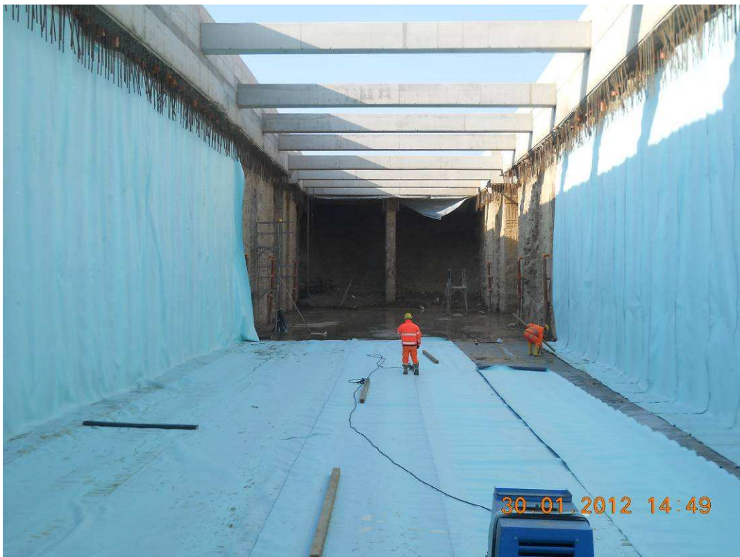
FOTO 4 – Trincea – impermeabilizzazione struttura interna
