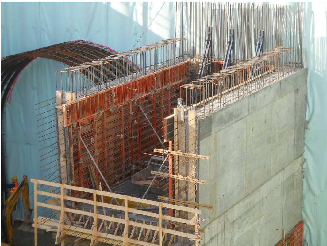
FOTO 6 – Pozzo lancio frese – armatura e getto struttura di imbocco
