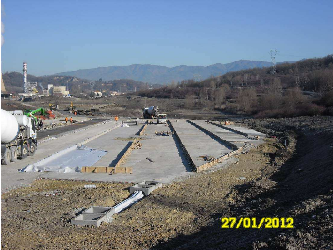
FOTO 11 - Località S. Barbara – pavimentazione area logistica
