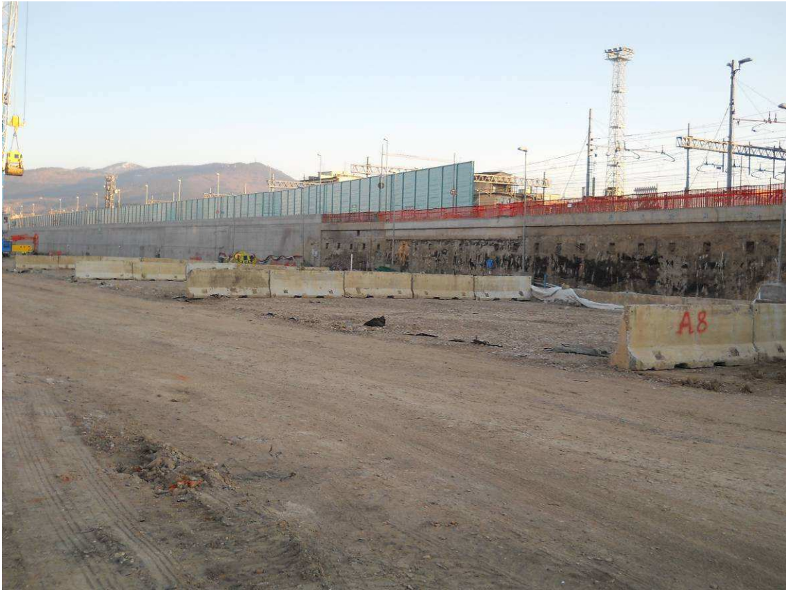
Foto 2: realizzazione piazzola di stoccaggio temporaneo
