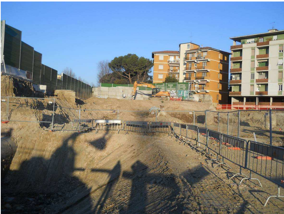
Foto 3: sbancamento rilevato in area BELFIORE
