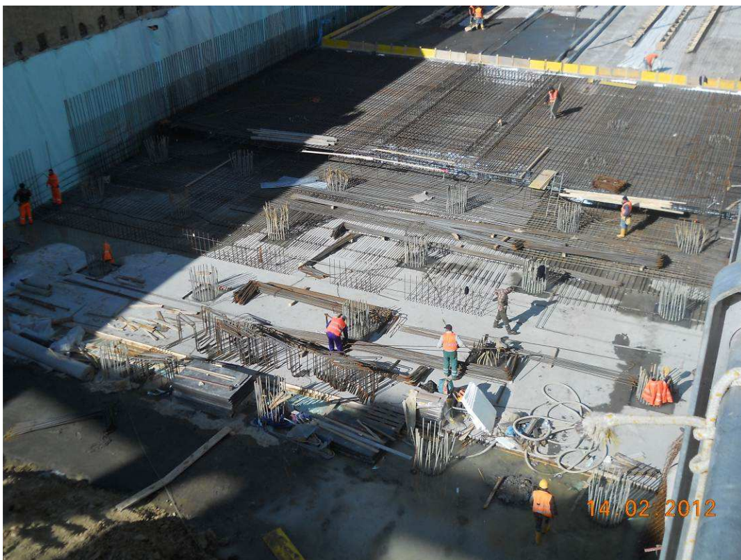
FOTO 6 – Pozzo lancio frese – realizzazione soletta di fondazione
