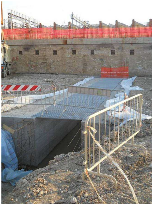
Foto 5: cordoli-guida testata SUD camerone stazione
