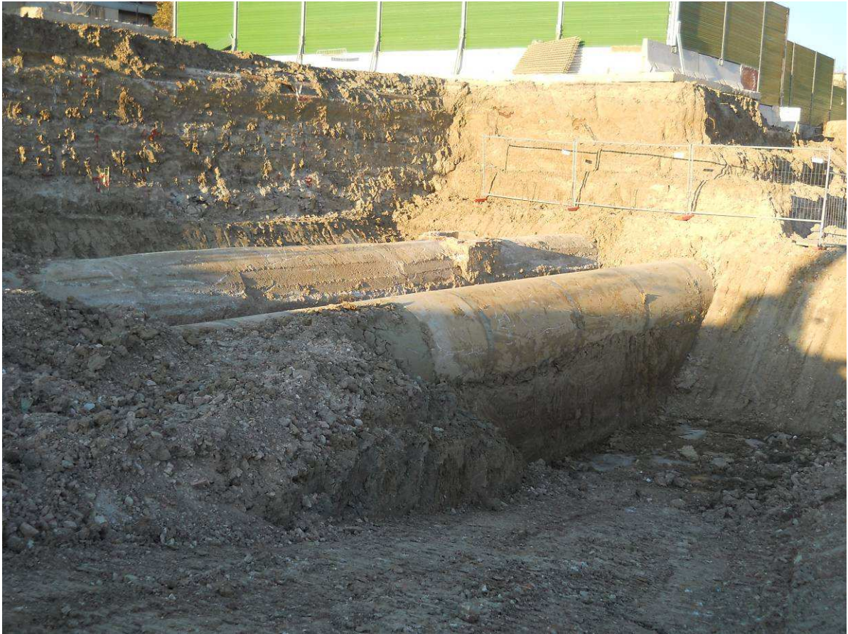
Foto 6: spostamento fogna SUD
