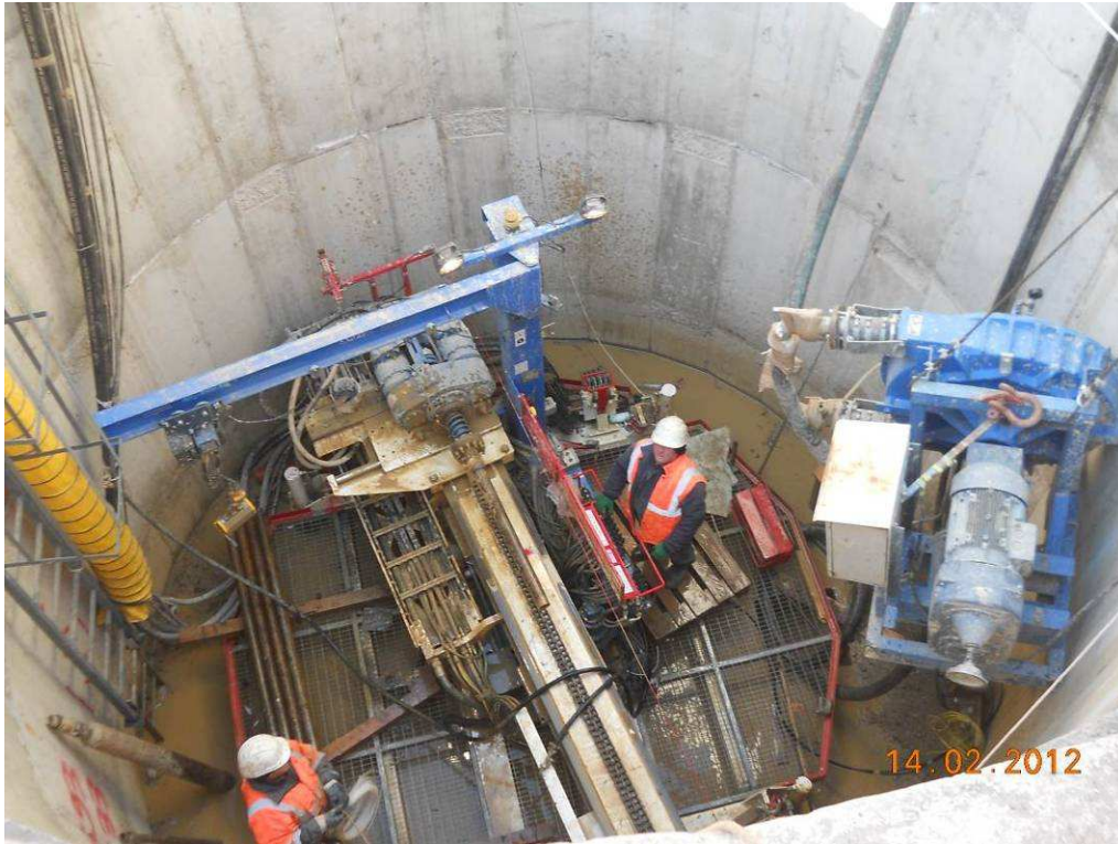
FOTO 7 – Compensation grouting edifici area Ponte al Pino – perforazioni
