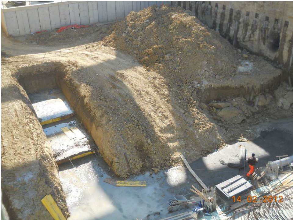
FOTO 5 – Pozzo lancio frese – prima gradonatura - realizzazione piano imposta fondazioni
