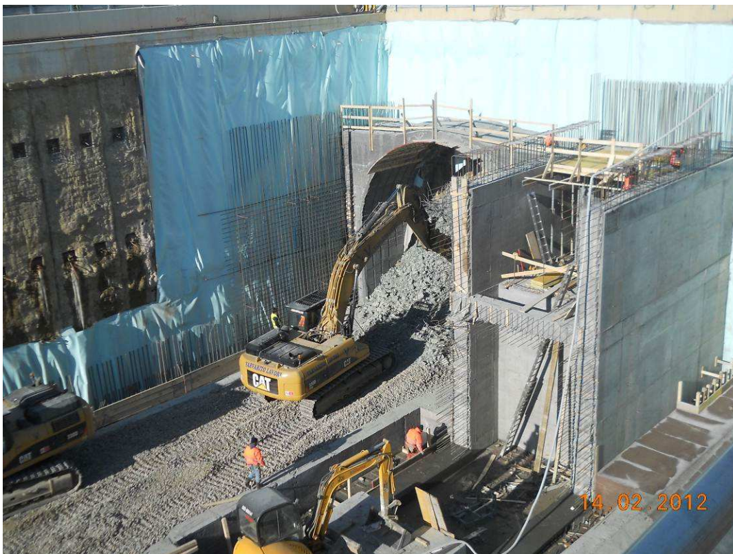
FOTO 4 – Pozzo lancio fresse – demolizione diaframmi paratia di testata
