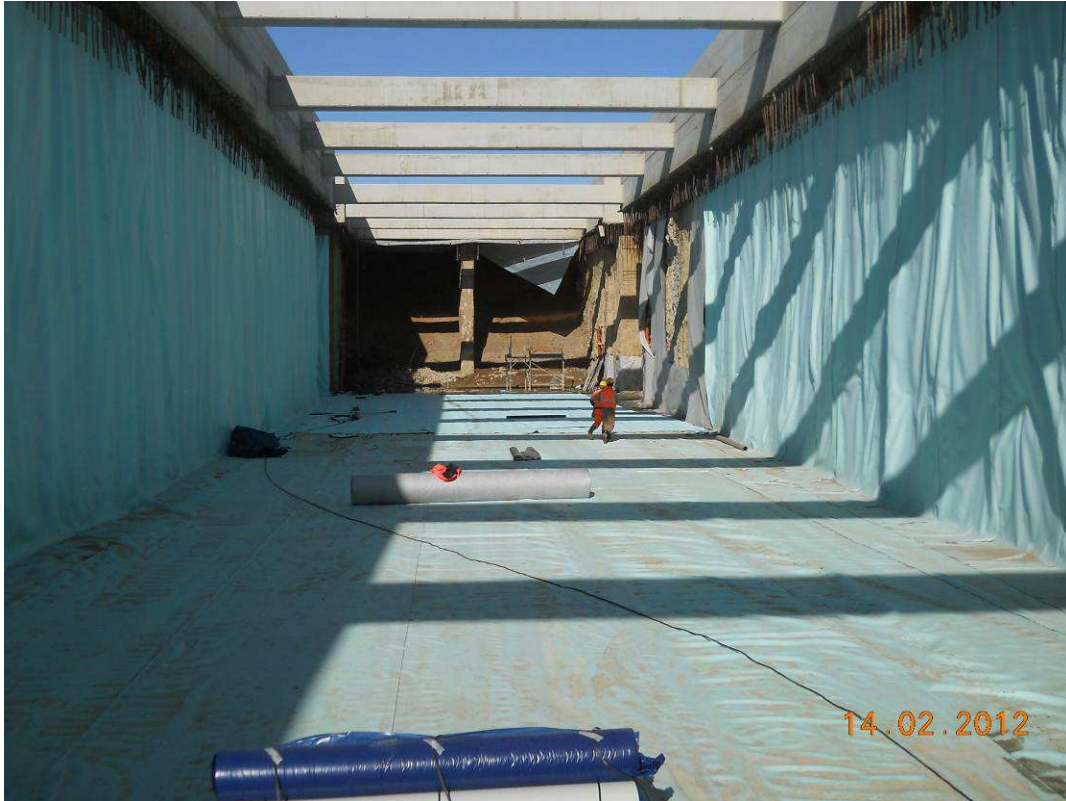
FOTO 3 – Trincea – impermeabilizzazione struttura interna
