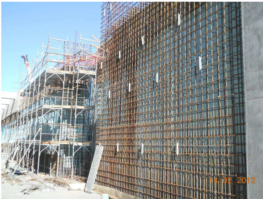
FOTO 2 – Continua la realizzazione della struttura interna in c.a. della Trincea
