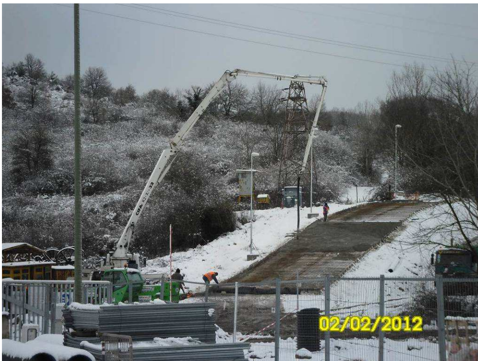
FOTO 8 – Località S. Barbara – realizzazione viabilità di servizio
