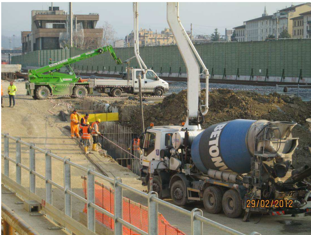
FOTO 6 – Pozzo lancio frese – armatura e getto muri di sostegno 4° gradonatura
