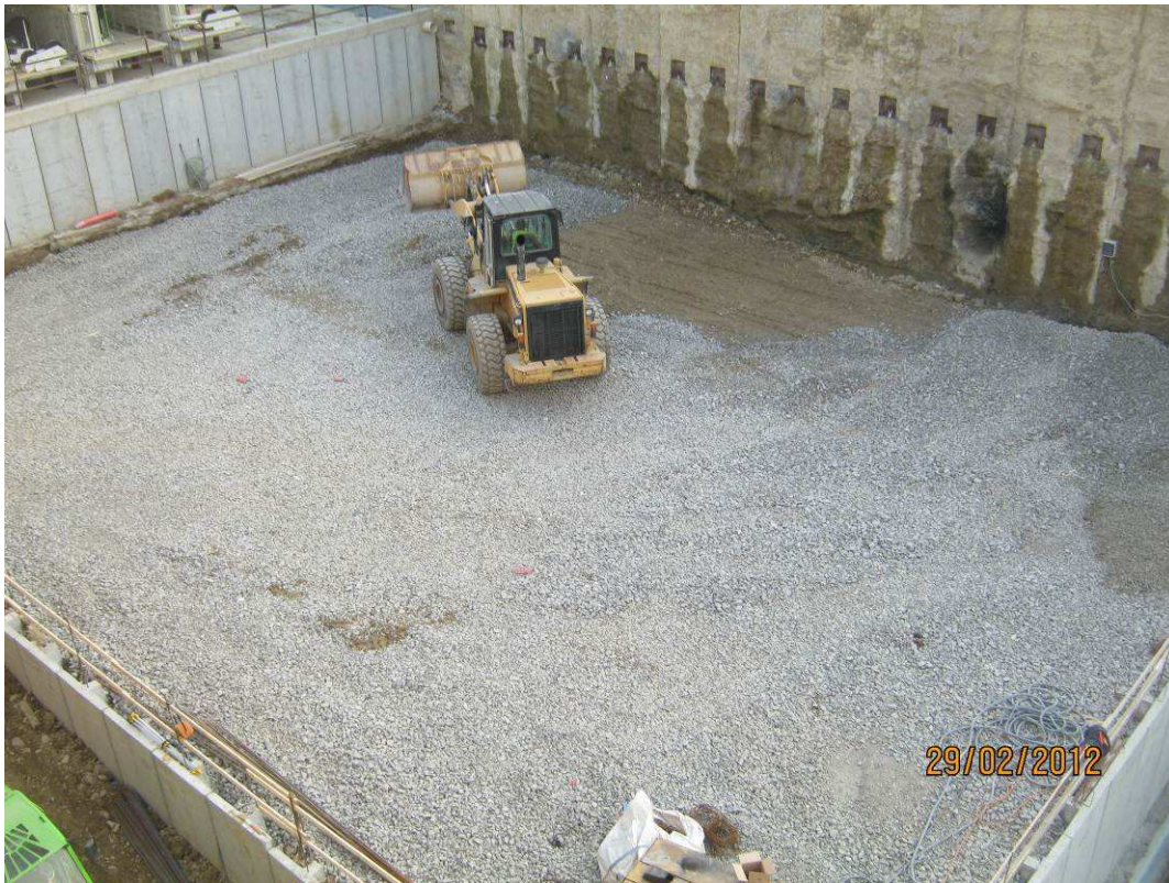
FOTO 7 – Pozzo lancio frese – regolarizzazione piano di imposta 1° gradonatura
