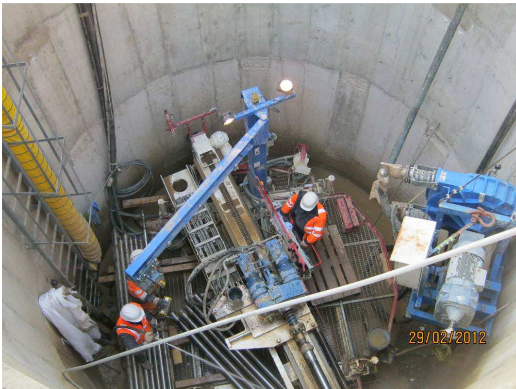
FOTO 8 – Compensation grouting edifici area Ponte al Pino – perforazioni
