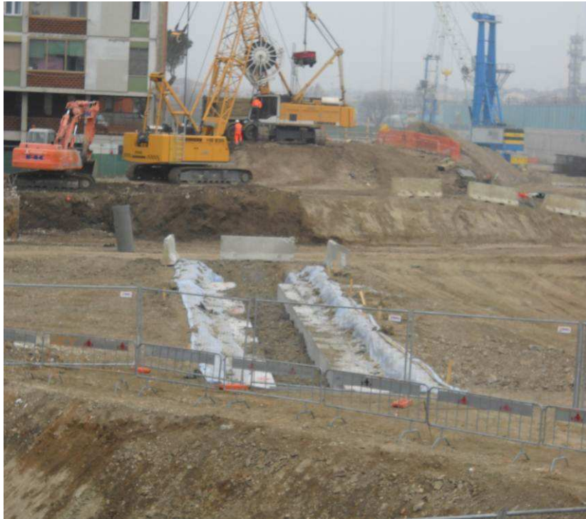
Foto 4: cordoli-guida allineamento OVEST camerone stazione
