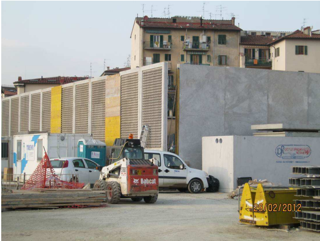
FOTO 9 – Posa in opera barriere fonoassorbenti adiacenti via del Campo d'Arrigo
