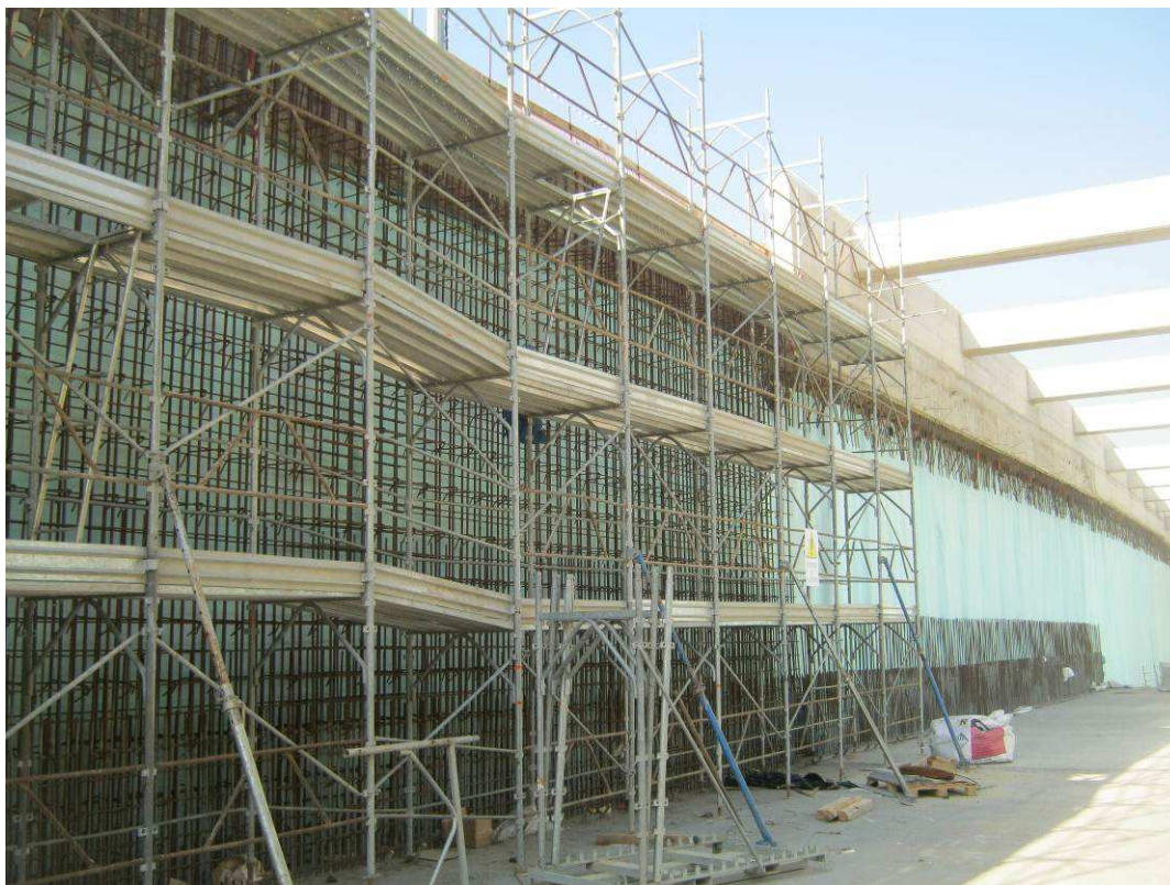
FOTO 2 – Trincea – realizzazione della struttura interna in c.a.
