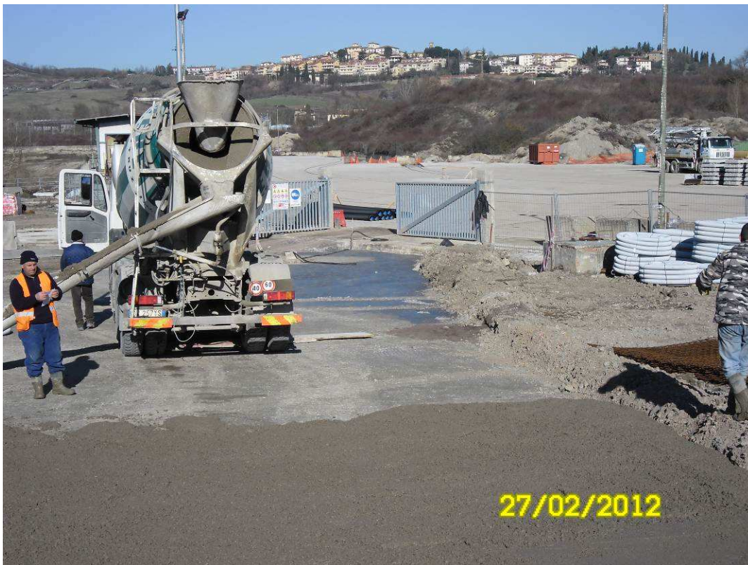
FOTO 10 – Località S. Barbara – realizzazione viabilità di servizio
