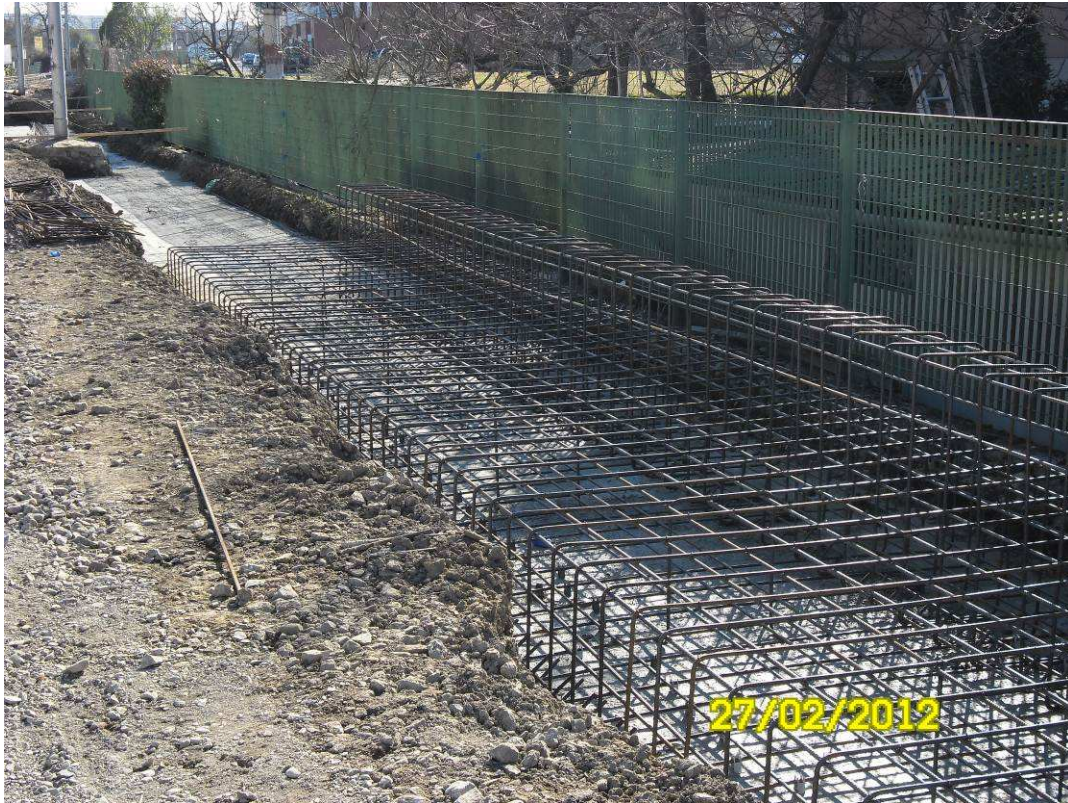
FOTO 11 - Località S. Giovanni Valdarno – realizzazione fondazioni barriere antirumore
