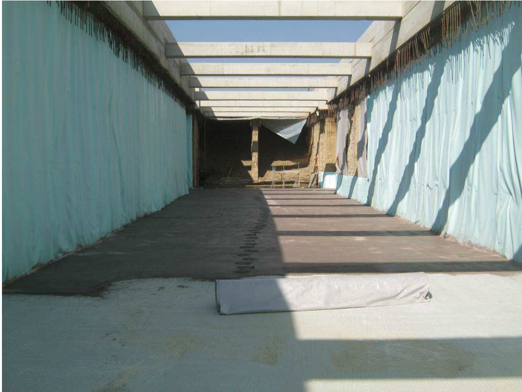
FOTO 3 – Trincea – impermeabilizzazione struttura interna
