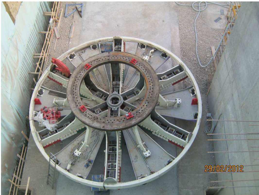
FOTO 4 – Pozzo lancio frese – assemblaggio testa TBM
