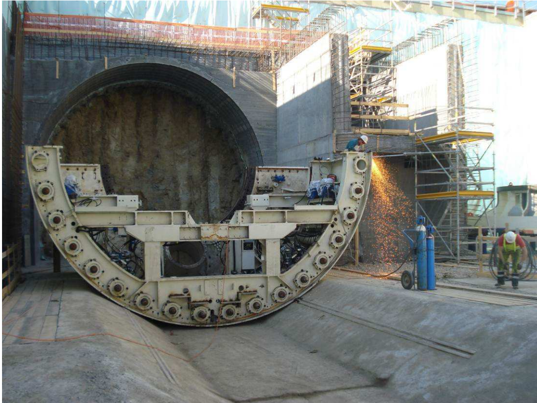
FOTO 5 – Pozzo lancio frese – assemblaggio e saldatura scudo TBM
