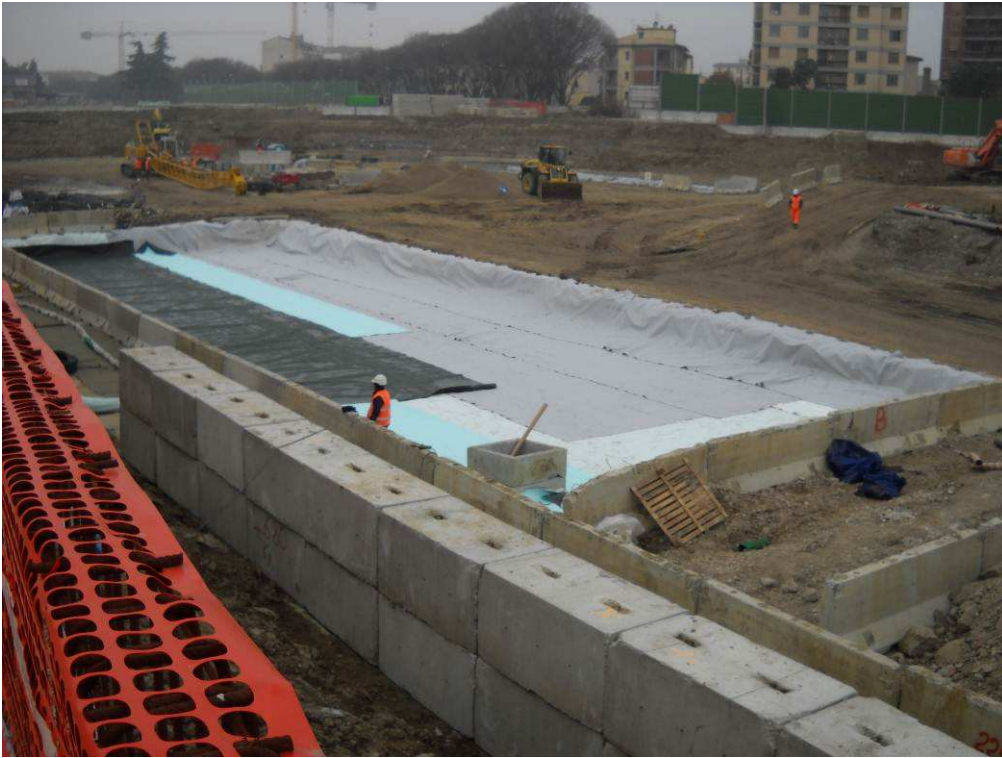
Foto 2: realizzazione piazzola di stoccaggio temporaneo
