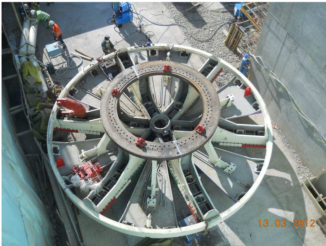
FOTO 3 – Pozzo lancio frese – assemblaggio e saldatura testa TBM
