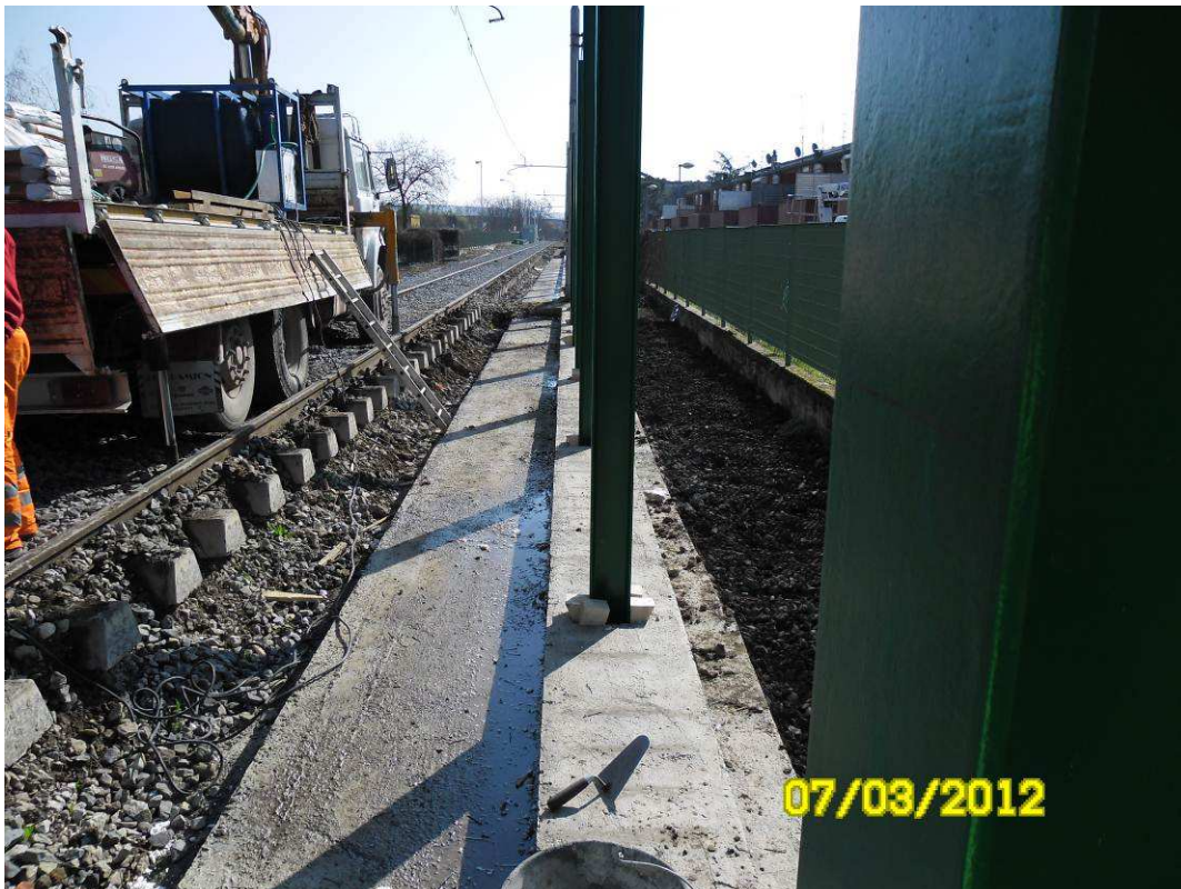
FOTO 8 – Località S. Giovanni Valdarno – realizzazione barriere antirumore
