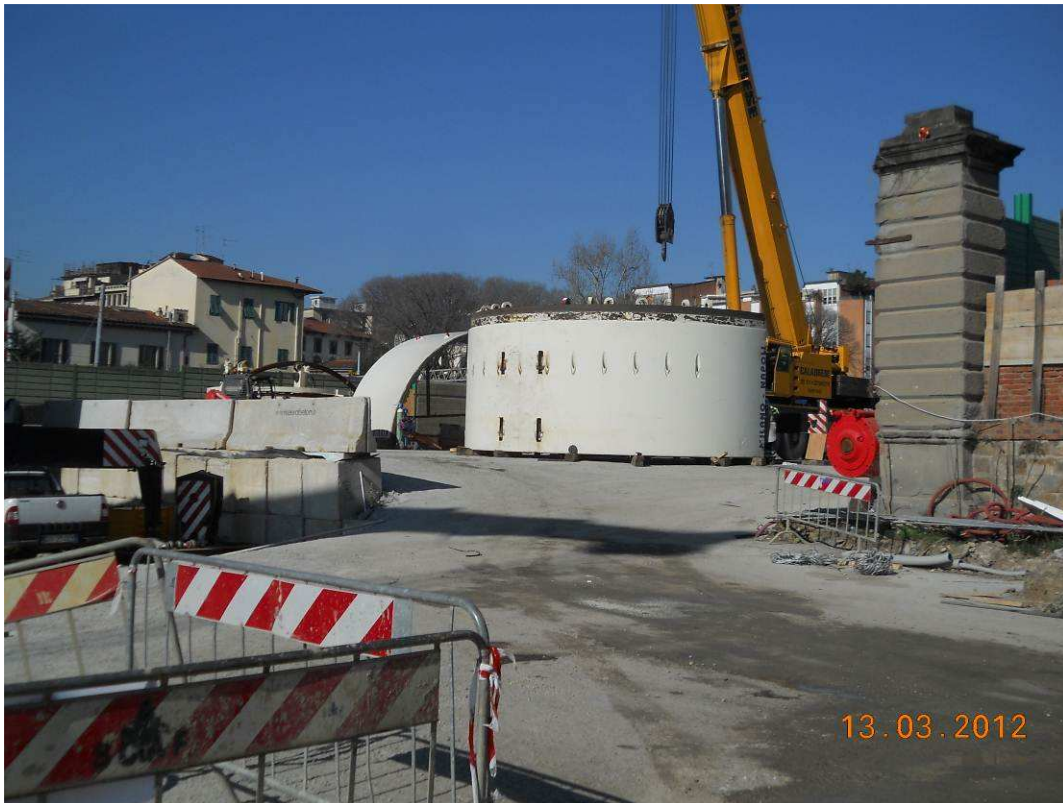
FOTO 6 – Approvvigionamento componenti TBM
