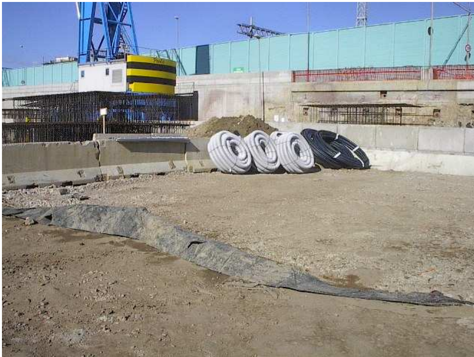
Foto 3: realizzazione piazzola di stoccaggio temporaneo
