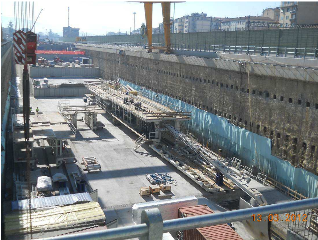
FOTO 1 – Pozzo Lancio Frese – assemblaggio back-up TBM
