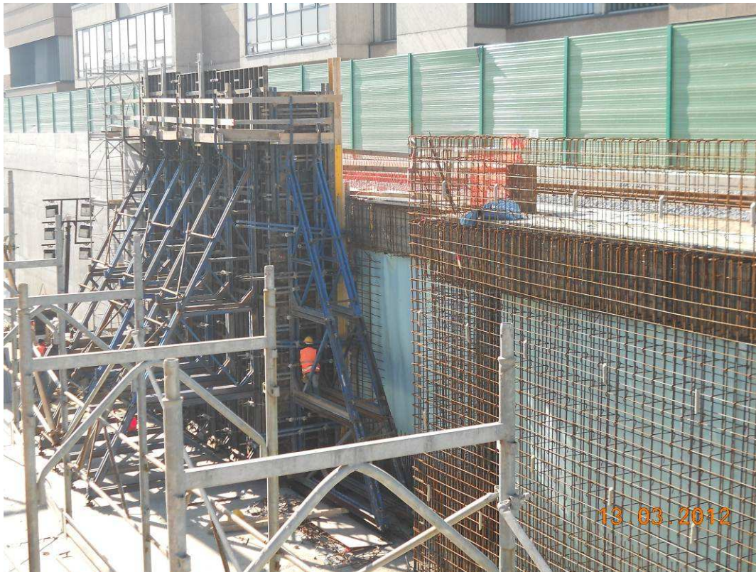
FOTO 2 – Trincea - continua la realizzazione della struttura interna in c.a.
