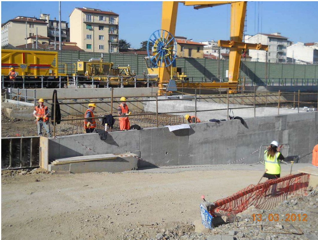
FOTO 7 – Realizzazione fondazioni nastro trasporto smarino
