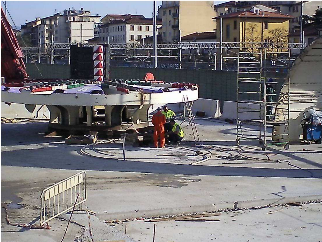
FOTO 3 –Assemblaggio e saldatura testa TBM
