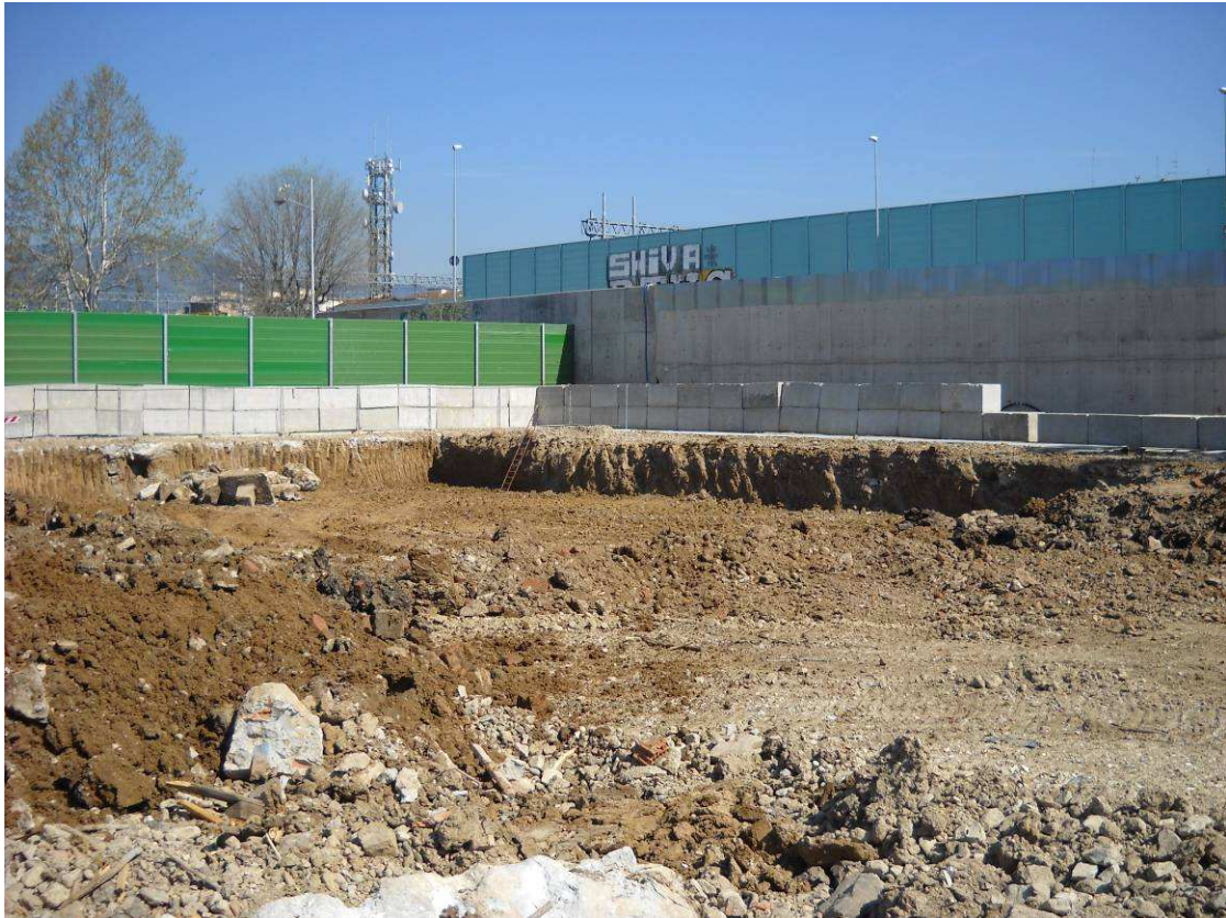
Foto 2: sbancamento terre camerone Stazione
