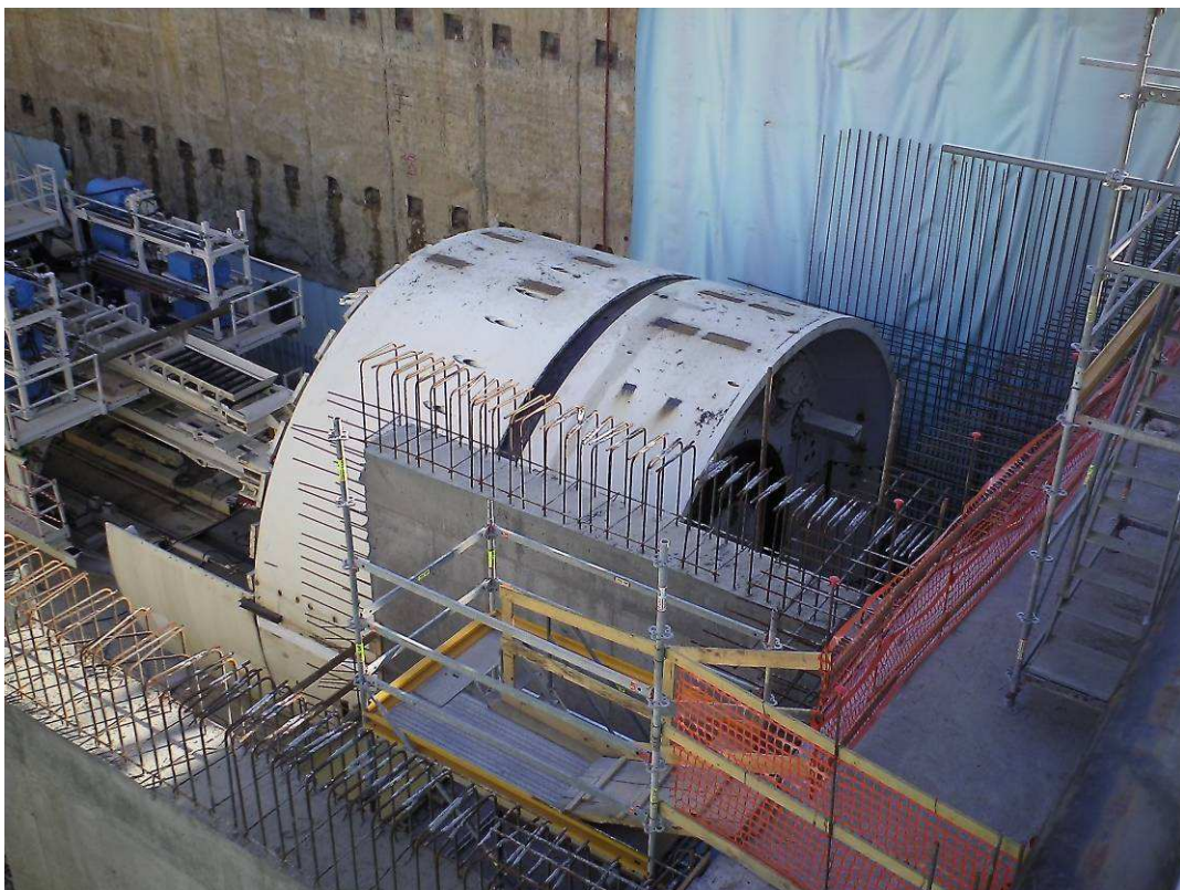
FOTO 4 –Pozzo lancio frese – assemblaggio e saldatura scudo TBM
