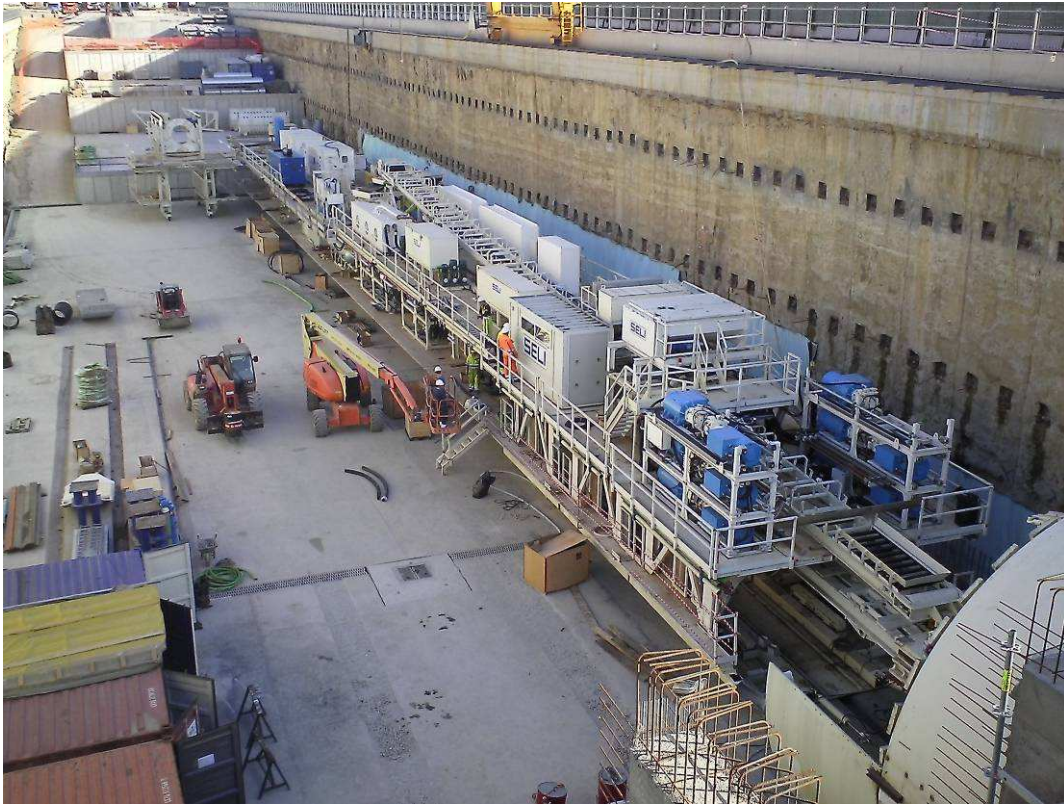
FOTO 1 – Pozzo Lancio Frese – assemblaggio back-up TBM
