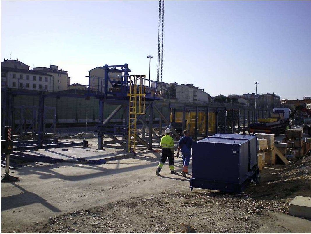
FOTO 7 – Assemblaggio strutture nastro trasporto smarino
