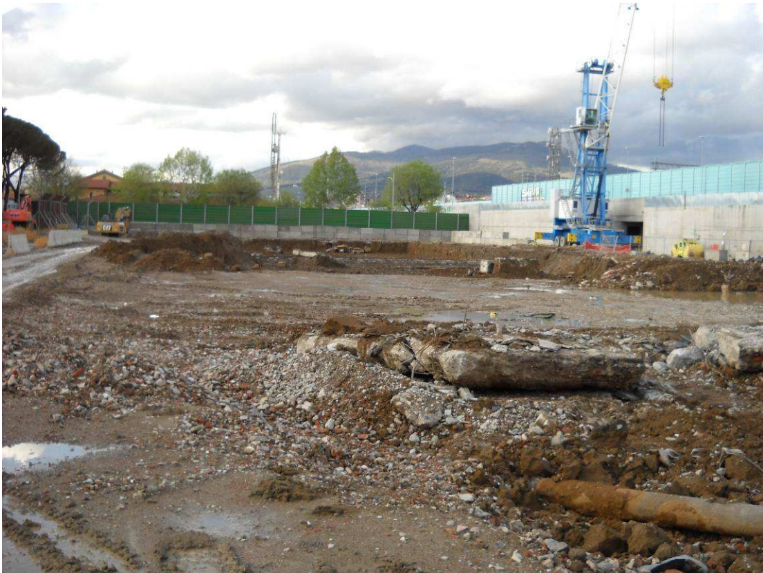
Foto 2: sbancamento da quota +46,00 m a +44,00 m s.l.m.
