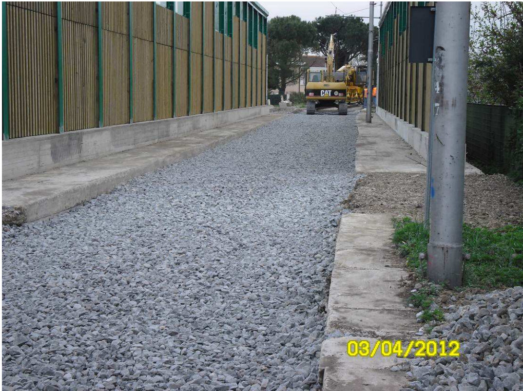
FOTO 7 – Località S. Giovanni Valdarno – ricostruzione binario
