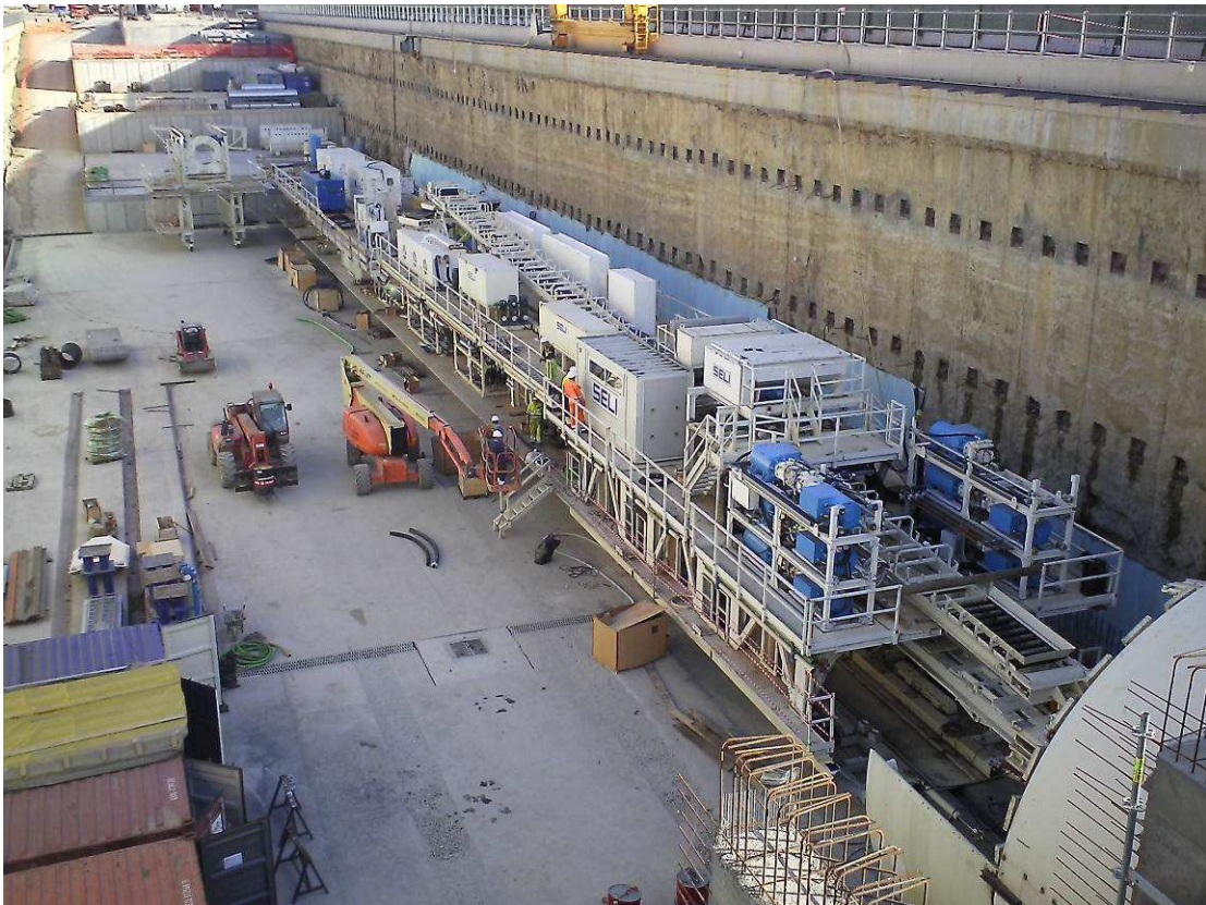
FOTO 1 – Pozzo Lancio Frese – assemblaggio back-up TBM
