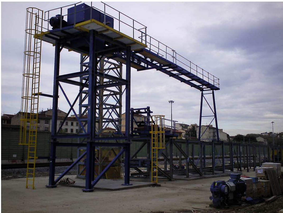
FOTO 6 – Assemblaggio strutture nastro trasporto smarino
