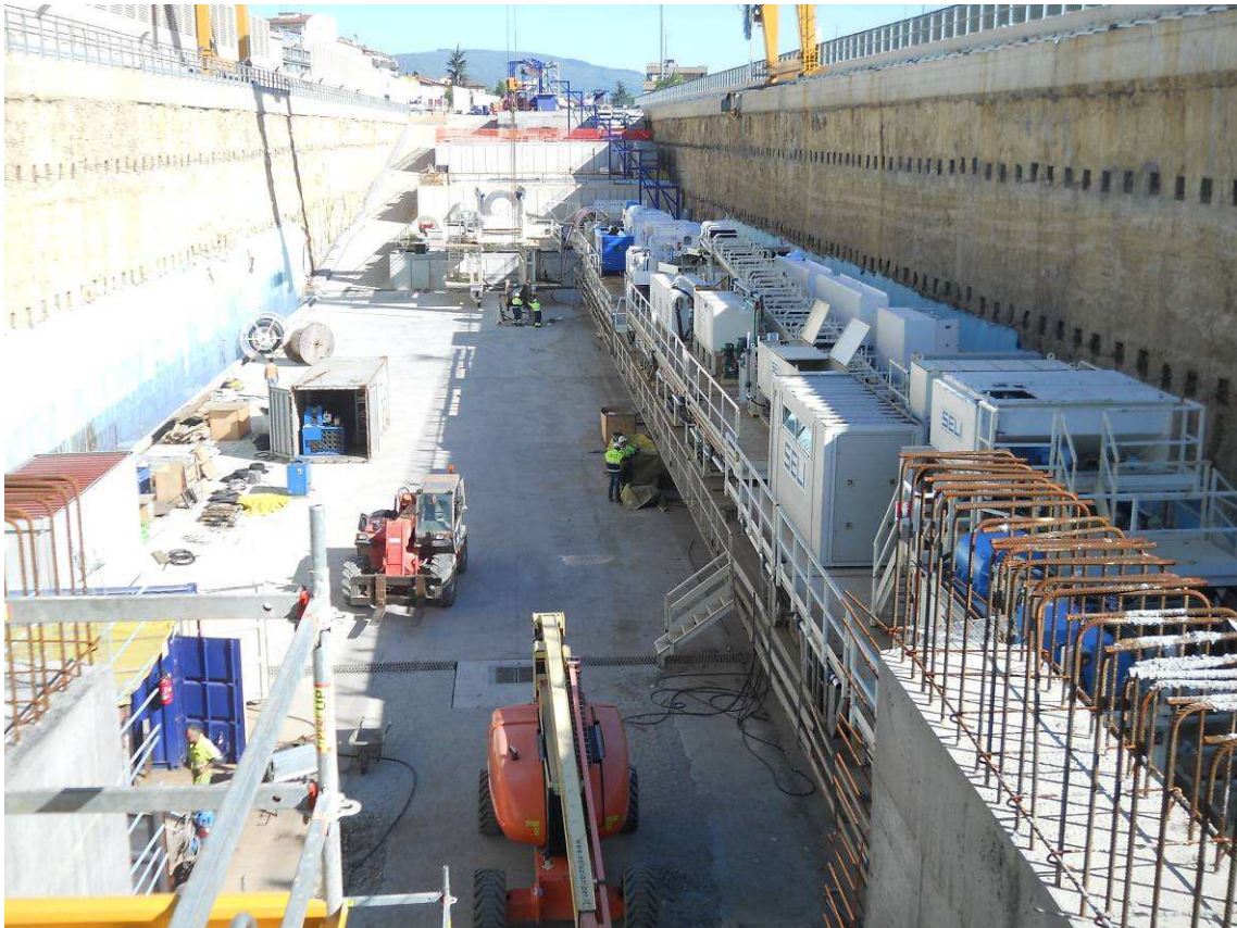
FOTO 1 – Pozzo Lancio Frese – assemblaggio back-up TBM
