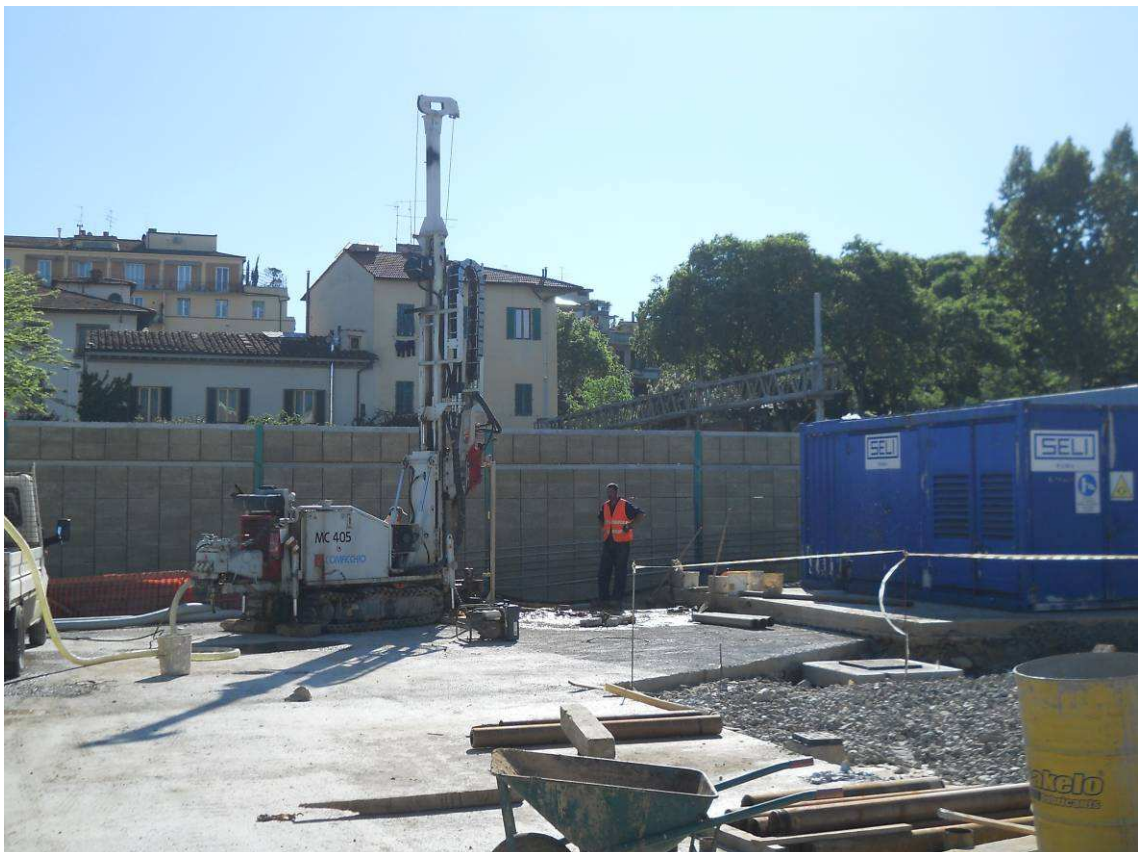
FOTO 6 – Perforazioni necessarie alla posa delle apparecchiature di monitoraggio
