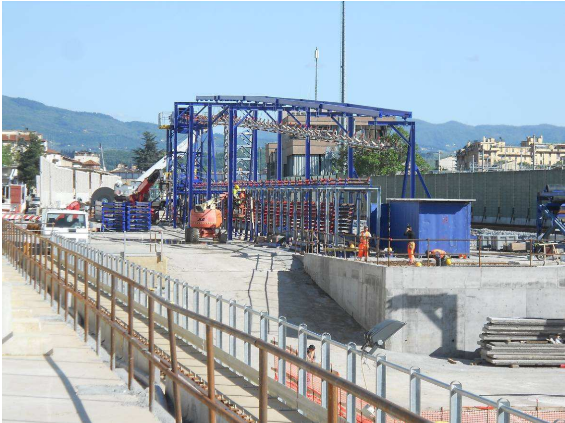
FOTO 5 – Assemblaggio strutture nastro trasporto smarino
