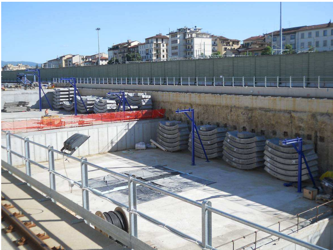
FOTO 4 – Pozzo lancio frese – approvvigionamento conchi prefabbricati
