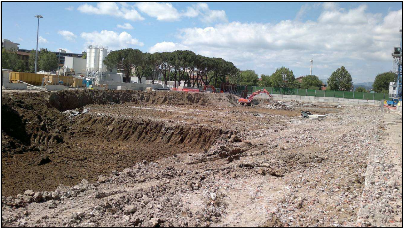
Foto 2: sbancamento da quota +46,00 m a +44,00 m s.l.m.
