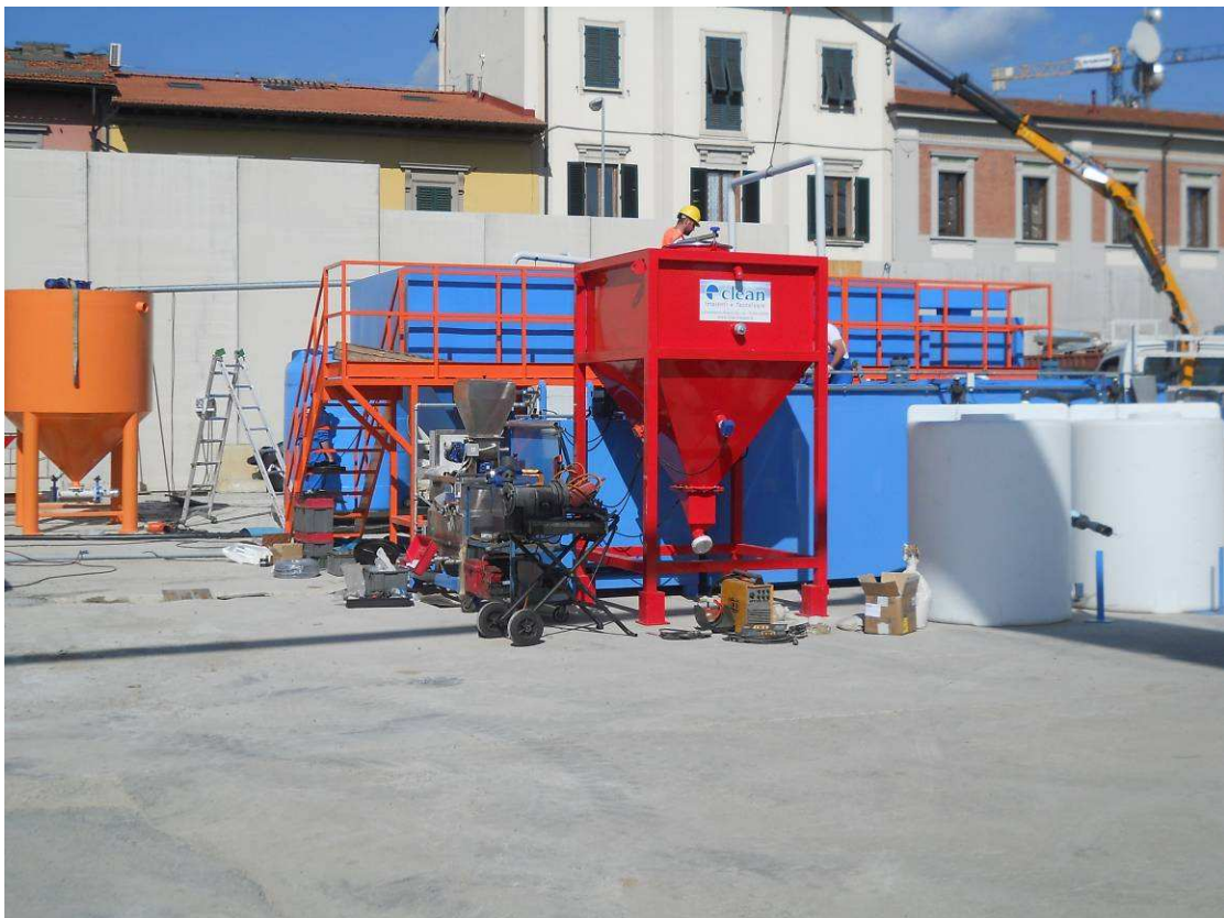
FOTO 3 – Posa in opera impianto trattamento acque
