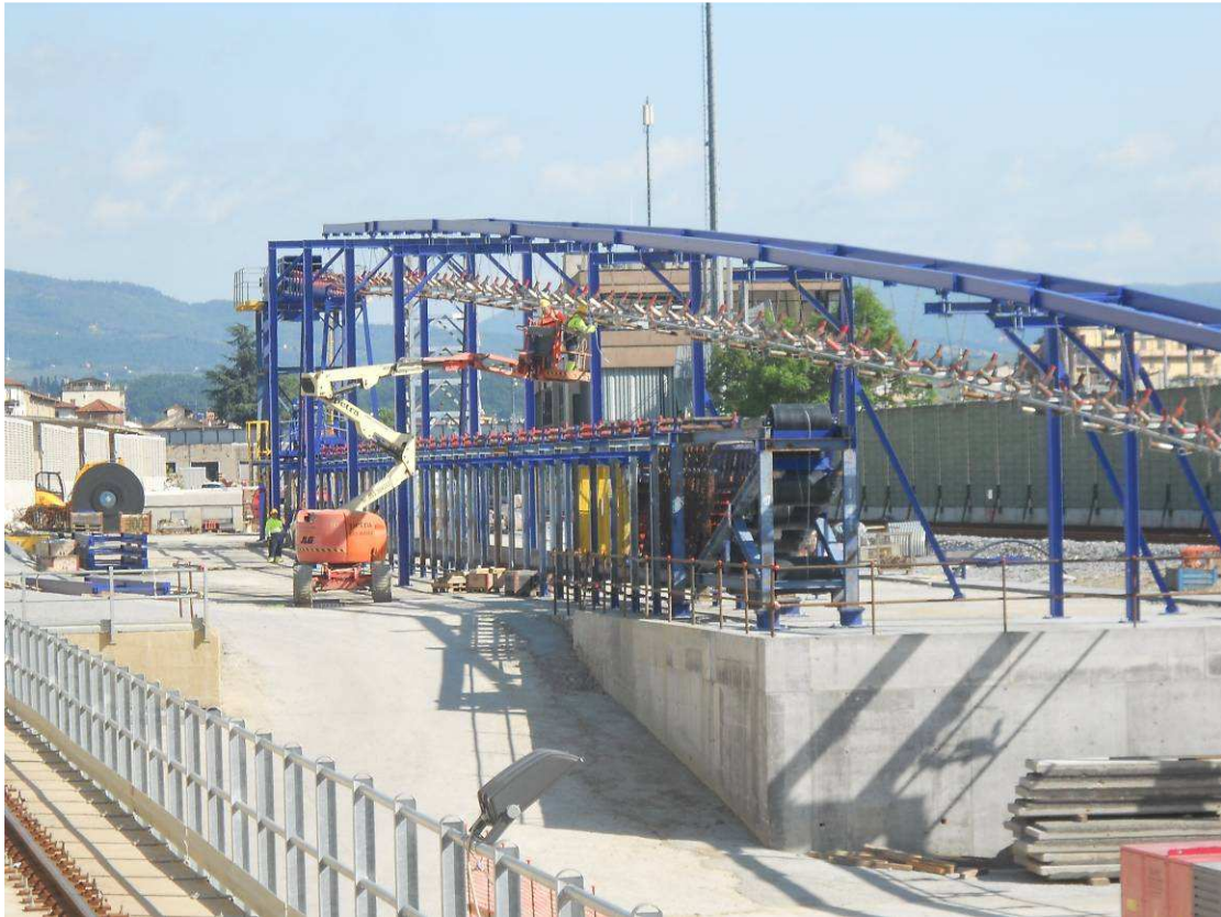
FOTO 4 – Assemblaggio strutture nastro trasporto smarino
