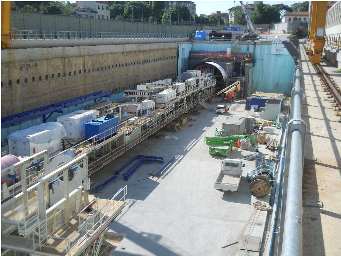
FOTO 1 – Pozzo Lancio Frese – assemblaggio back-up TBM
