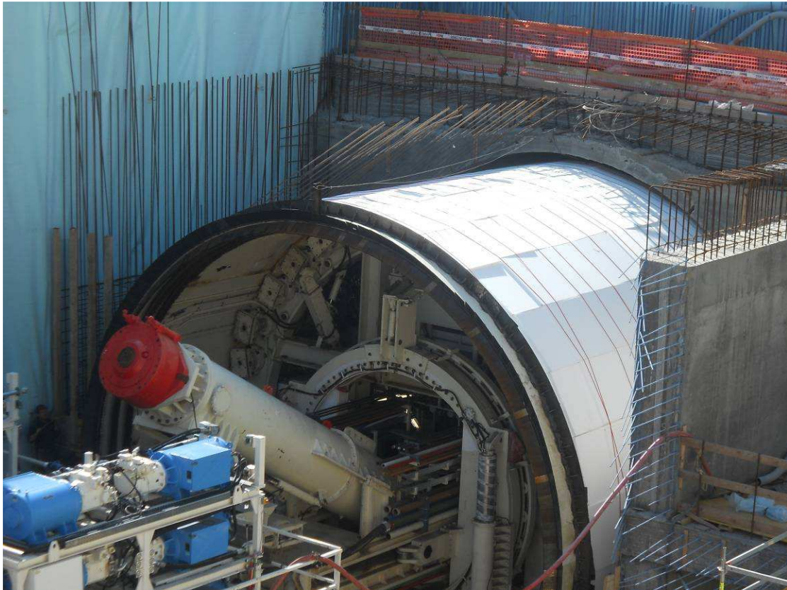
FOTO 2 – Pozzo lancio frese – assemblaggio componenti TBM
