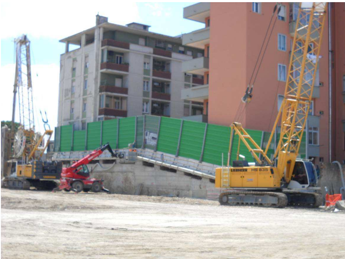
Foto 3: barriere antirumore sopra trave coronamento Paratia n°5
