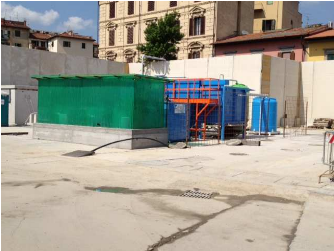
FOTO 2 –Messa in funzione dell'impianto trattamento acque
