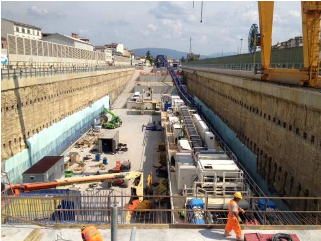
FOTO 1 – Pozzo lancio frese – assemblaggio componenti TBM
