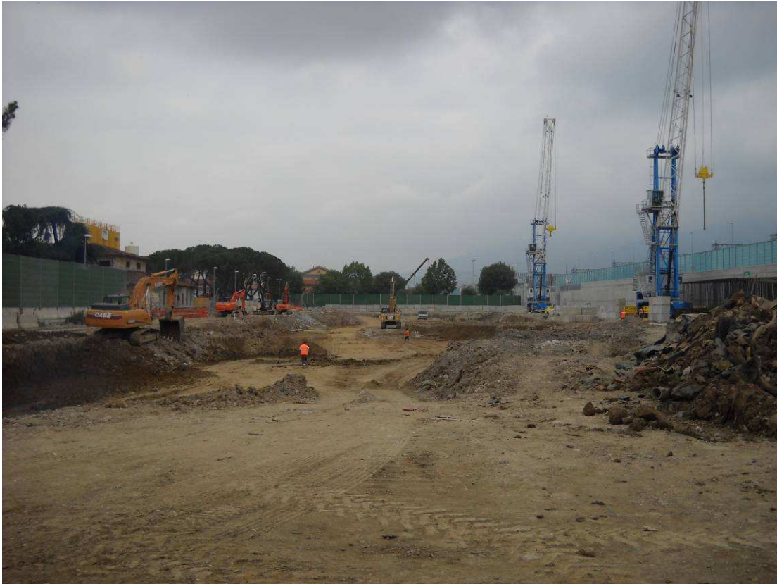
Foto 2: sbancamento da quota +46,00 m a +44,00 m s.l.m.
