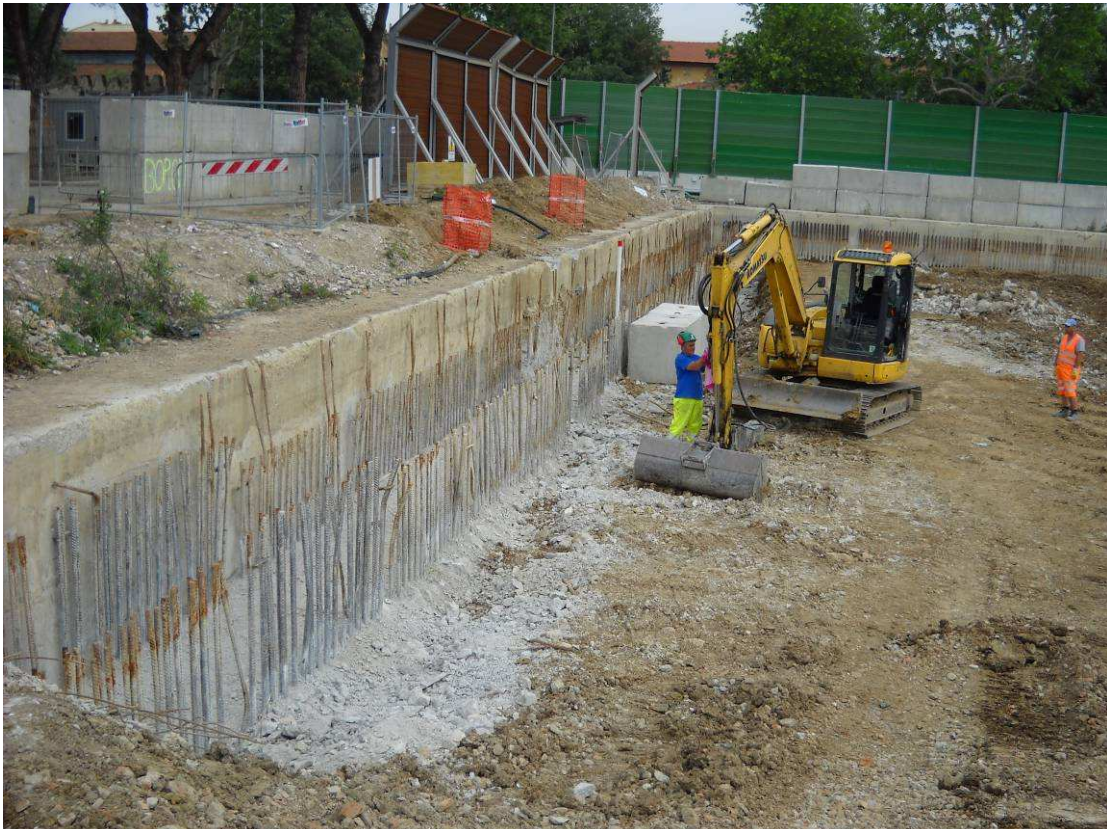
Foto 3: pulizia teste diaframmi Camerone (testata NORD)
