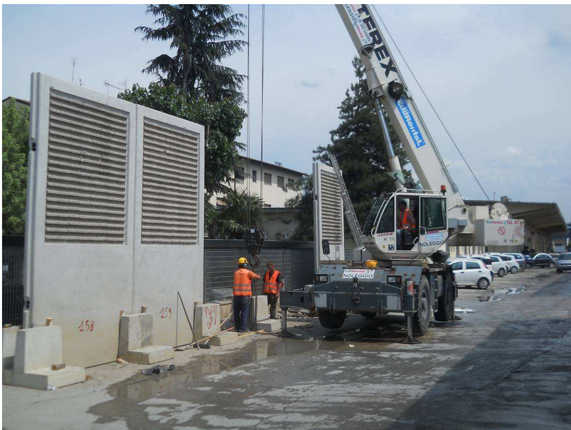
FOTO 3 – Spostamento barriere antirumore
