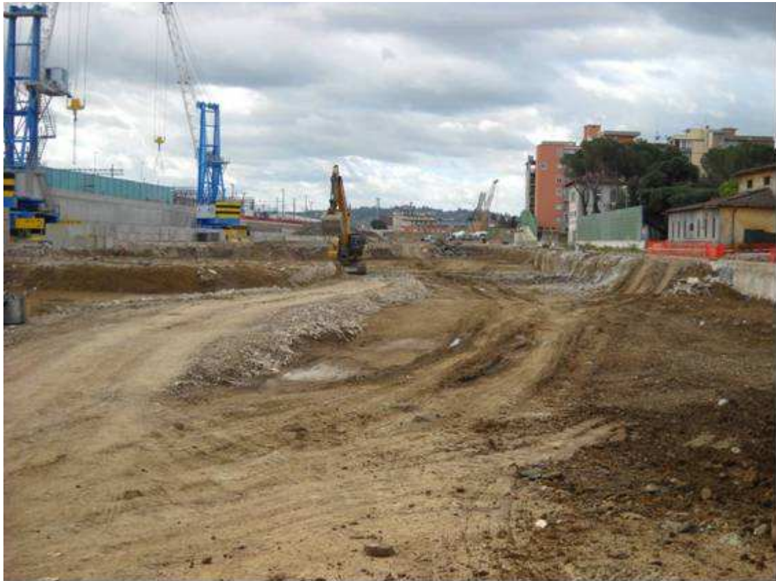
Foto 2: sbancamento da quota +46,00 m a +44,00 m s.l.m.
