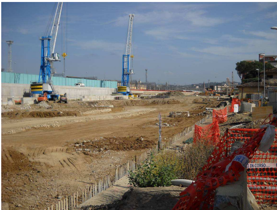
Foto 1: sbancamento da quota +46,00 m a +44,00 m s.l.m.
