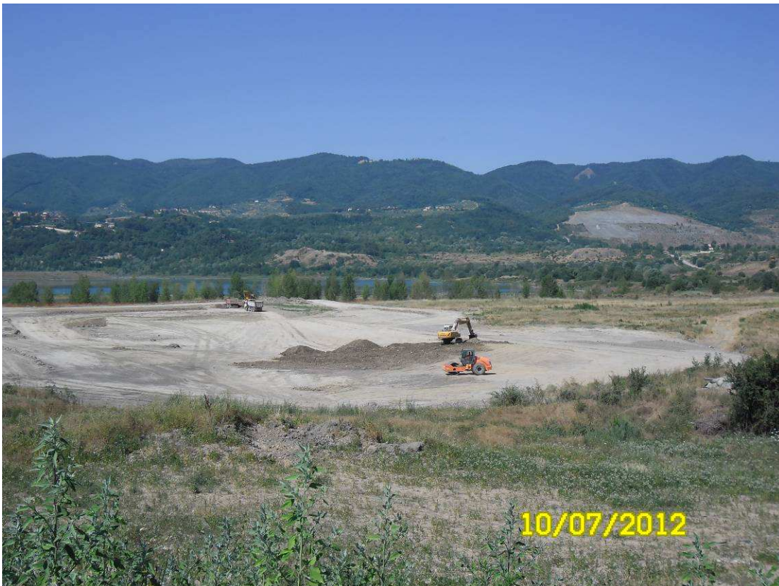
FOTO 3 – Località S.Barbara – Piazzole di stoccaggio – Movimenti terra
