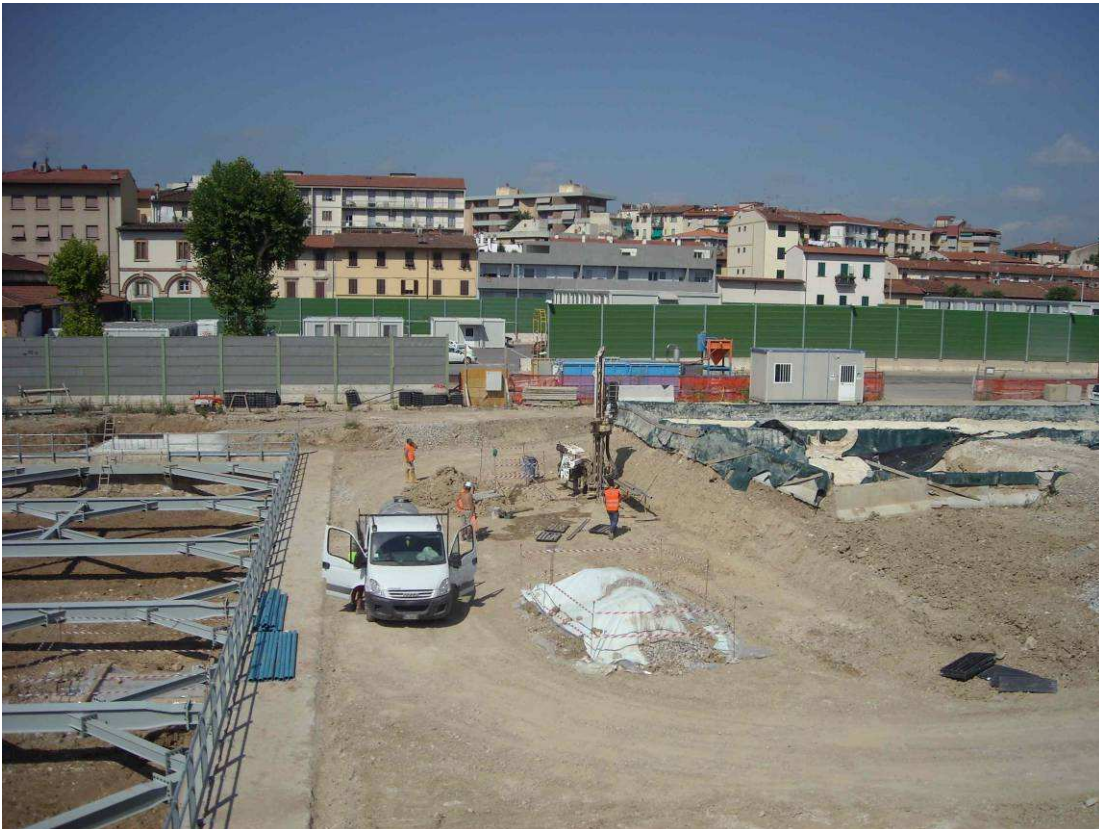
FOTO 5 – Pozzo di ventilazione nord – Prove sui consolidamenti
