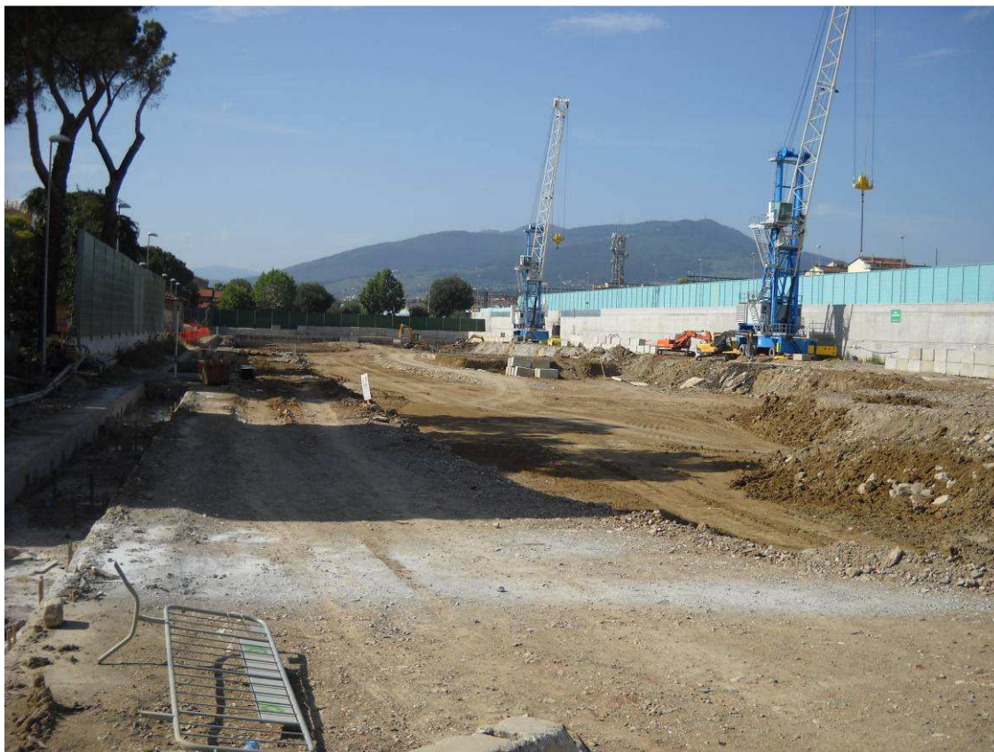
Foto 1: sbancamento da quota +46,00 m a +44,00 m s.l.m.
