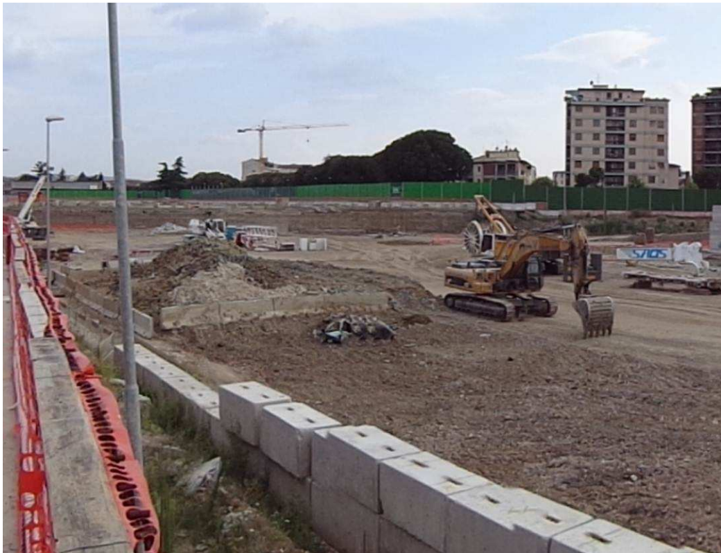
Foto 3: smantellamento piazzola stoccaggio terre diaframmi Camerone
