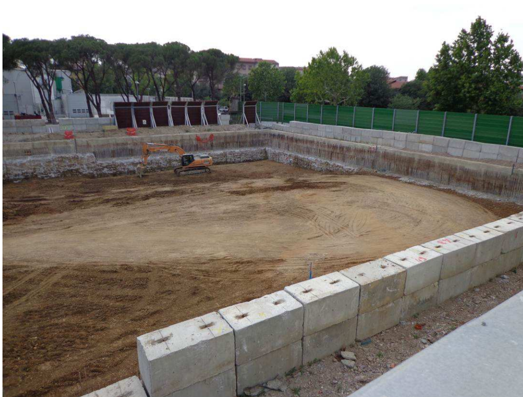
Foto 1: sbancamento da quota +44,00 m a +41,00 m s.l.m.
