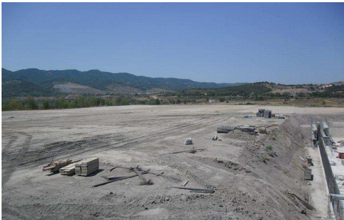
Foto 3 - Località S.Barbara – Piazzole di stoccaggio – Movimenti terra
