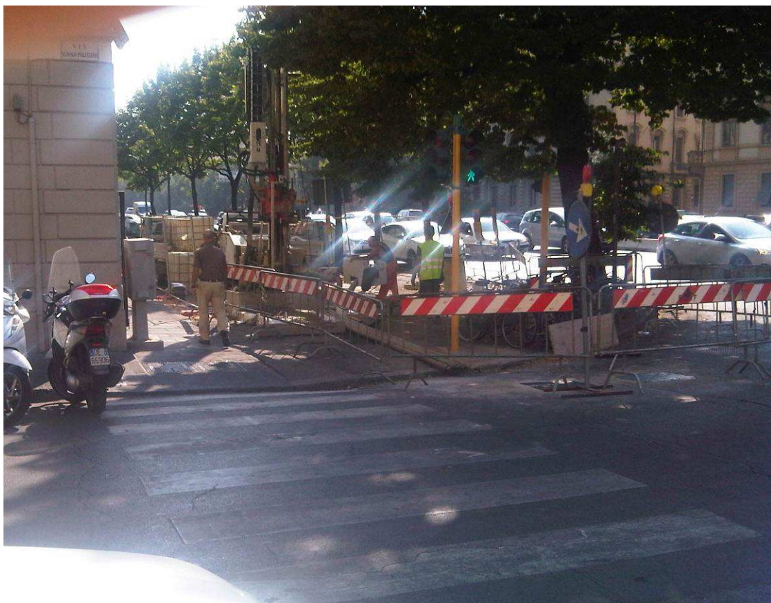
Foto 5 - Viale Spartaco Lavagnini – Installazione monitoraggio lungo linea
