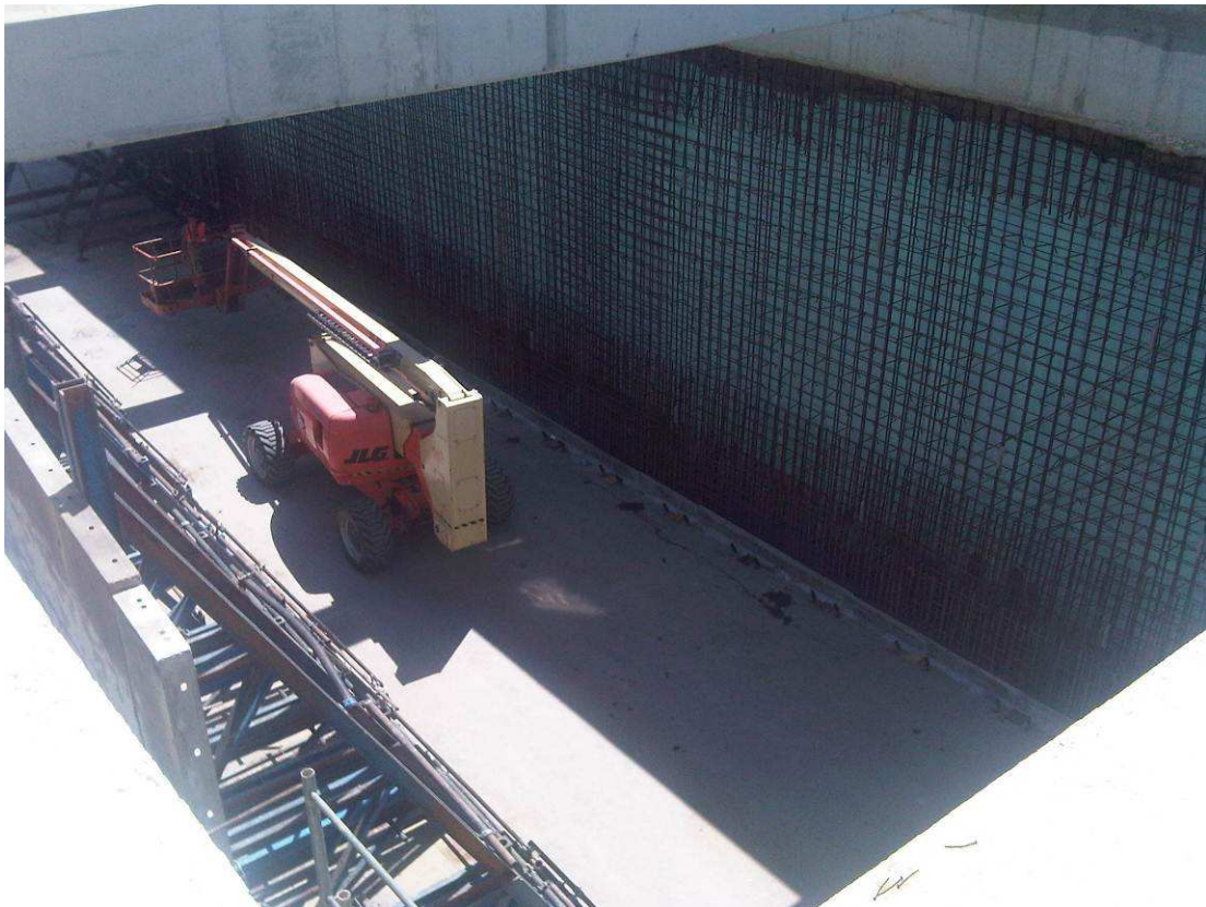
Foto 4 - Campo di Marte – TR01 Realizzazione pareti di rivestimento
