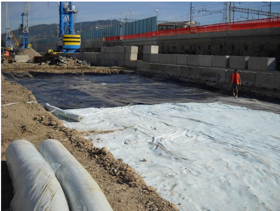
Foto 3: piazzole stoccaggio terre di scavo pali
