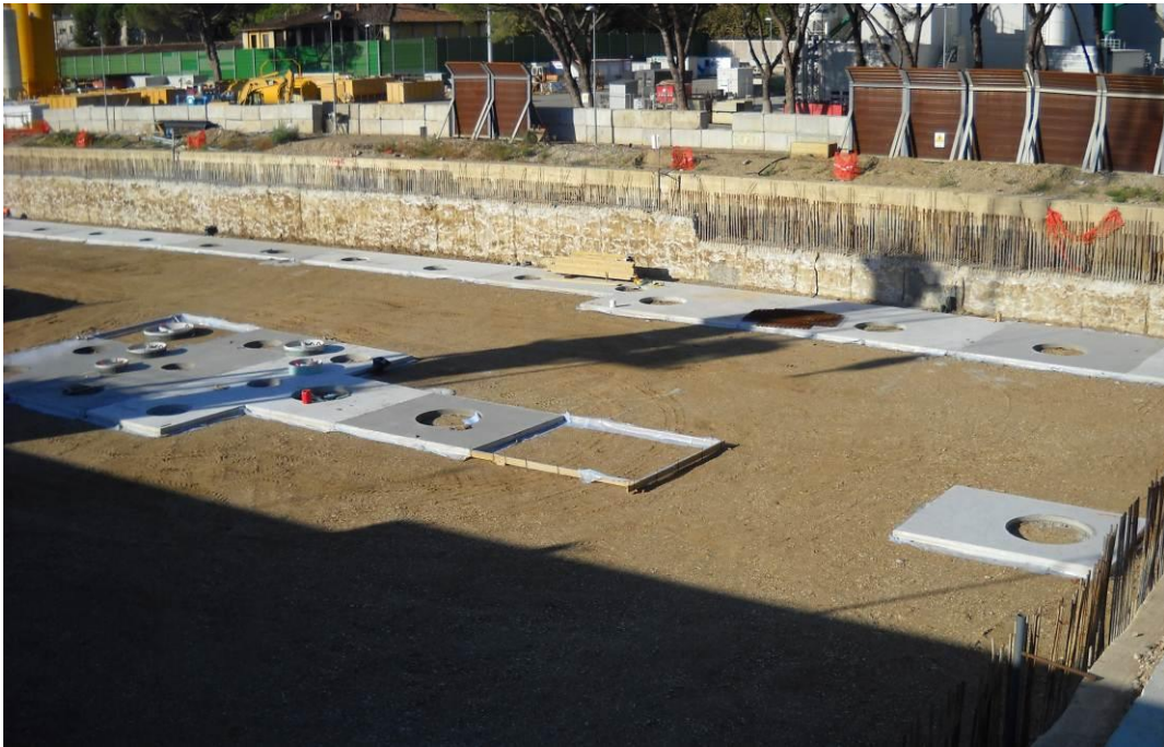
Foto 4: platee-guida in cls per pali-colonna
