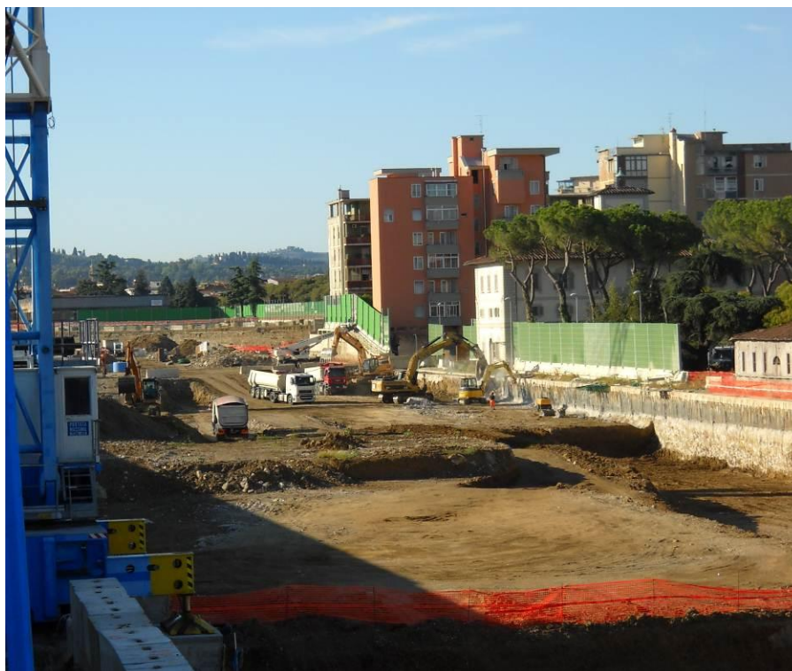
Foto 1: sbancamento da quota +44,00 m a +41,00 m s.l.m.
