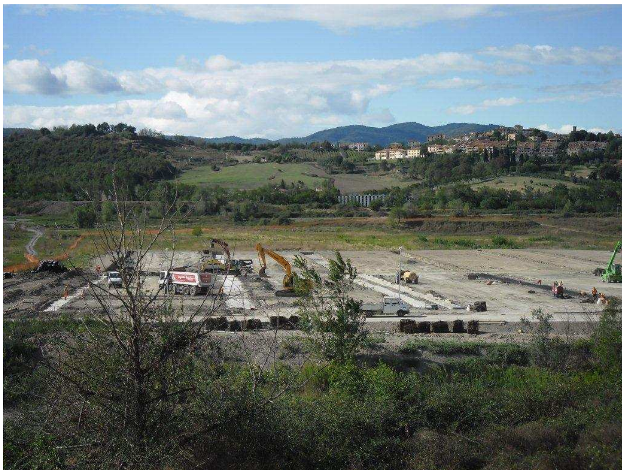
FOTO 1– Località S.Barbara – Piazzole di stoccaggio Fase 2 – Movimenti terra
