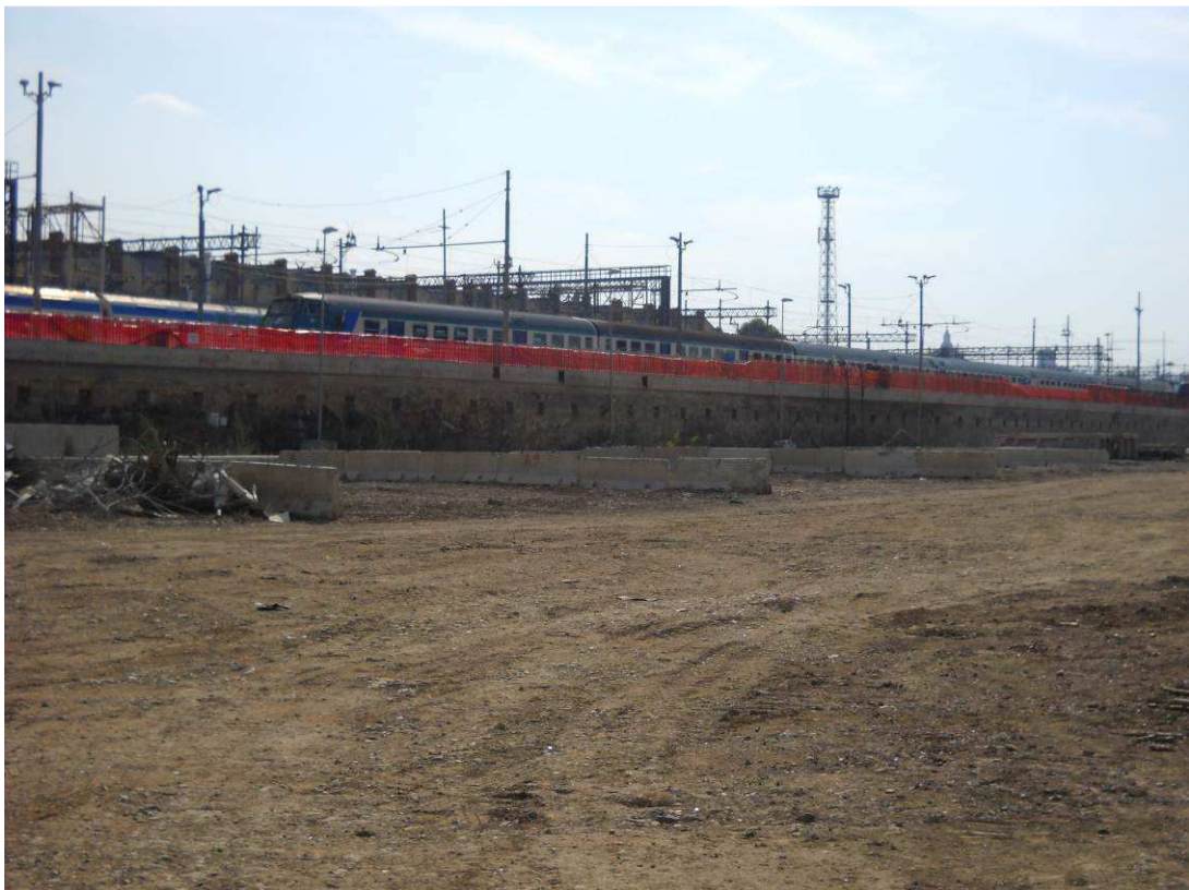
Foto 3: nuove piazzole stoccaggio terre di scavo pali
