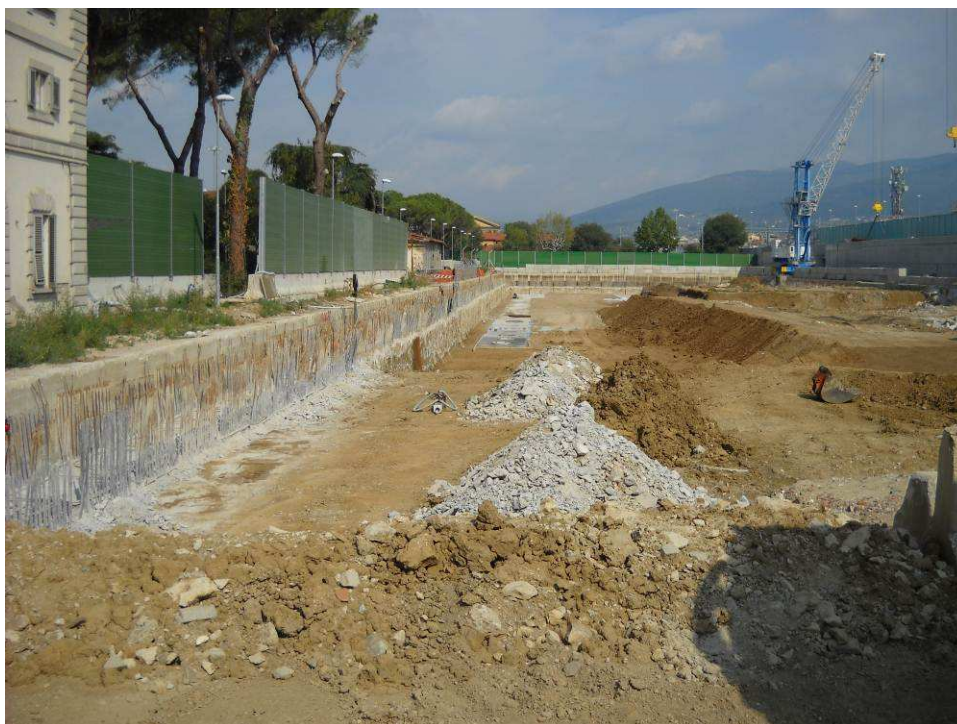
Foto 1: sbancamento da quota +44,00 m a +41,00 m s.l.m.
