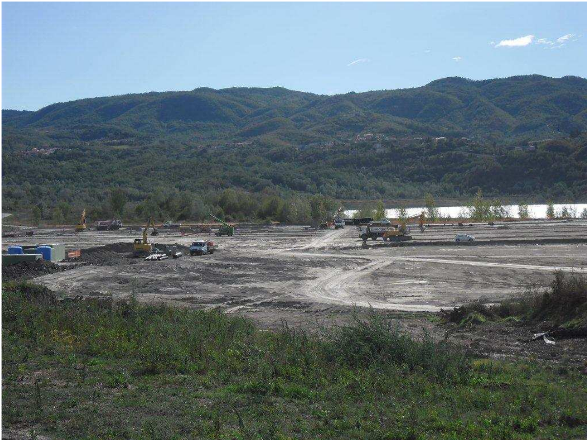
FOTO 2– Località S.Barbara – Piazzole di stoccaggio Fase 2 – Movimenti terra
