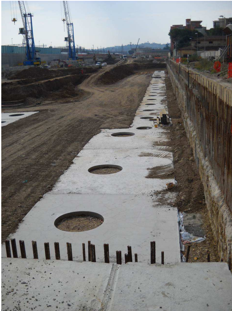
Foto 4: platee-guida in cls per pali-colonna
