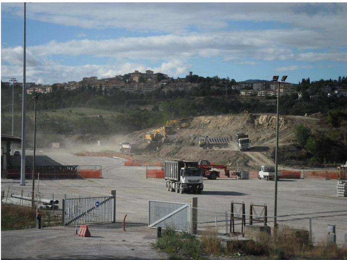
FOTO 3 – Località Bricchette– Fase 2 Terminal
