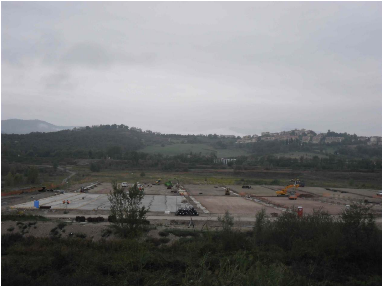
Foto 1– Località S.Barbara – Piazzole di stoccaggio Fase 2 – Movimenti terra e fondazioni
