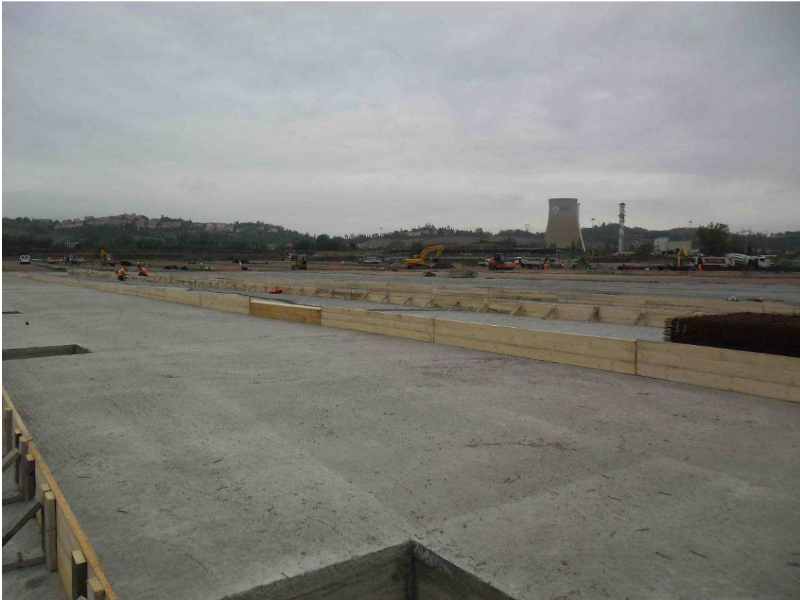
Foto 2 – Località S.Barbara – Piazzole di stoccaggio Fase 2 – Fondazioni
