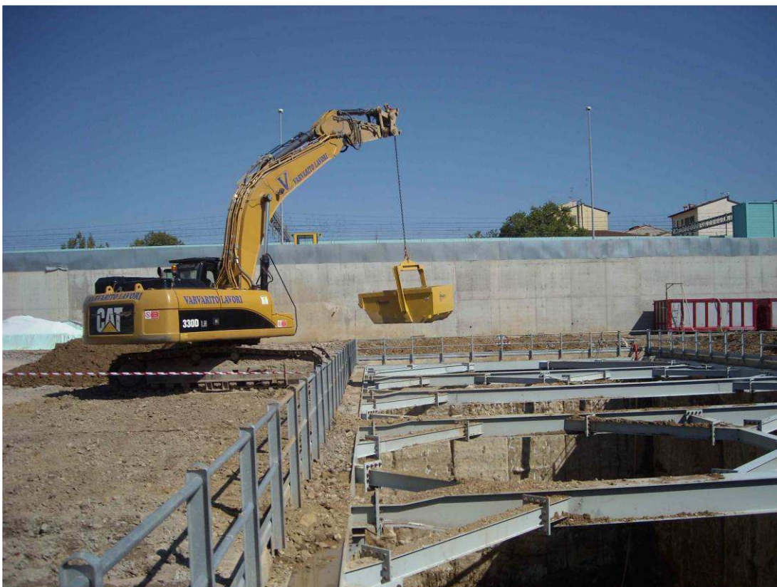
Foto 5 – Pozzo di ventilazione nord – Scavo 2 a Fase
