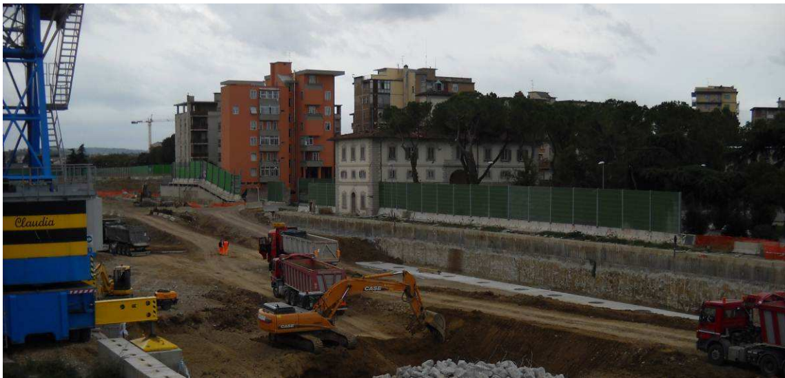
Foto 1 - sbancamento da quota +44,00 m a +41,00 m s.l.m.
