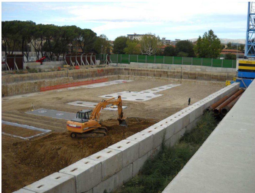
Foto 3 - platee-guida in cls per pali-colonna
