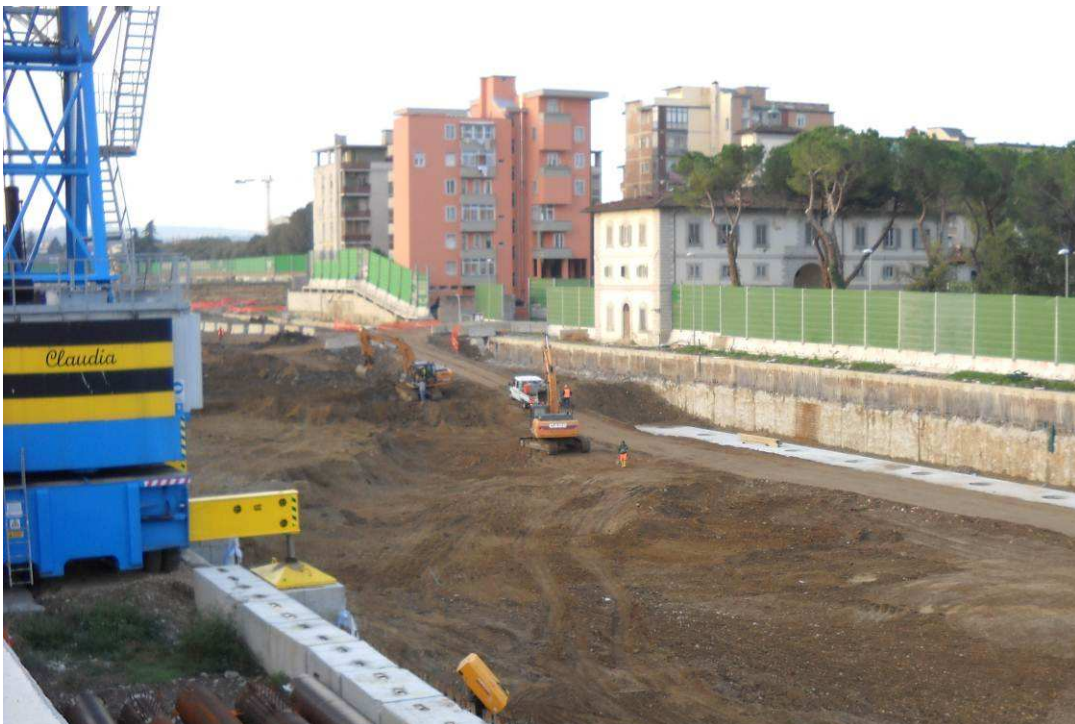
Foto 1- sbancamento da quota +44,00 m a +41,00 m s.l.m.
