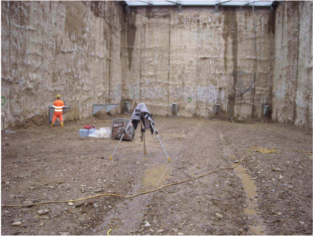
Foto 4 – Pozzo di ventilazione nord – Monitoraggi strutturali
