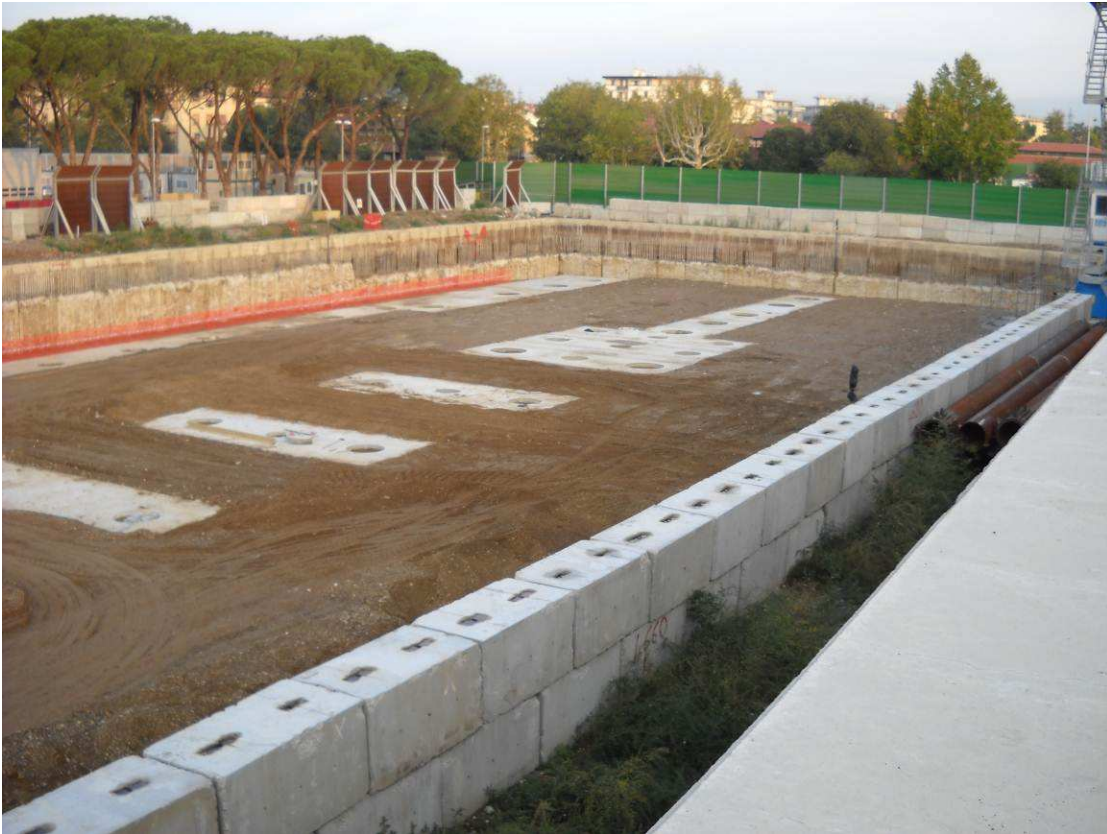
Foto 2-platee-guida in cls per pali-colonna
