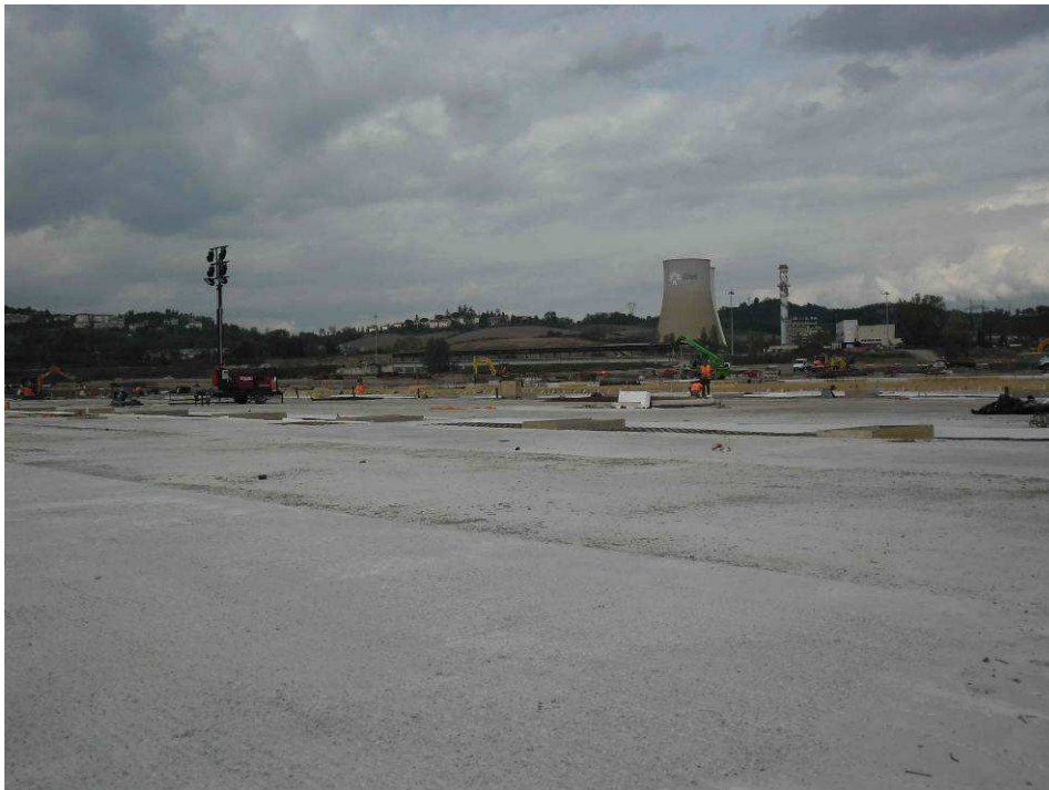
Foto 3 – Località Bricchette– Fase 2 Terminal
