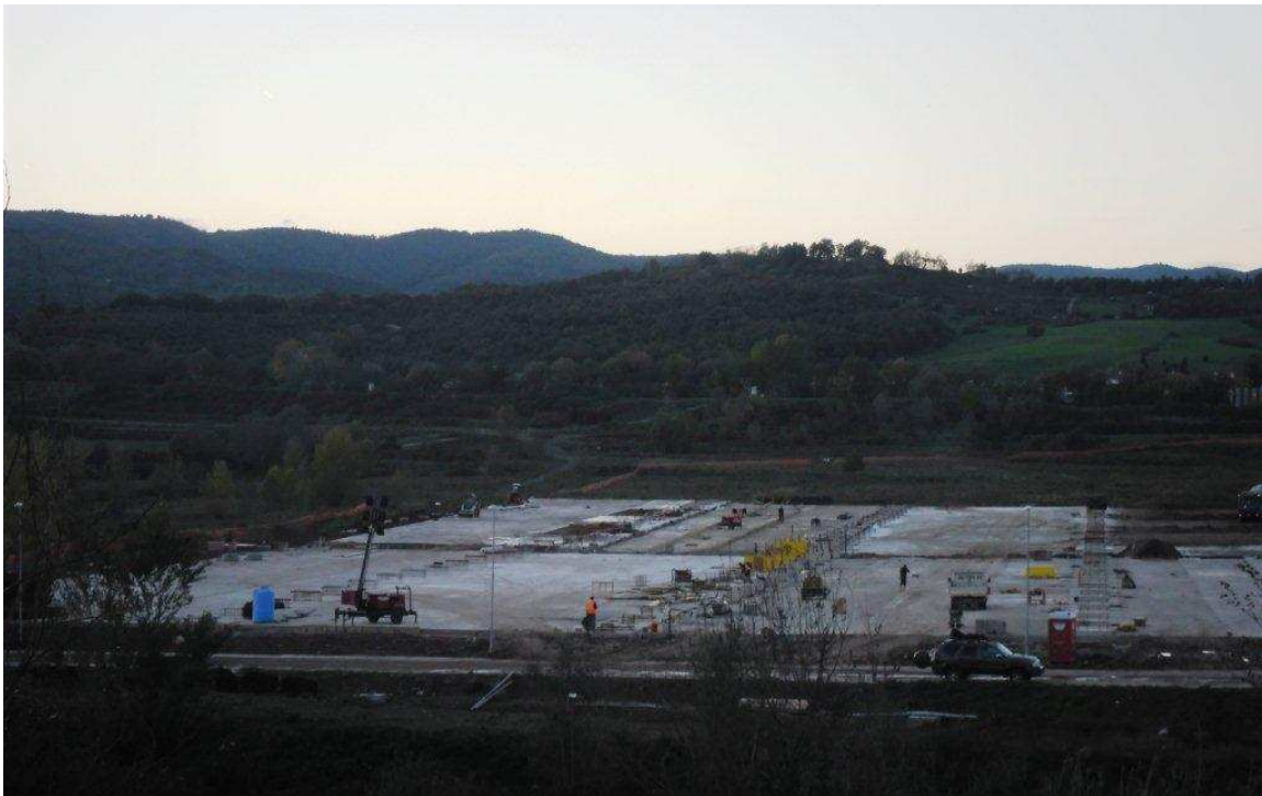
Foto 1 – Località S.Barbara – Piazzole di stoccaggio Fase 2 – Fondazioni
