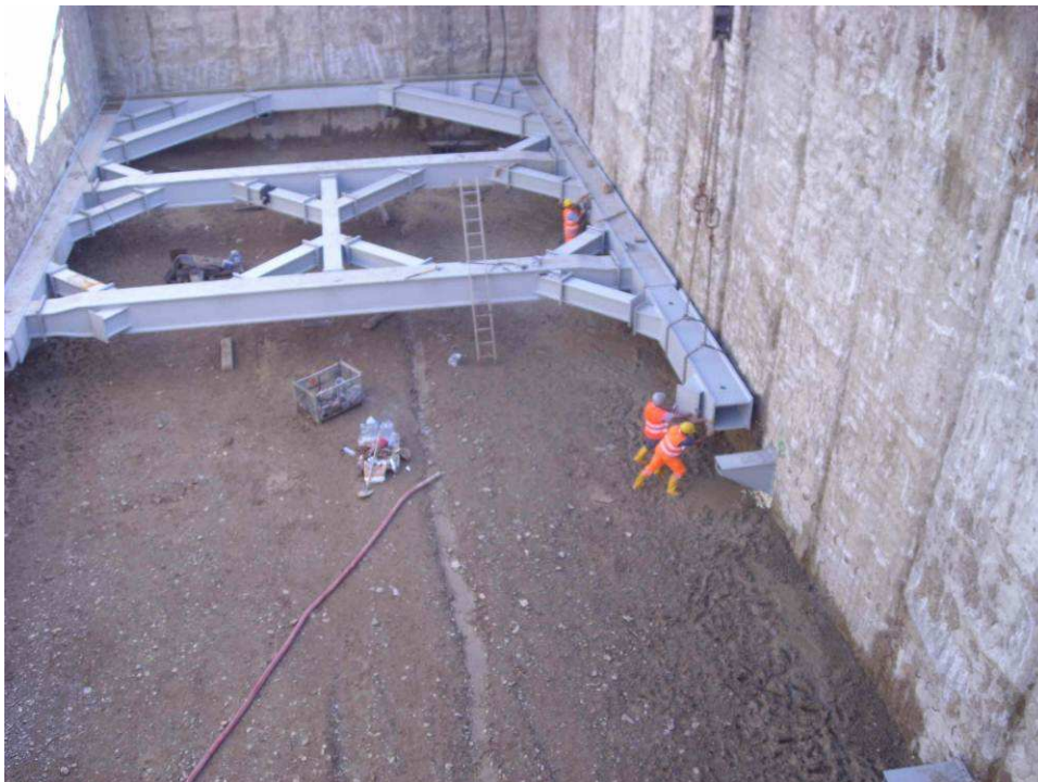
Foto 3 – Pozzo di ventilazione nord – Montaggio 2° ordine di centine
