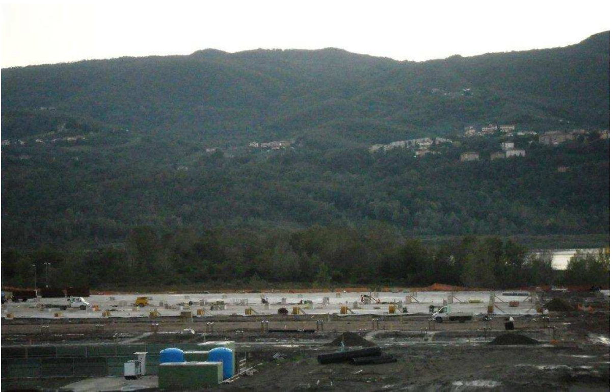
Foto 2 – Località S.Barbara – Piazzole di stoccaggio Fase 2 – Fondazioni
