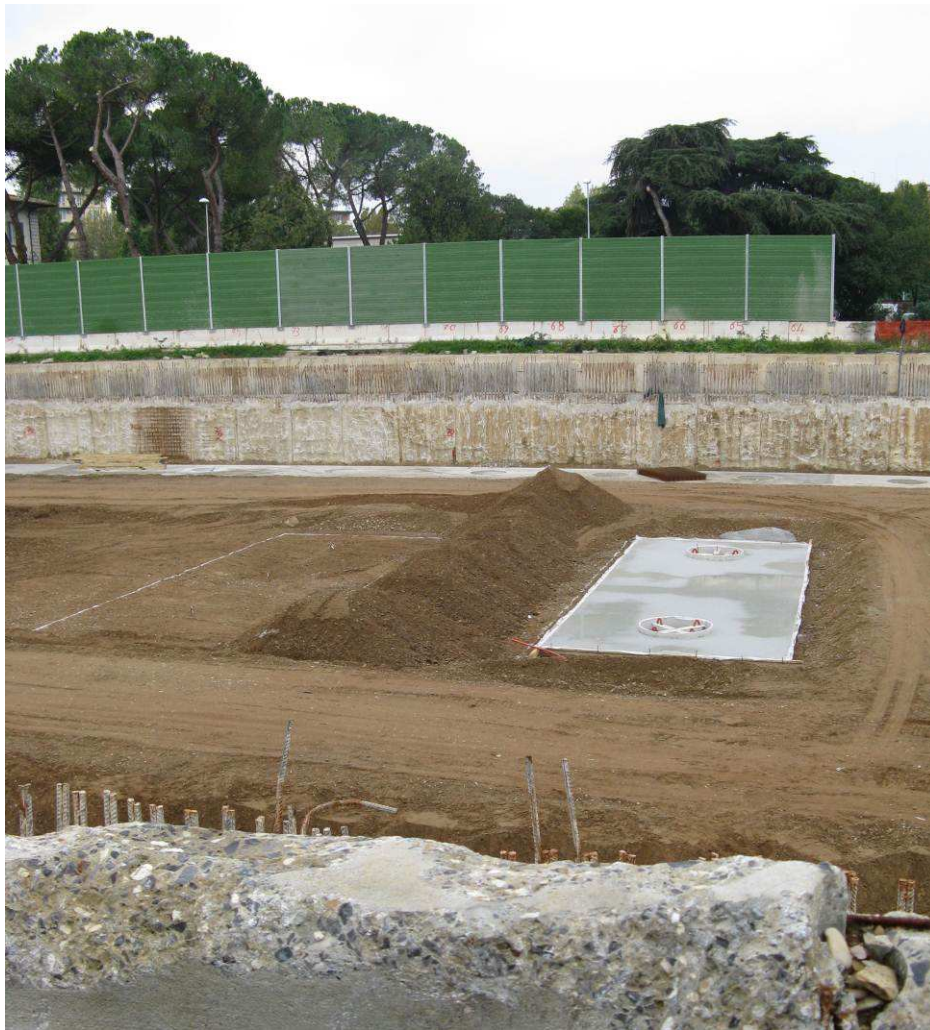
Foto 2 - platee-guida in cls per pali-colonna
