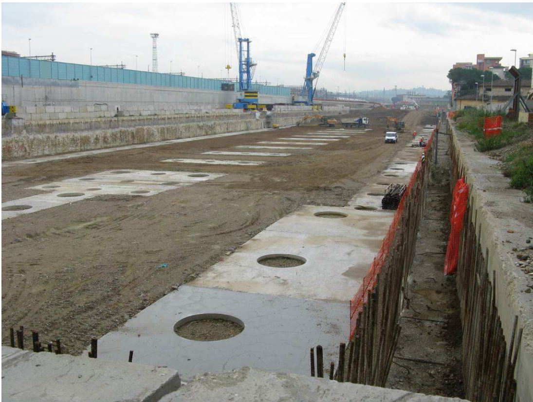
Foto 1 - sbancamento da quota +44,00 m a +41,00 m s.l.m.
