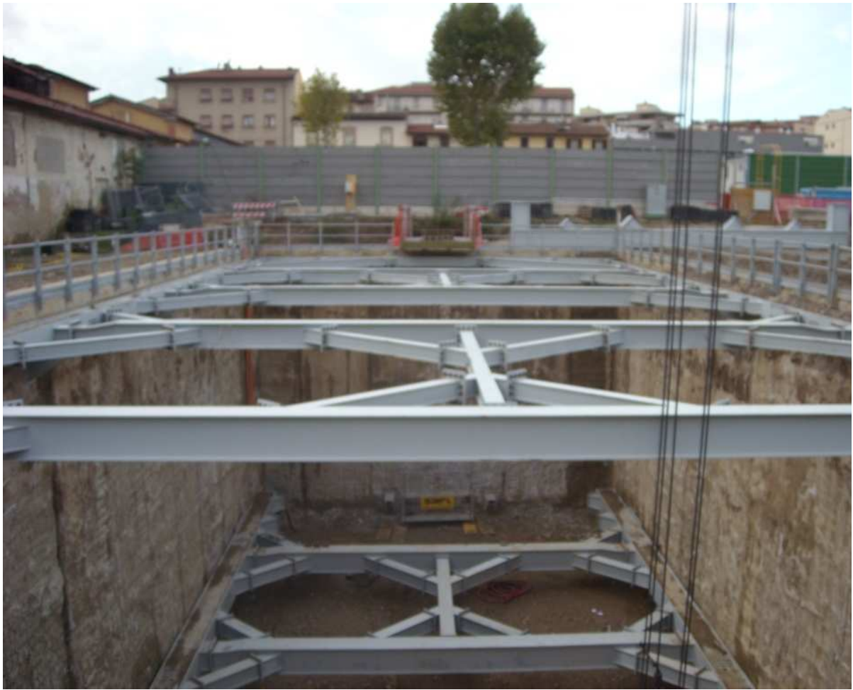
Foto 4 – Pozzo di ventilazione nord – Montaggio 2° ordine di cantine
