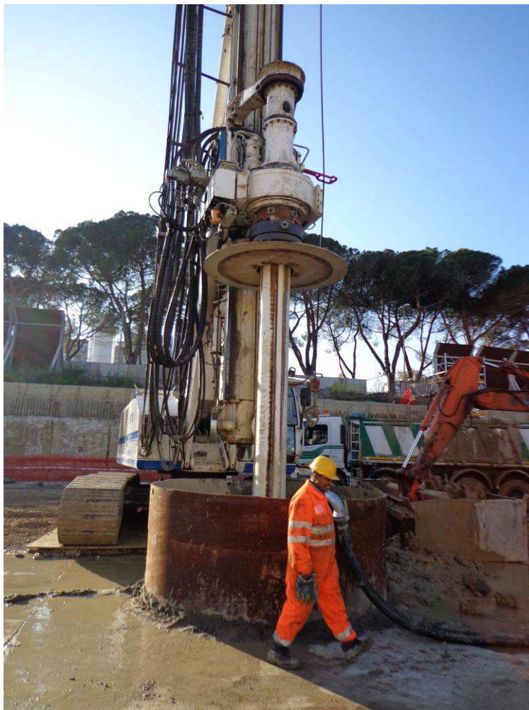
Foto 1 – Pali di Fondazione
