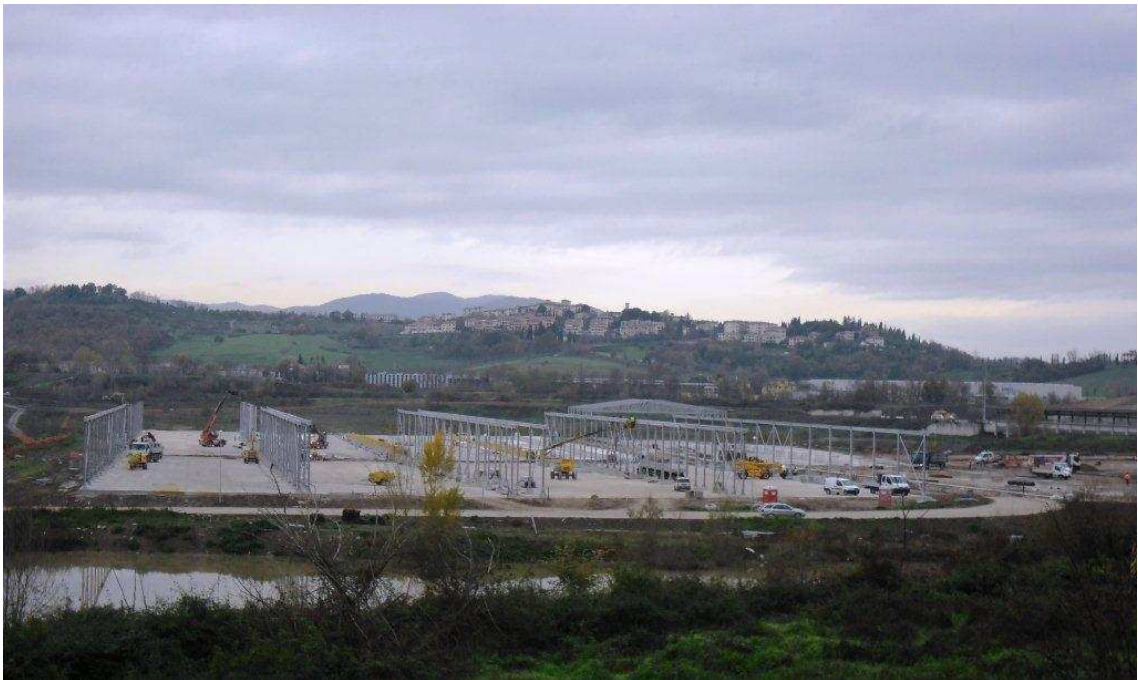
Foto 1– Località S.Barbara – Piazzole di stoccaggio Fase 2 – Coperture
