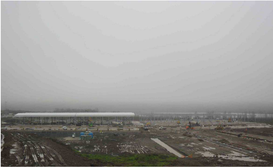
FOTO 2 – Località Bricchette – Piazzole di stoccaggio Fase 2 – Coperture
