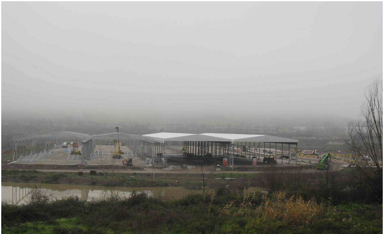
FOTO 1– Località S.Barbara – Piazzole di stoccaggio Fase 2 – Coperture
