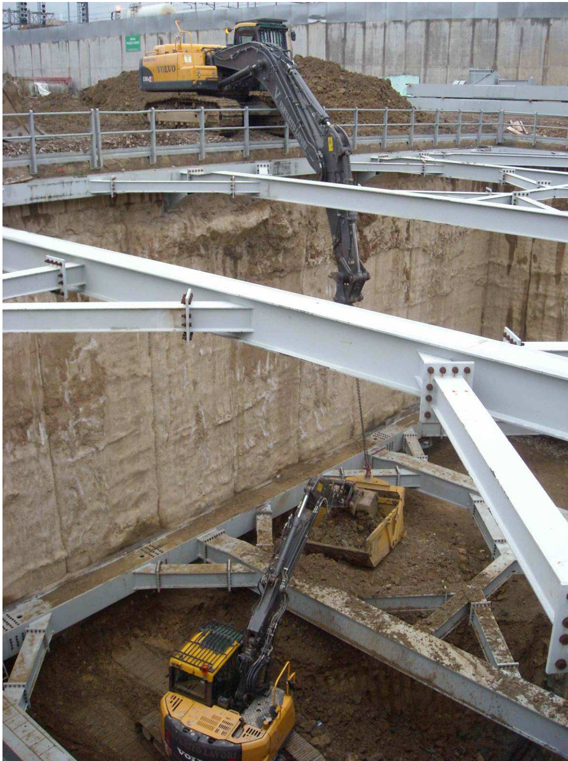
FOTO 2 – Pozzo Nord – Scavo da quota 34,60 m a 28,20 m
