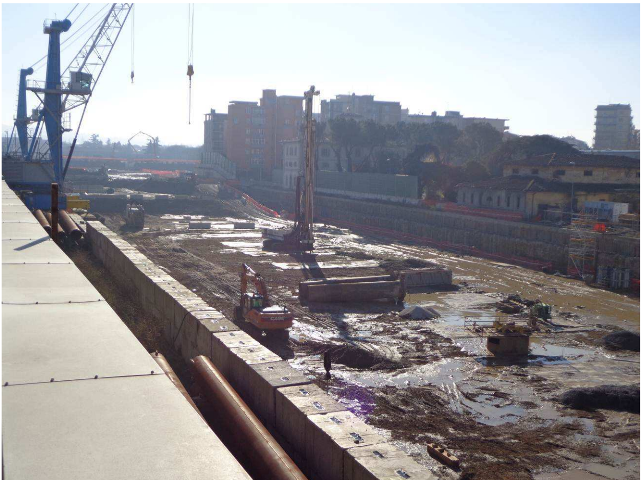
FOTO 1 – Pali di fondazione
