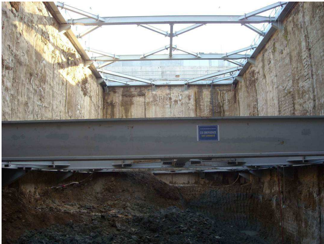
FOTO 3 – scavo da quota 34,60 a 28,20
