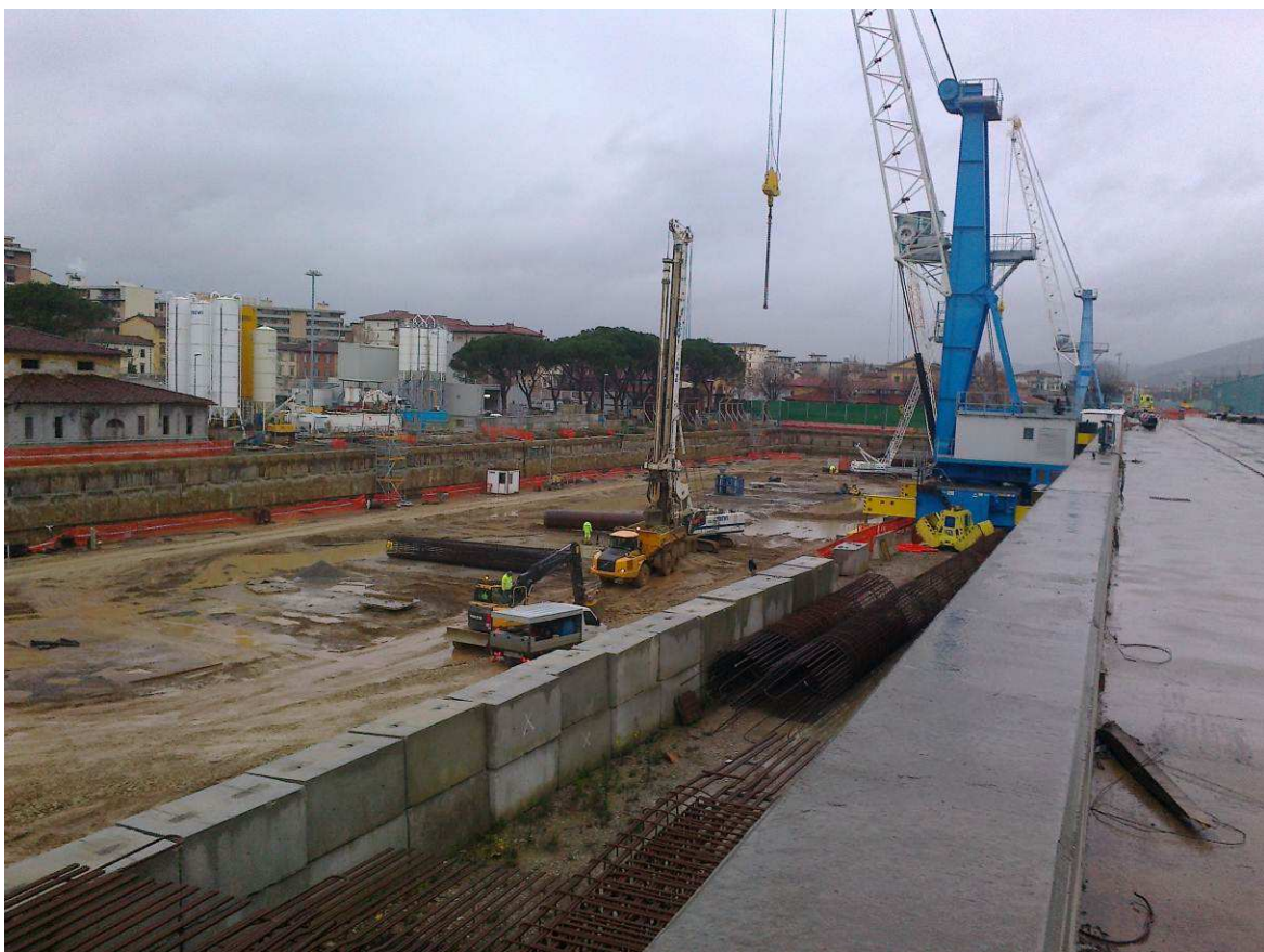
FOTO 1 - Pali di fondazione
