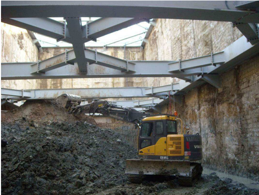
FOTO 2 – scavo da quota 34,60 a 28,20
