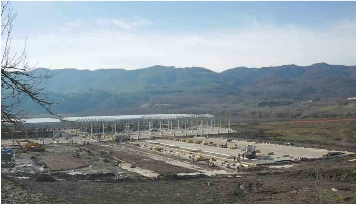
FOTO 2 – Località Bricchette–Piazzole di stoccaggio Fase 2
