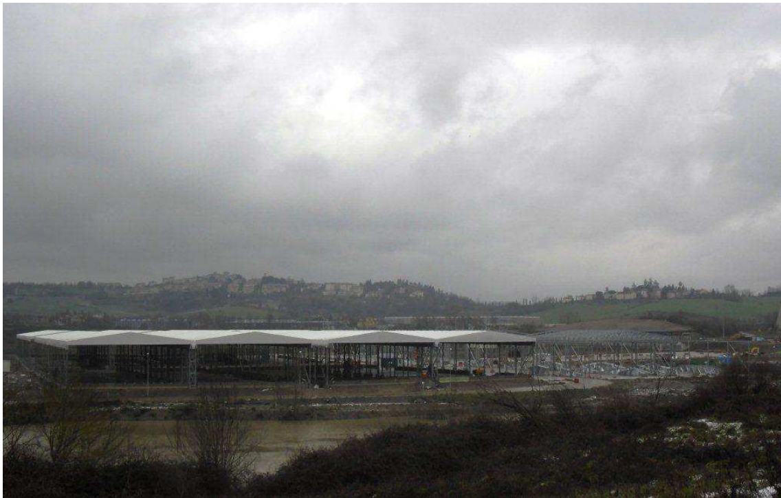
FOTO 1– Località S.Barbara –Piazzole di stoccaggio Fase 2
