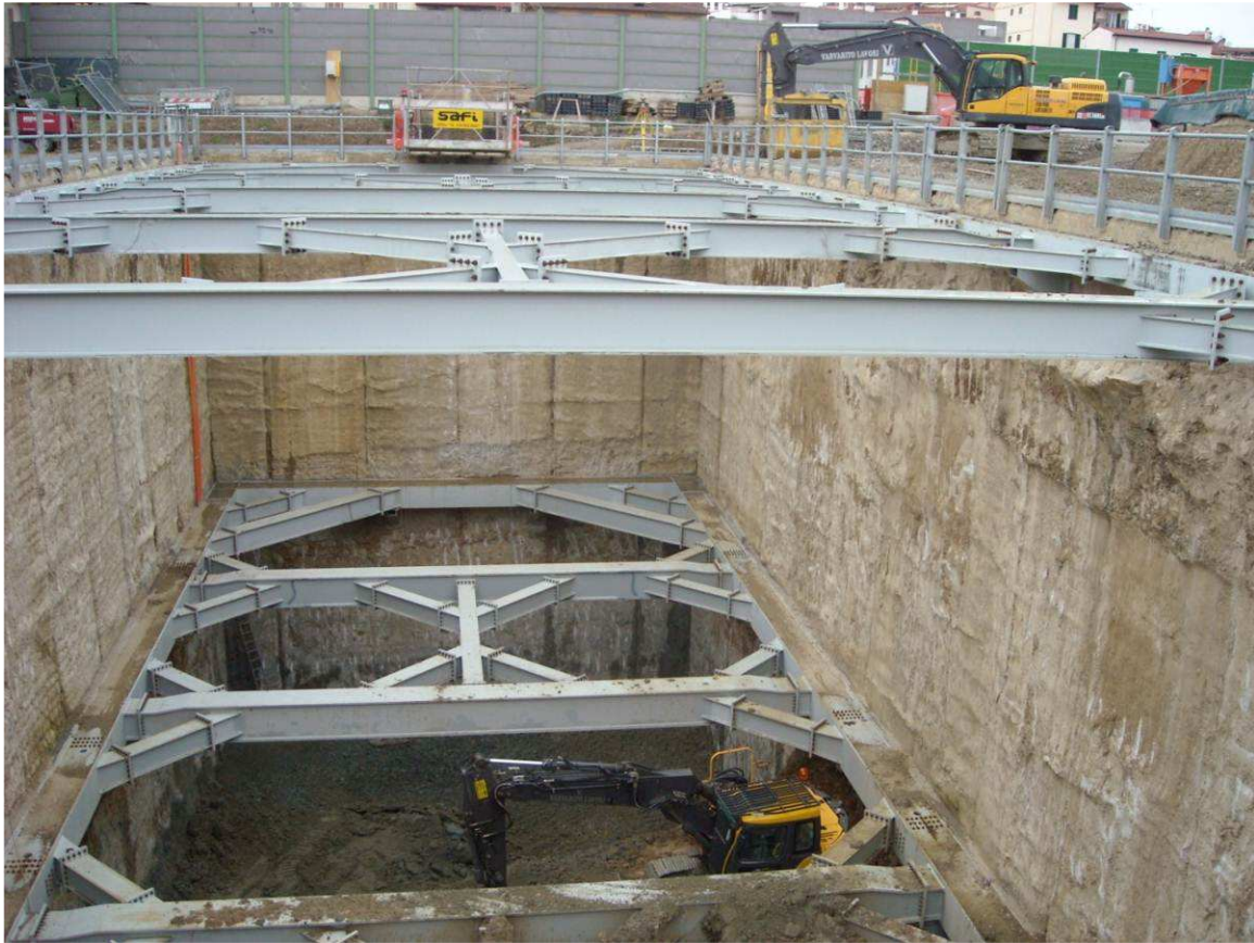
FOTO 3 – scavo da quota 34,60 a 28,20
