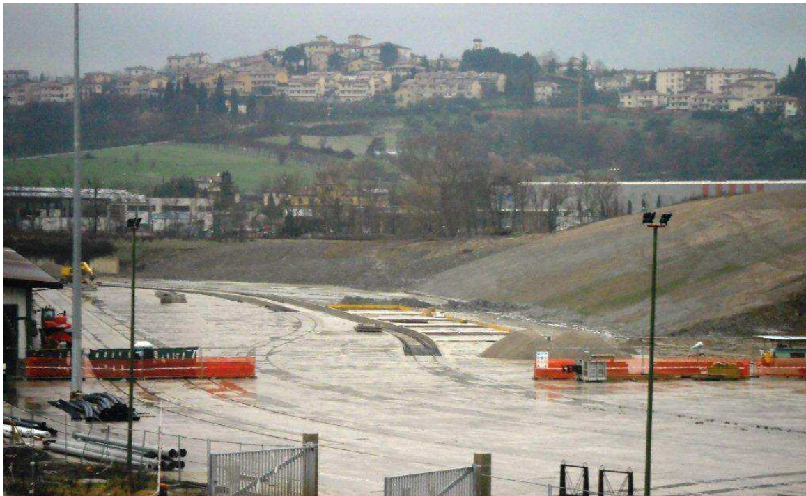
FOTO 3– Località Bricchette– Fase 2 Terminal
