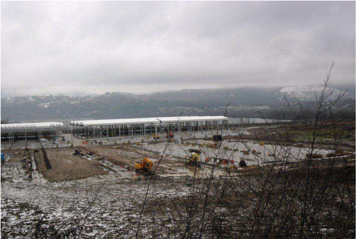
FOTO 2 – Località Bricchette– Piazzole di stoccaggio Fase 2 –
