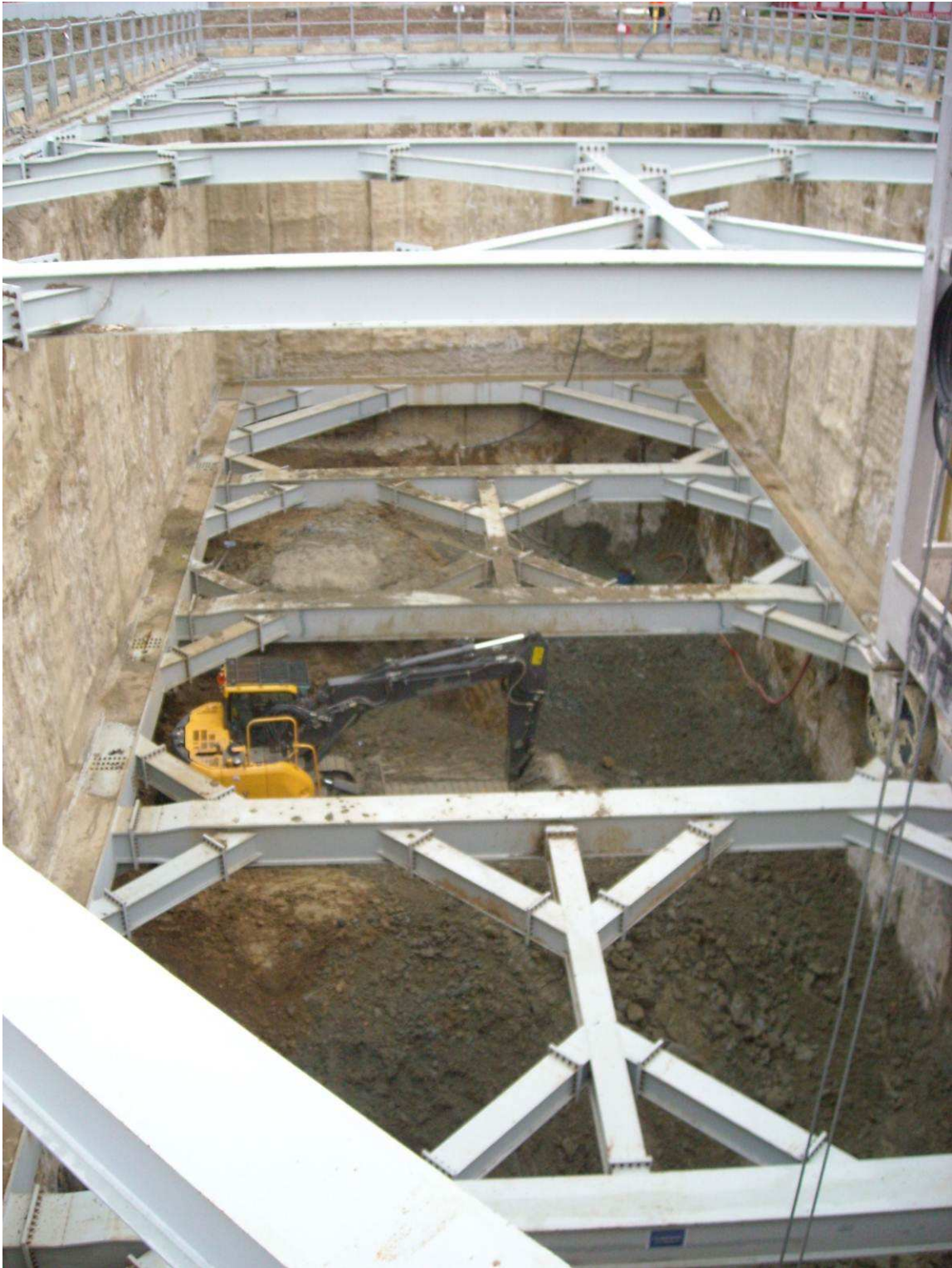
FOTO 2 – scavo da quota 34,60 a 28,20
