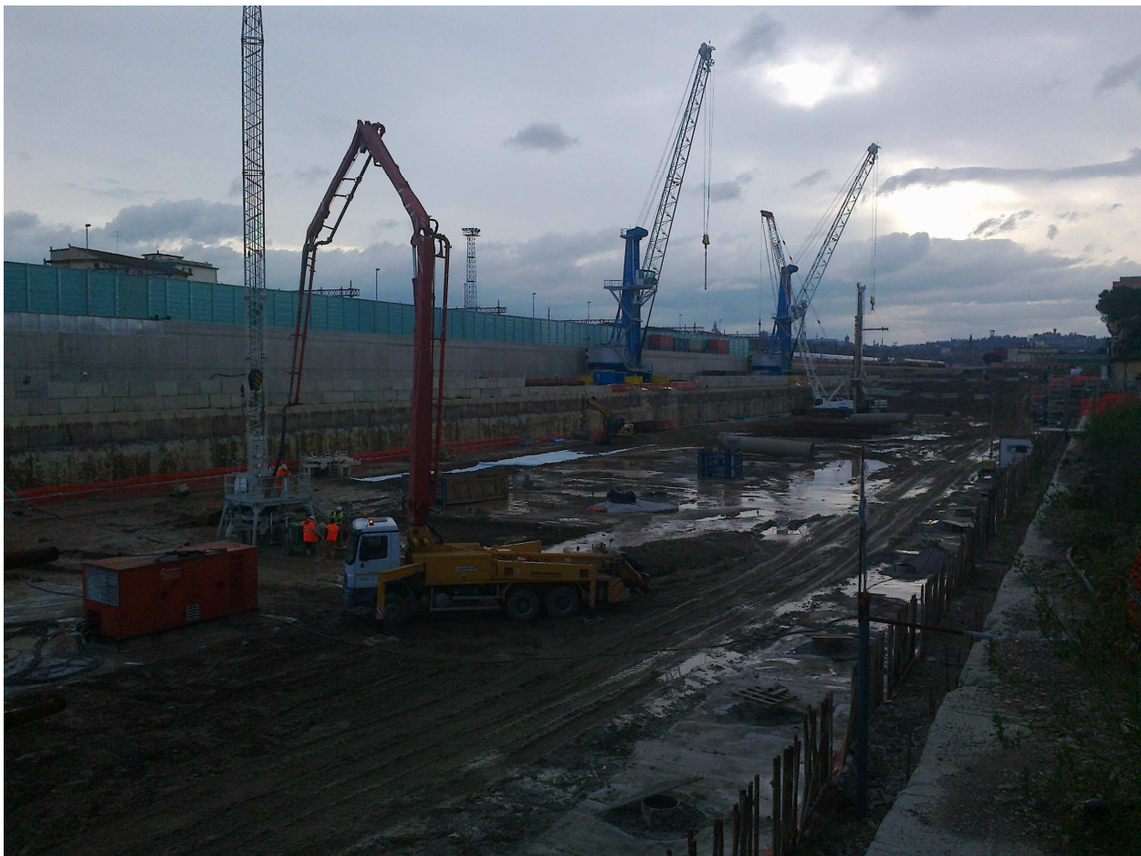
FOTO 1 - Pali di fondazione
