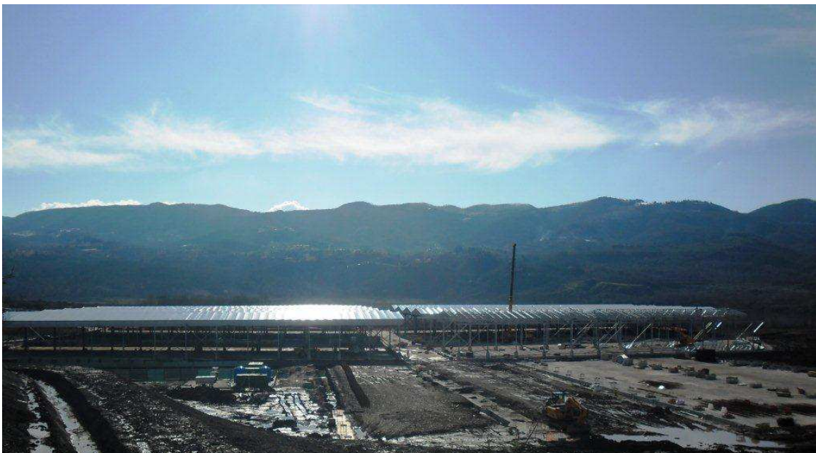
FOTO 2 – Località Bricchette – Piazzole di stoccaggio Fase 2
