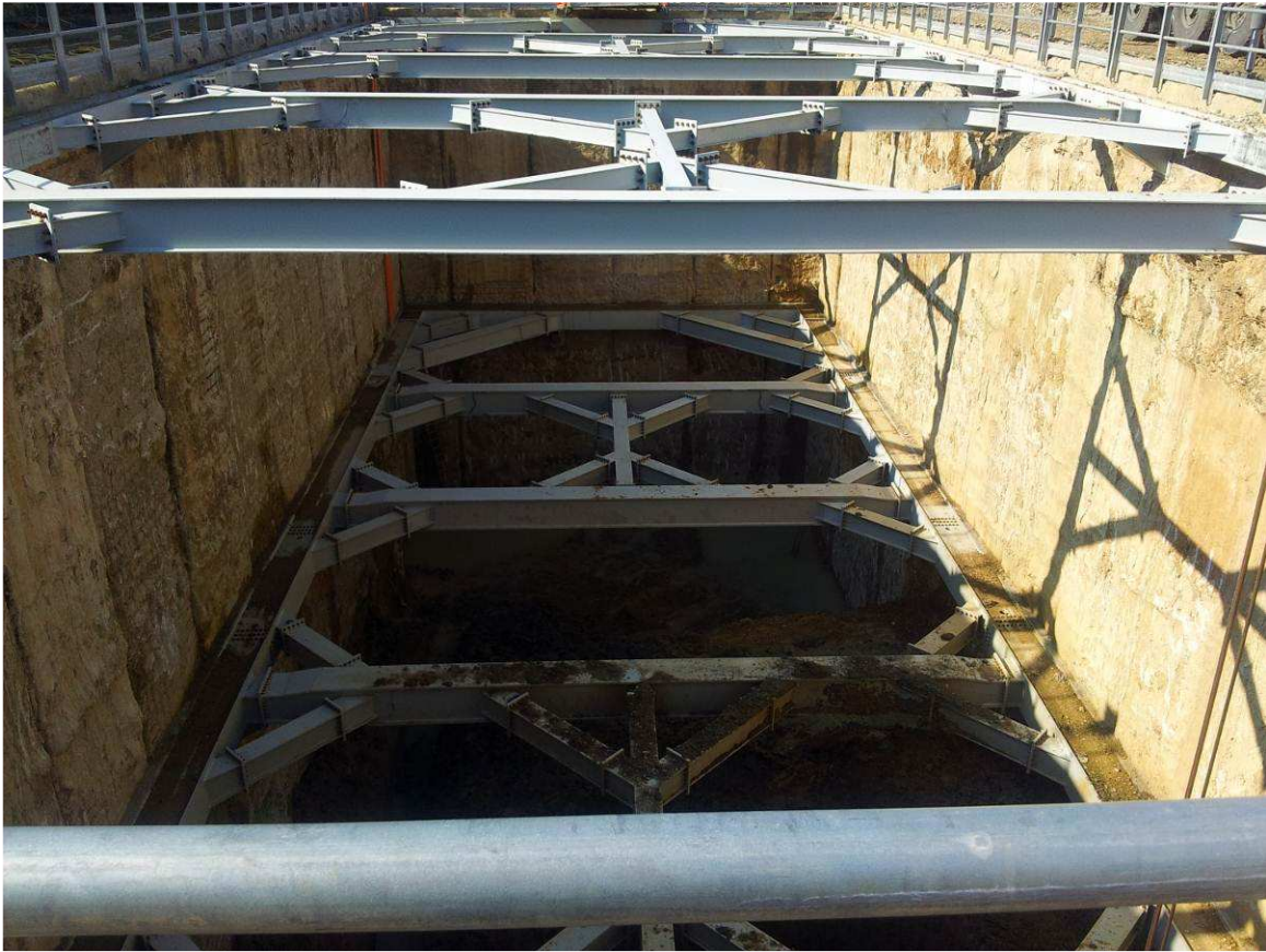
FOTO 3 – Pozzo Nord - 3° scavo da quota 34,60 a 28,20
