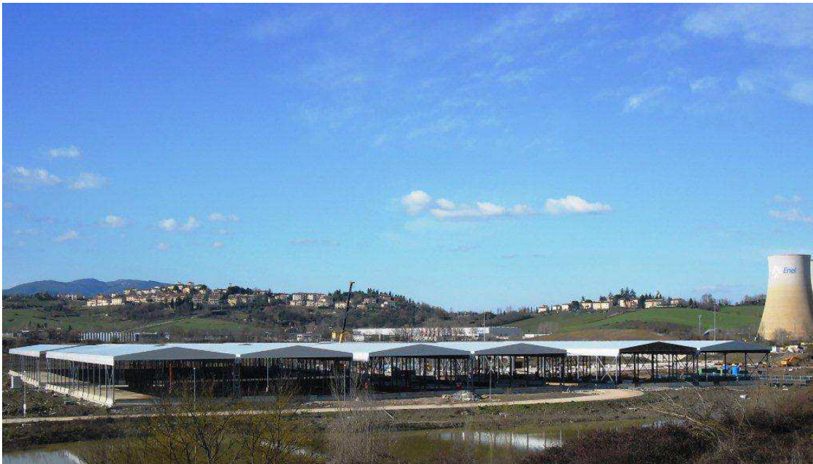
FOTO 1 – Località S. Barbara – Piazzole di stoccaggio Fase 2
