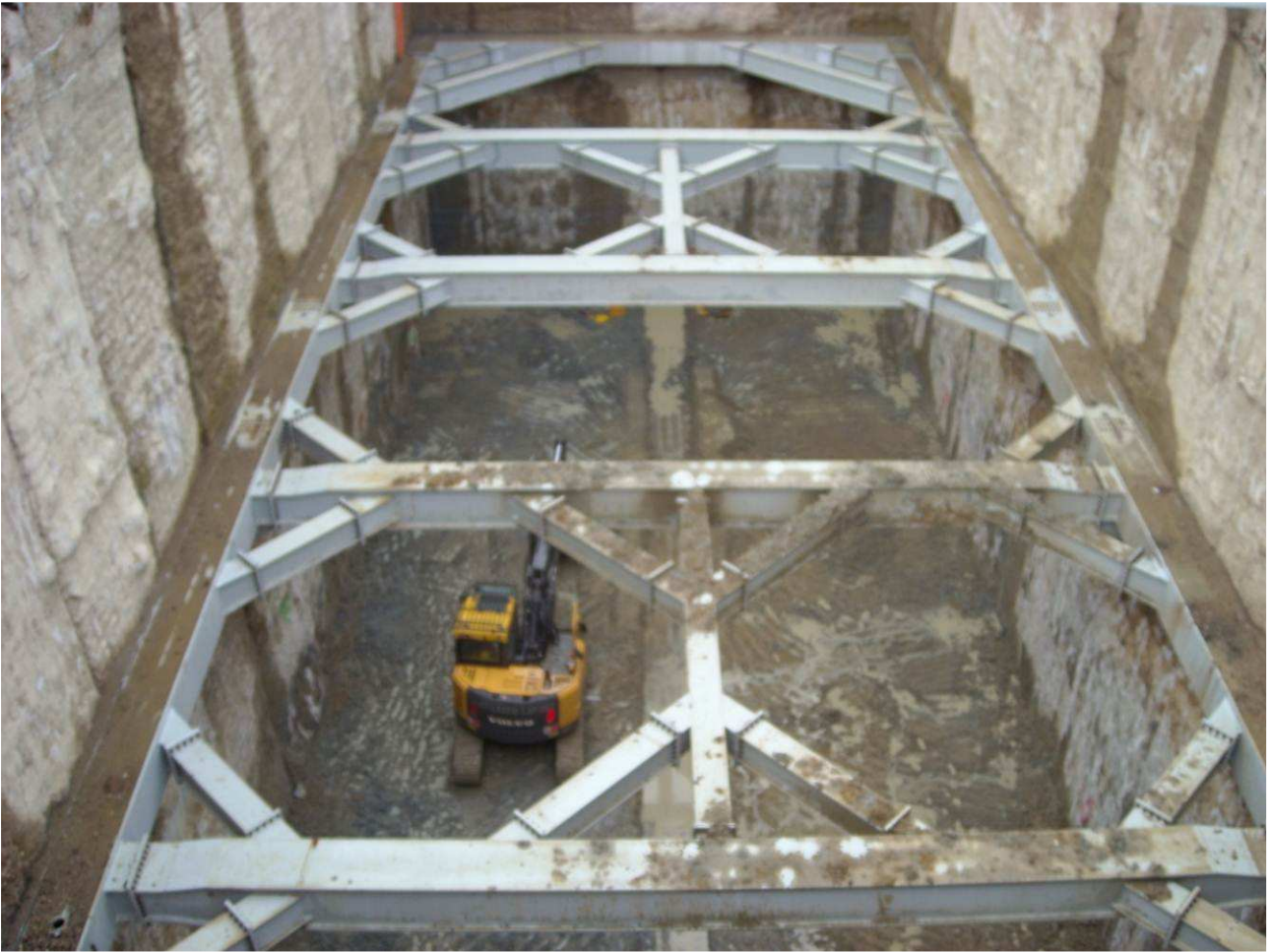
FOTO 3 – Pozzo Nord – 3° scavo da quota 34,60 a 28,20
