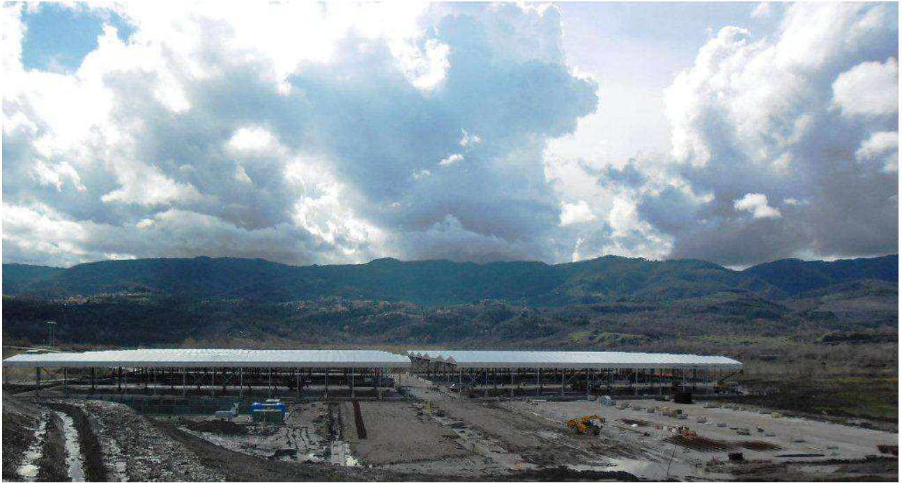
FOTO 2 – Località Bricchette – Piazzole di stoccaggio Fase 2
