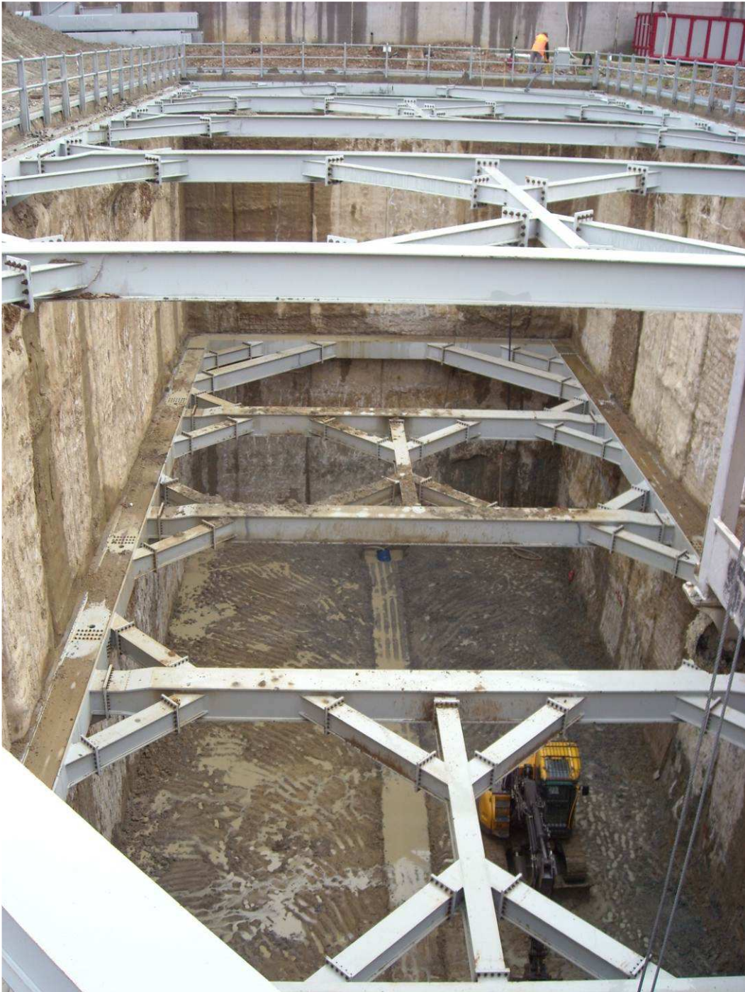
FOTO 2 – Pozzo Nord – 3° scavo da quota 34,60 a 28,20
