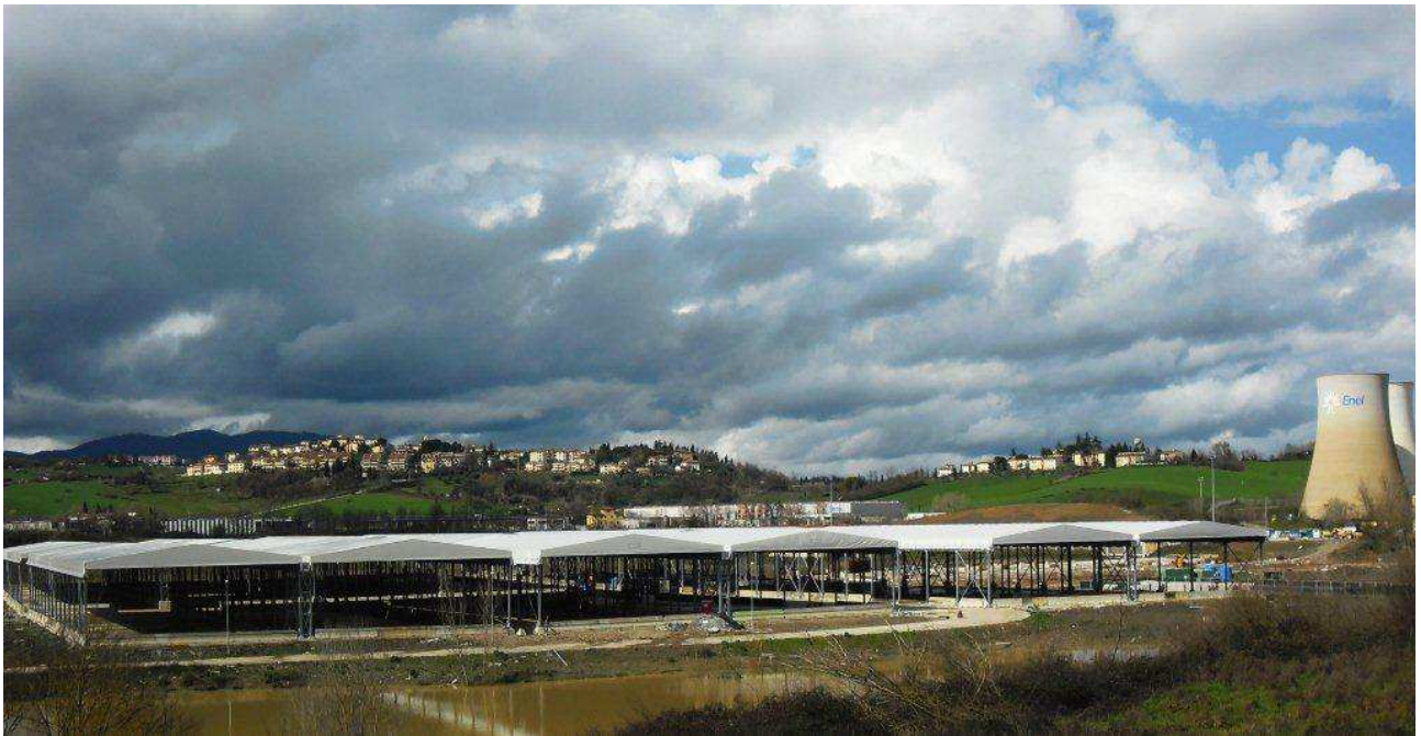
FOTO 1 – Località S.Barbara – Piazzole di stoccaggio Fase 2
