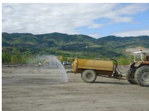
Bagnatura area di cantiere
