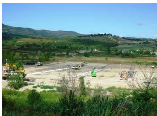
Area realizzazione piazzole di stoccaggio
