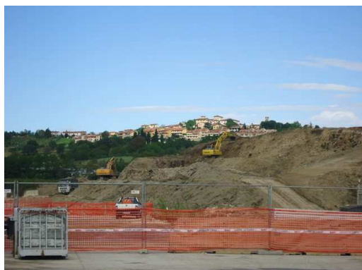
Sbancamento per la realizzazione di due binari
