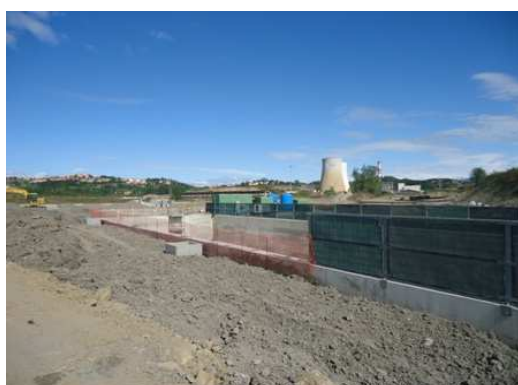
Vasca di accumulo e trattamento acque di dilavamento
