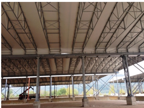
Vista delle piazzole di stoccaggio complete di copertura
