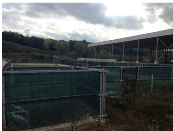
Vista della vasca di accumulo e impianto trattamento acque
