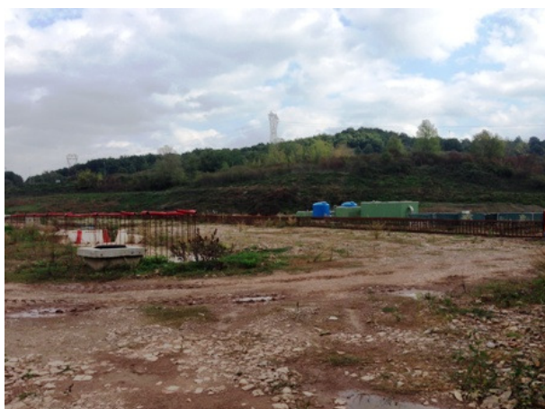
Vista delle piazzole di stoccaggio a livello fondazione
