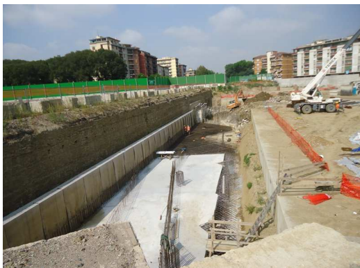
Realizzazione Energy Center
