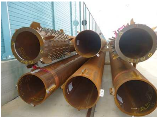
Colonne provvisorie corpo stazione
