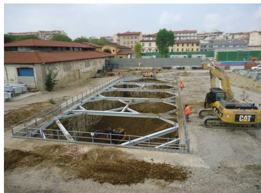
Pozzo di ventilazione Nord
