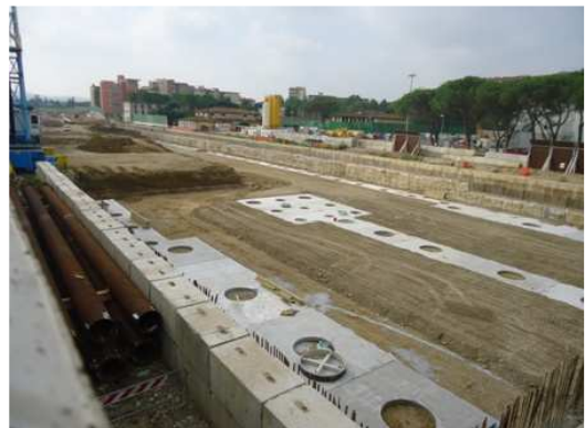
Vista cantiere stazione
