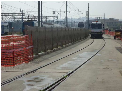
Sistema lavaggio corridoio attrezzato
