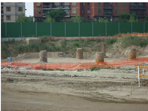
Campo pali pilota e barriere acustiche
