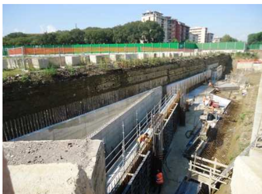
Realizzazione Energy Center
