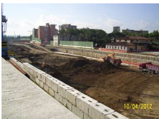
Vista cantiere stazione - Area Camerone
