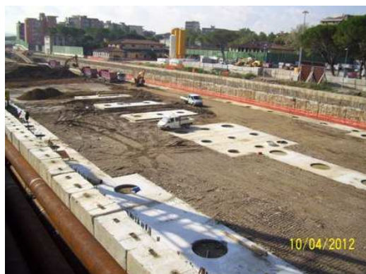
Vista cantiere stazione - Area Camerone
