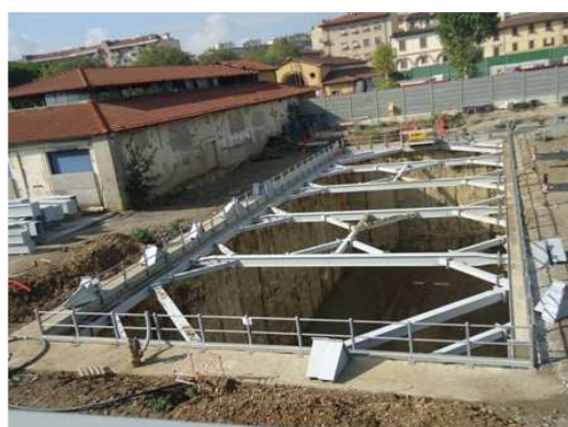
Pozzo di ventilazione Nord
